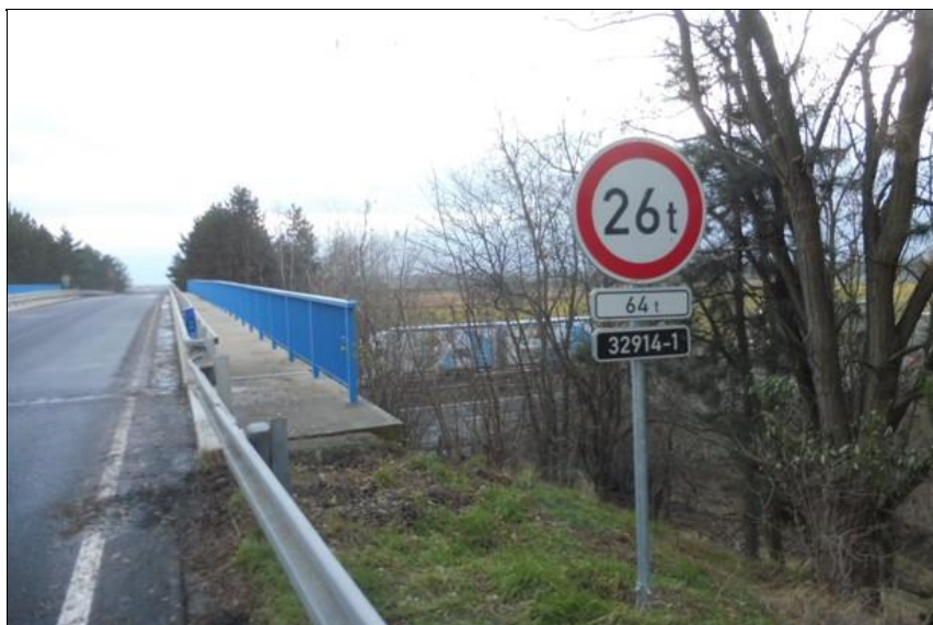
Pravá strana mostu.
