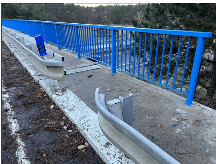
Svodidlo na mostě.
