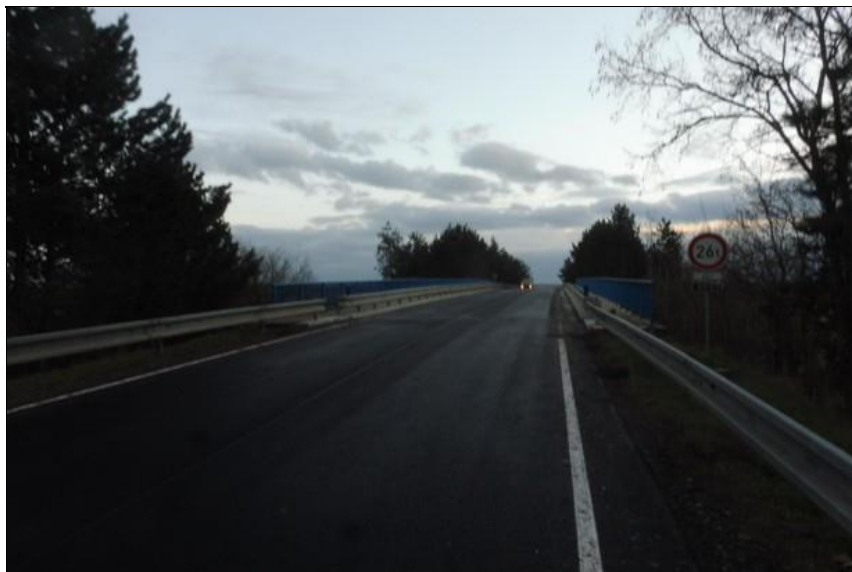
Pohled na most po směru staničení.
