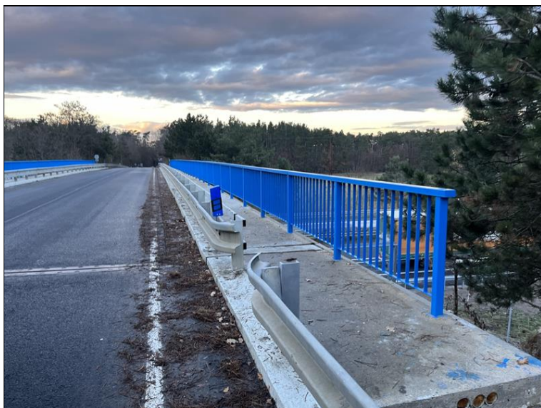
Levá strana mostu.
