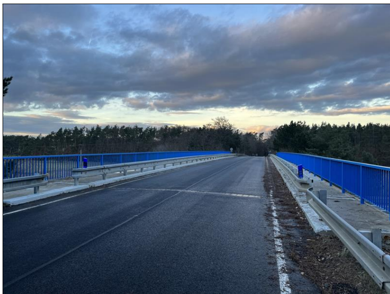
Pohled na most proti směru staničení.
