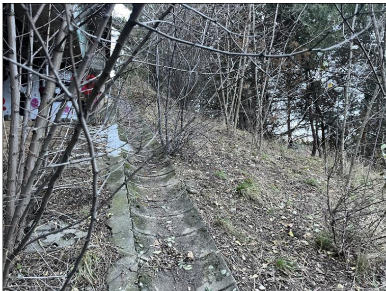
Skluzy odvodnění na mostě.
