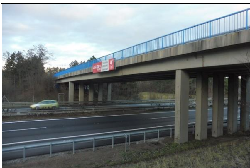
Pohled na most zprava.
