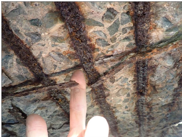
PC270697-2023.12.27_T15.11.jpg Separace krycí vrstvy na pohledu NK.
