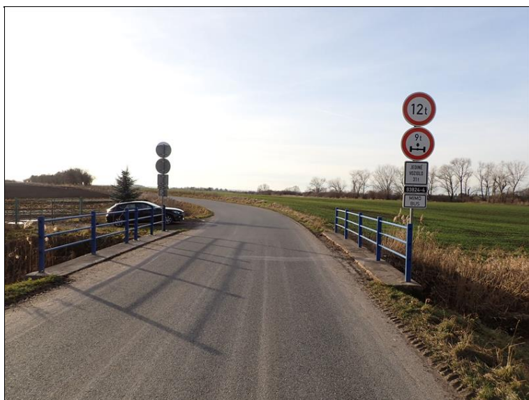
PC270716-2023.12.27_T15.13.jpg Pohled na most proti směru staničení.
