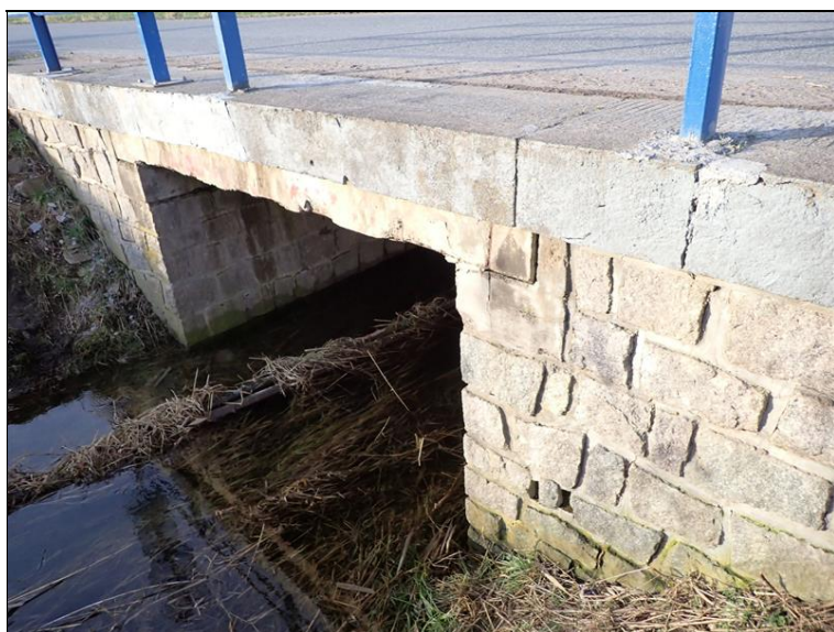
PC270674-2023.12.27_T15.07.jpg Pohled na pravý bok mostu.
