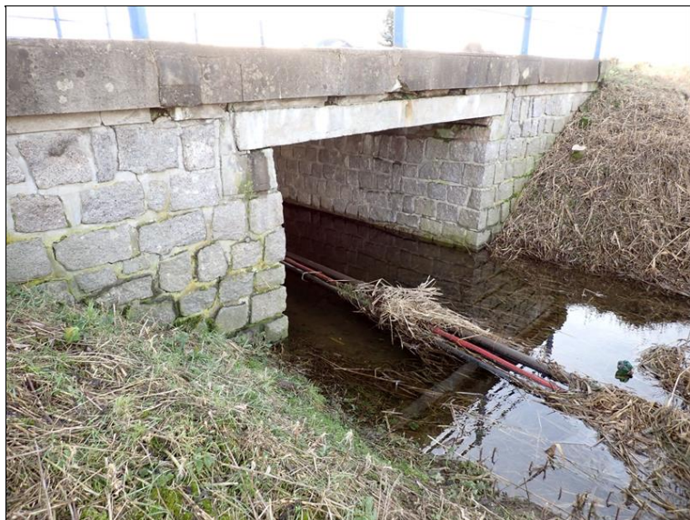
PC270680-2023.12.27_T15.07.jpg Pohled na levý bok mostu.
