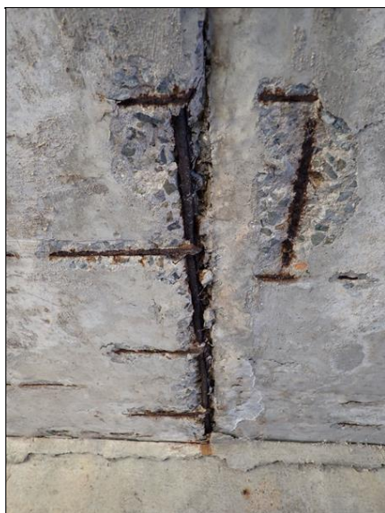
PC270697-2023.12.27_T15.11.jpg Separace krycí vrstvy na pohledu NK.
