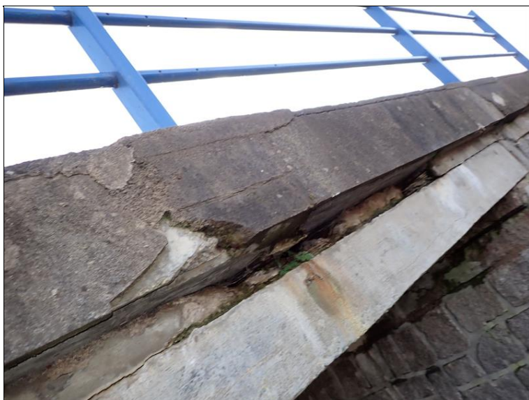
PC270689-2023.12.27_T15.10.jpg Separace krycí vrstvy na pravém krajním nosníku, koroze podélné hlavní nosné výztuže s oslabení cca 10%. Třmínky oslabení až 100 %.
