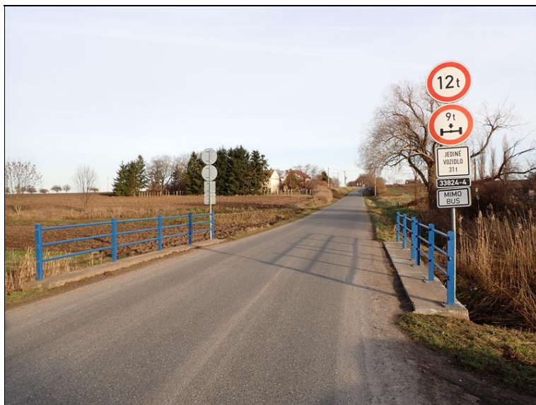
PC270666-2023.12.27_T15.06.jpg Pohled na most ve směru staničení.
