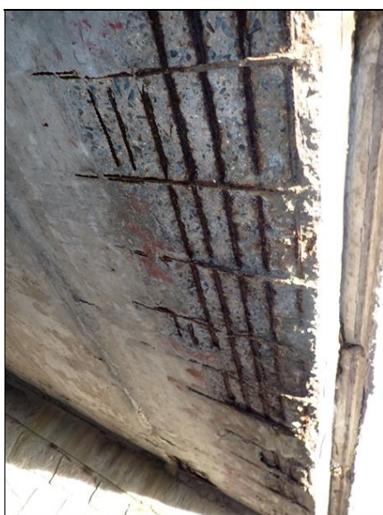
PC270689-2023.12.27_T15.10.jpg Separace krycí vrstvy na pravém krajním nosníku, koroze podélné hlavní nosné výztuže s oslabení cca 10%. Třmínky oslabení až 100 %.
