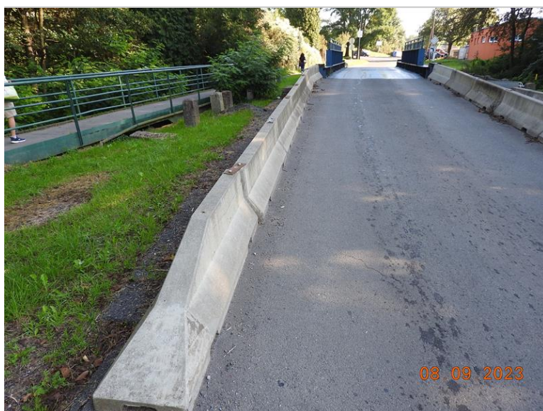
019_Svodidlo vpravo u OP2.jpg
