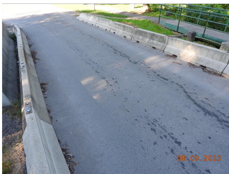
022_Vozovka předpolí OP2. Lokální trhliny a zanesení.jpg
