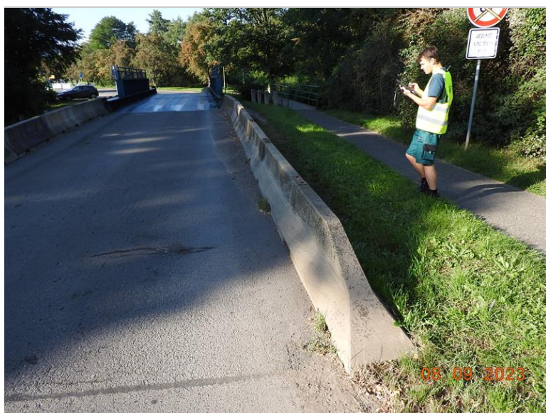
010_Pravé svodidlo předpolí OP1. Osadit sloupek Z4.jpg
