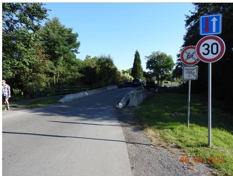
001_Šírkové uspořádání na mostě pohled proti směru staničení.jpg
