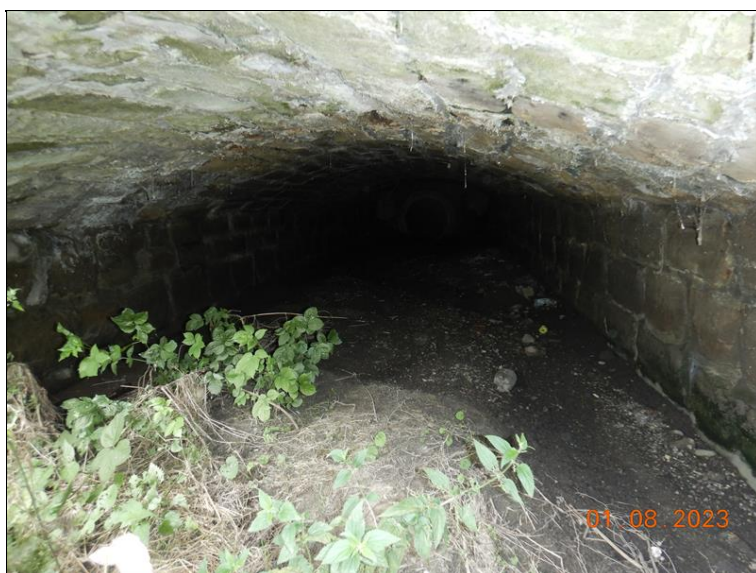
010_Prostor pod mostem. .jpg
