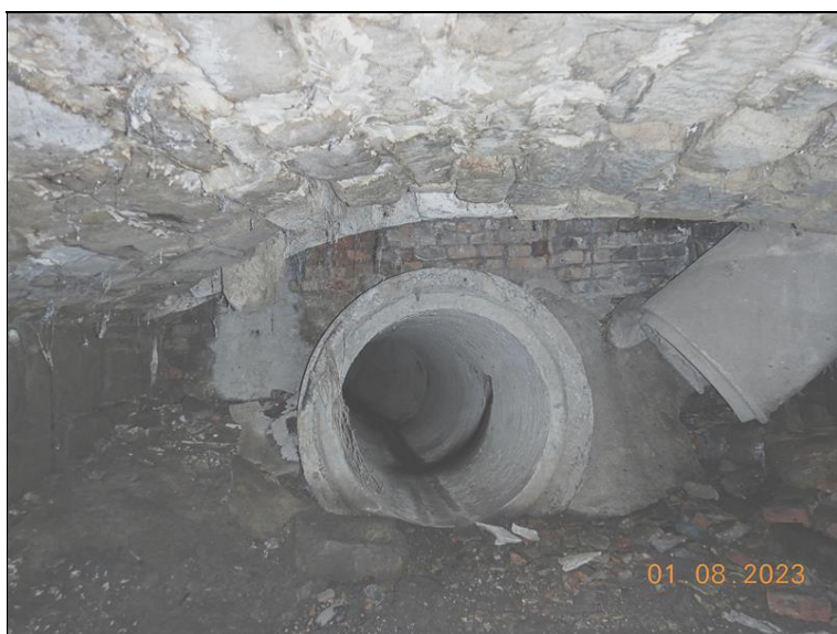
017_Podhled vyústění do kolektoru. .jpg
