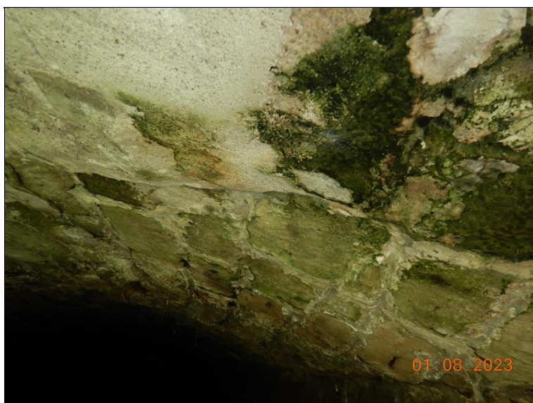
013_Pohled NK klenby detail. Vlhké zdivo výluhy bionapadení povrchová degradace zdiva..jpg
