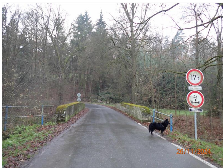
02 proti směru staničení.JPG
