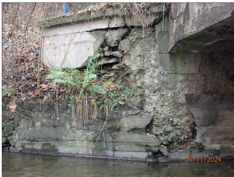
10 OP1 pravé křídlo.JPG
