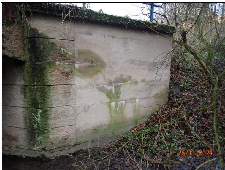
13 OP2 pravé křídlo.JPG
