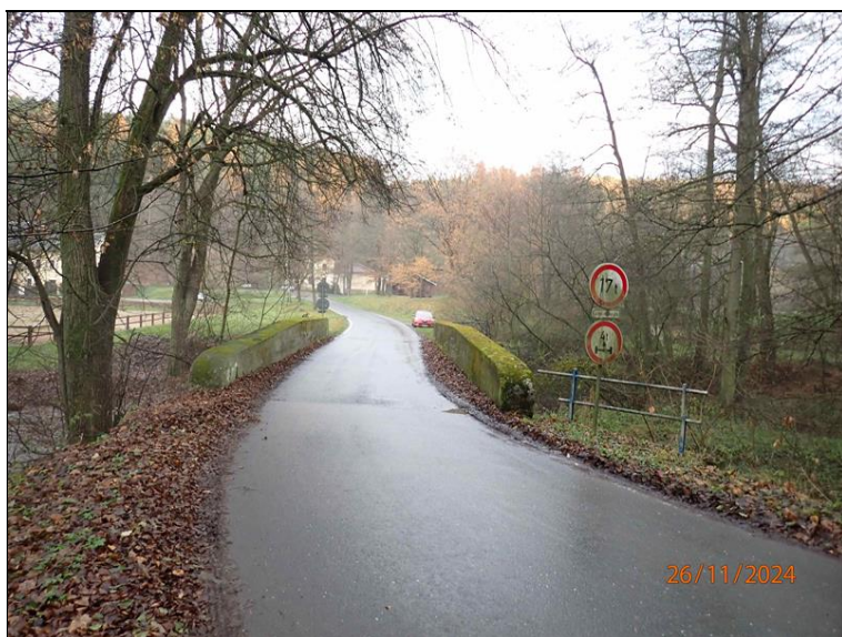
01 po směru staničení.JPG
