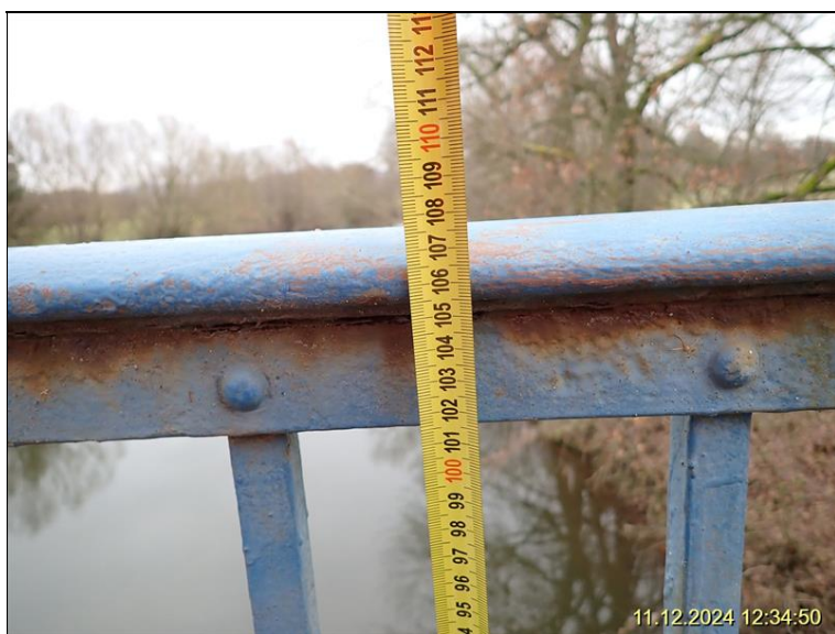
093 - výška zábradlí.JPG
