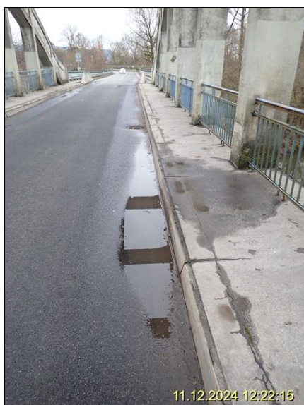
051 - levý kraj vozovky.JPG
