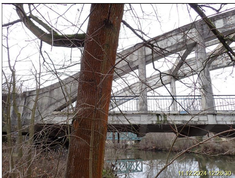
063 - pohled na most zprava.JPG
