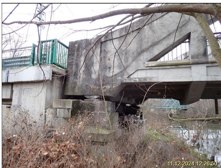
066 - uložení mostu na O1 vpravo.JPG
