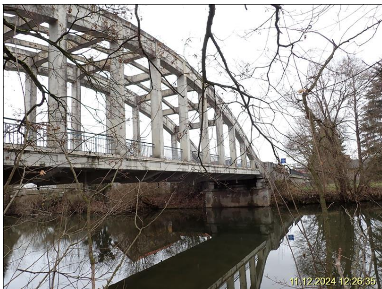
065 - pohled na most zprava.JPG
