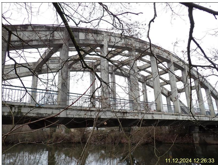
064 - pohled na most zprava.JPG
