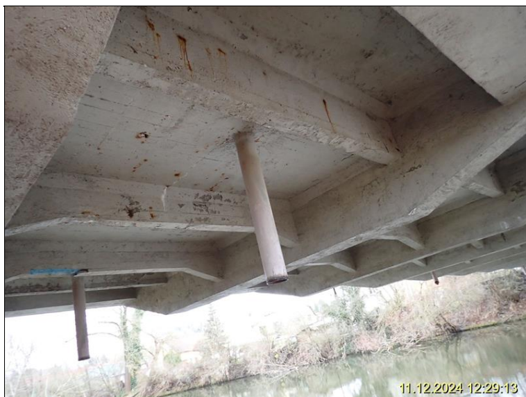
083 - odvodnění NK.JPG
