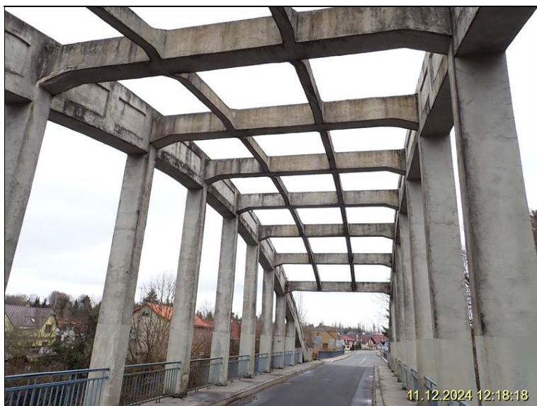
018 - pohled na NK od O1.JPG
