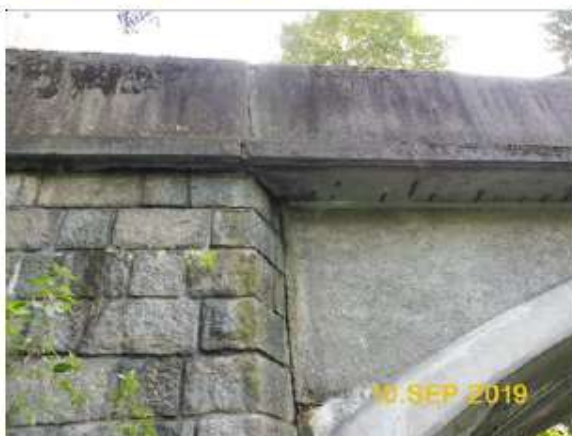
KŘ1P a čelní zeď v P (trhlina na styku).
