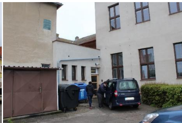
Obr. 41: Pohled ze dvora – Budova č.p. 6
