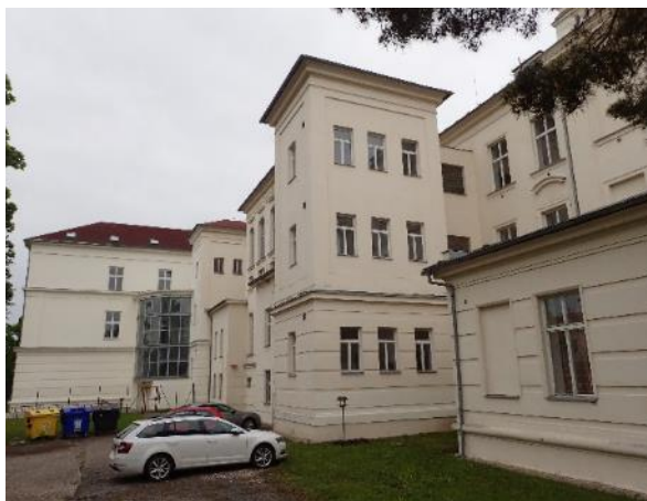
Obr. 29: Fasáda do dvora
