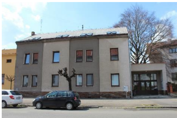
Obr. 13: Pohled III – budova B
