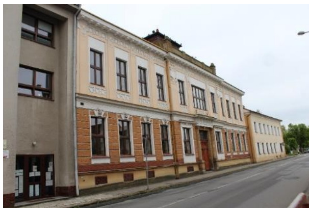
Obr. 38: Pohled z ulice - Budova č.p. 4
