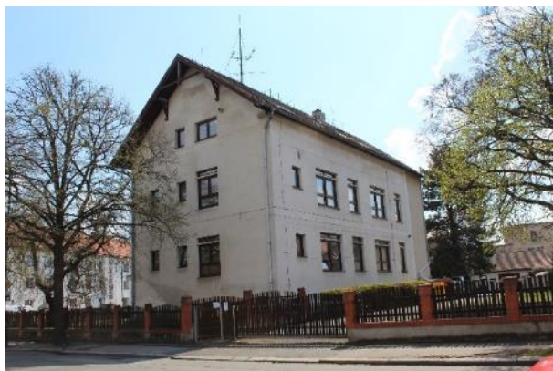
Obr. 11: Pohled I – budova A
