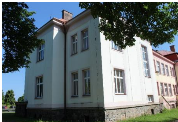
Obr. 3: Pohled II - škola
