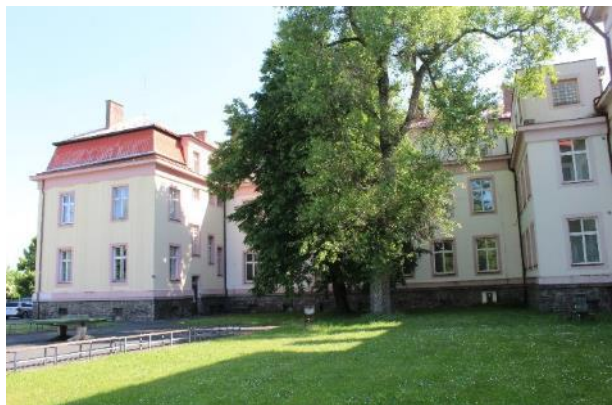
Obr. 2: Pohled I - škola
