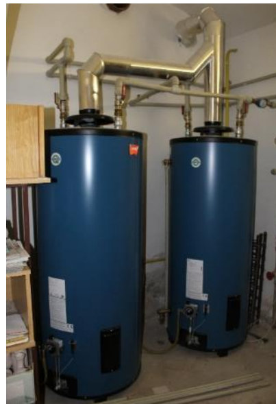
Obr. 26: Centrální příprava TV
