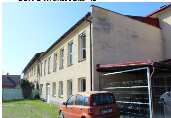
Obr. 56: Pohled ze dvora JV
