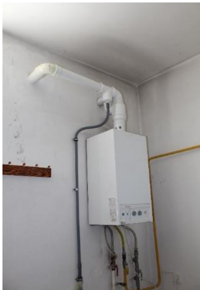
Obr. 25: Nástěnný kotel
