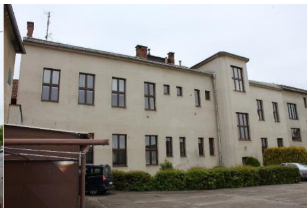
Obr. 39: Pohled ze dvora – Budova č.p. 4
