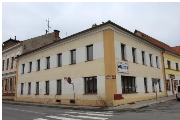
Obr. 40: Pohled z ulice – Budova č.p. 5
