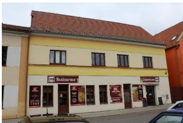
Obr. 42: Pohled z ulice – Budova č.p. 6
