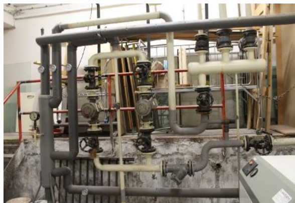
Obr. 24: HVDT, otopný okruh, rozdělovač ÚT
