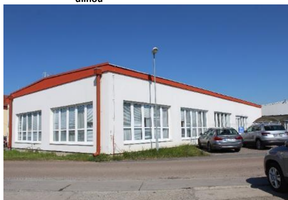
Obr. 48: Budova učeben ateliérů
