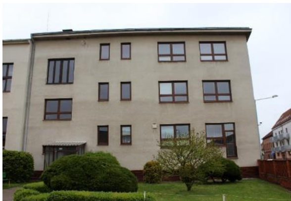
Obr. 37: Pohled ze dvora – Budova č.p. 3
