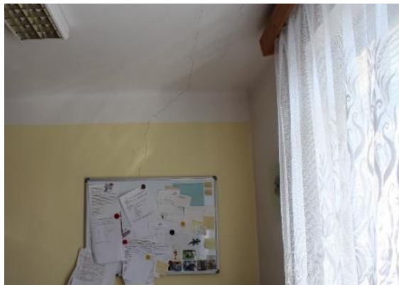
Obr. 57: Trhliny
