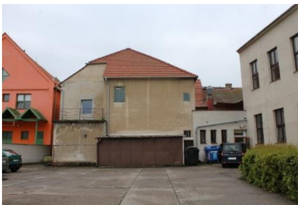
Obr. 43: Pohled ze dvora – Budova č.p. 6
