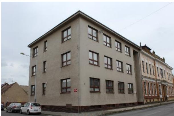
Obr. 36: Pohled z ulice – Budova č.p. 3
