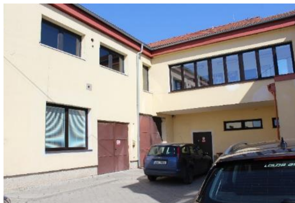
Obr. 46: Krček mezi technolog. budovou a budovou s šicí dílnou
