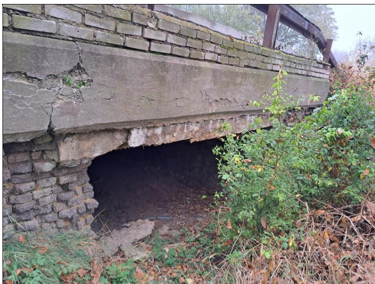
Bližší pohled na levou stranu mostu.
