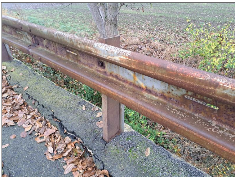
Svodidlo na mostě.
