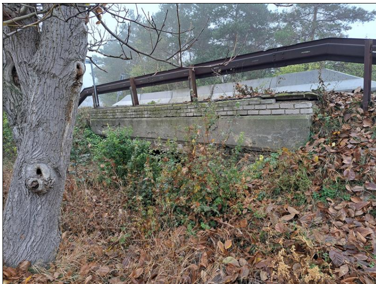
Pohled na levou stranu mostu.
