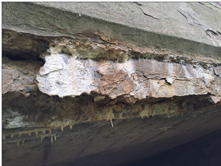
Kraj NK a podhled římsy.
