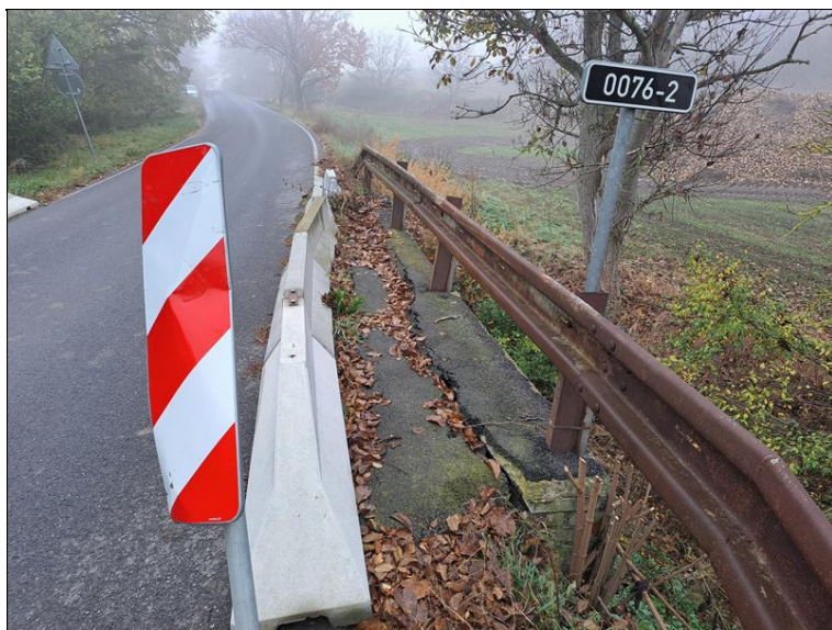
Římsa a svodidla na mostě.
