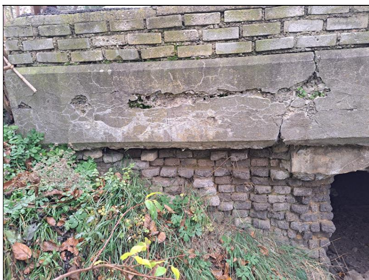
Římsa z vnější strany mostu (nos).
