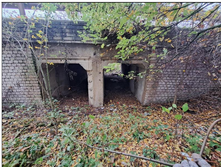
Pohled na pravou stranu mostu.
