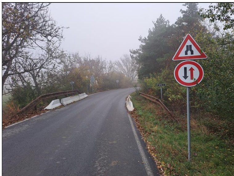
Pohled ve směru staničení.
