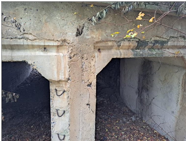
Pohled na prefabrikované rozšíření.
