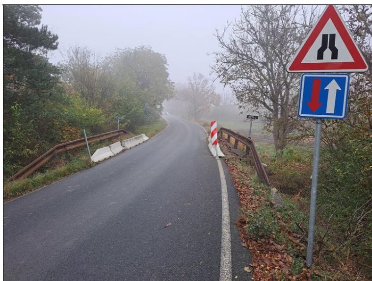
Pohled proti směru staničení.
