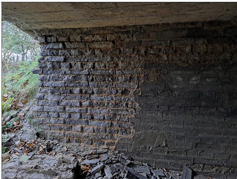
Pohled na OP2 - levá strana.
