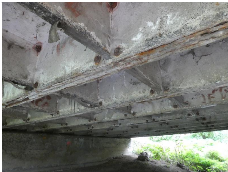
Podhled NK ve 2. poli.
