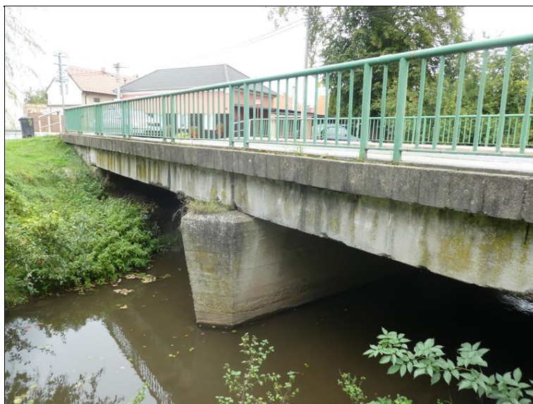
Pohled na most zprava.
