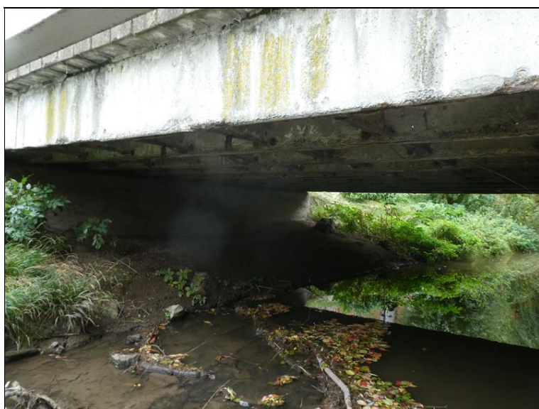
2. mostní otvor zleva.
