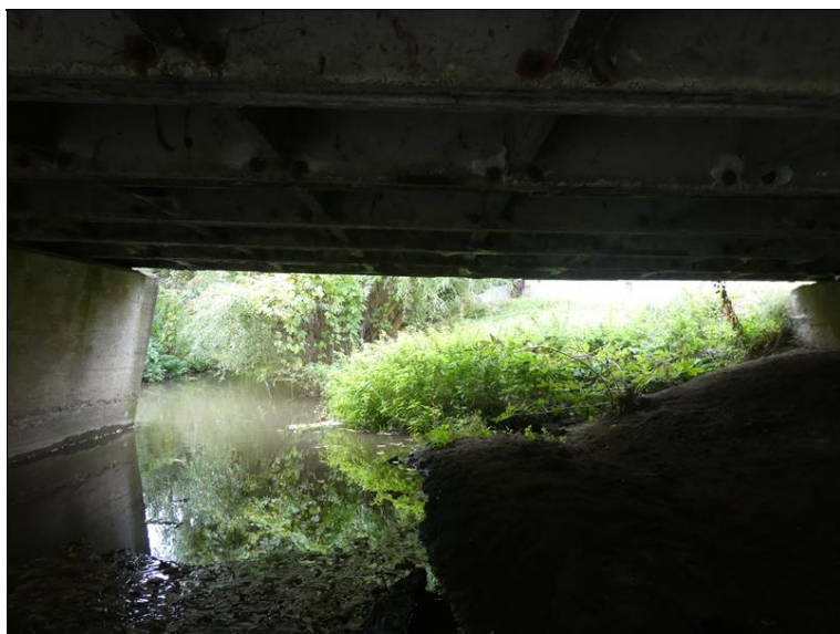
1. mostní otvor zleva.
