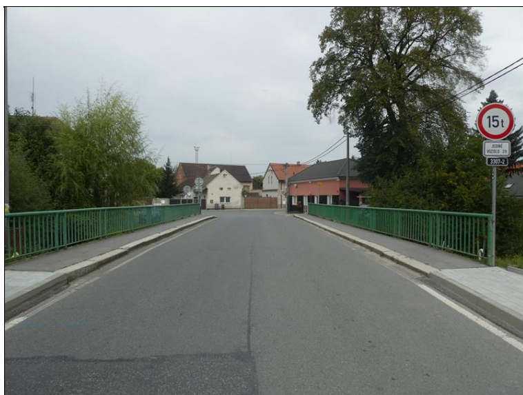
Pohled na most proti směru staničení.
