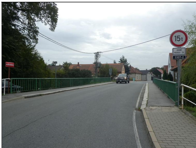
Pohled na most po směru staničení.
