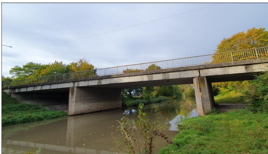
Pohled na most zprava.
