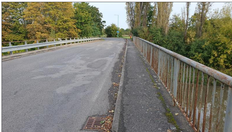
Krajnice + chodník + římsa + zábradlí P.
