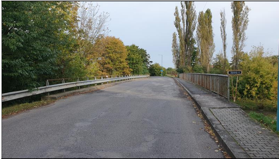
Pohled na most po směru staničení.
