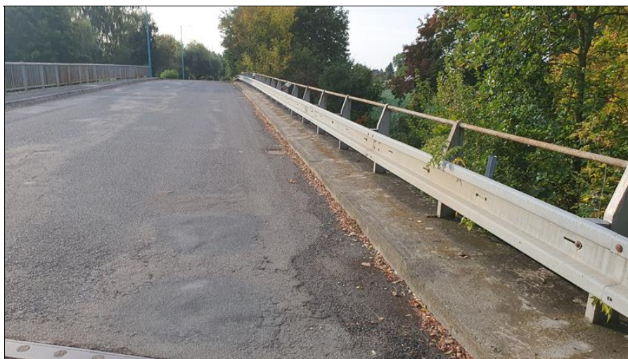
Krajnice + římsa + zábradelní svodidlo L.
