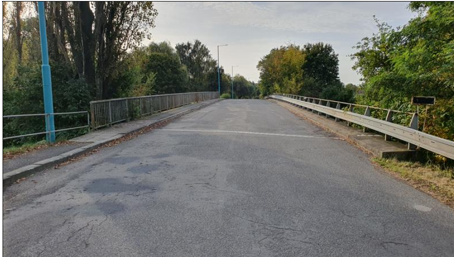
Pohled na most proti směru staničení.
