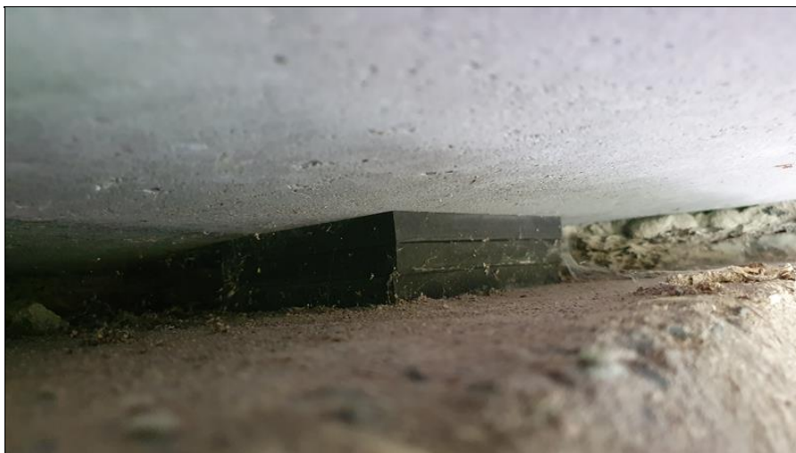
Elastomerové ložisko OP1P.
