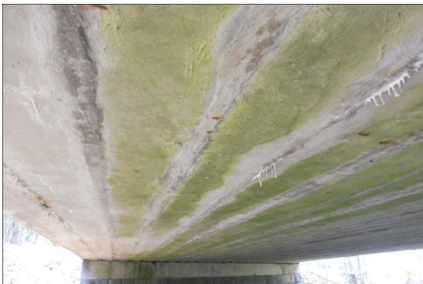
Pohled na spodek nosné konstrukce.
