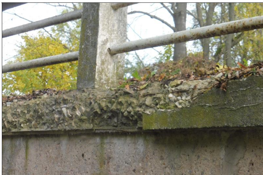
Rozpad římsy.
