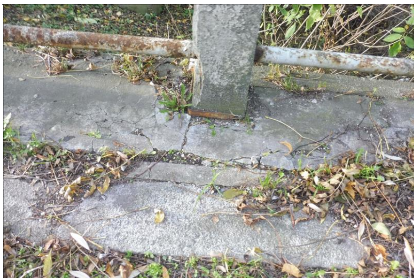
Horní povrch římsy.
