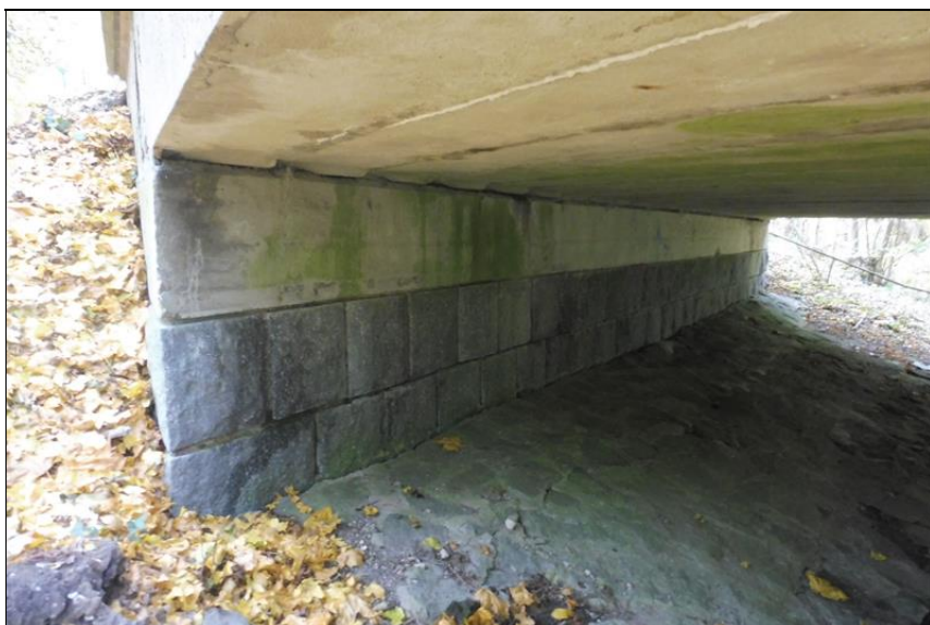
Pohled na opěru 1.
