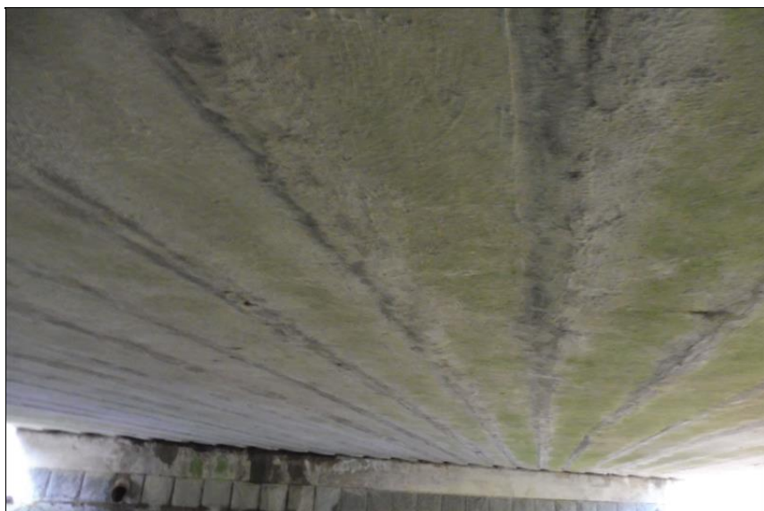
Pohled na spodek nosné konstrukce.
