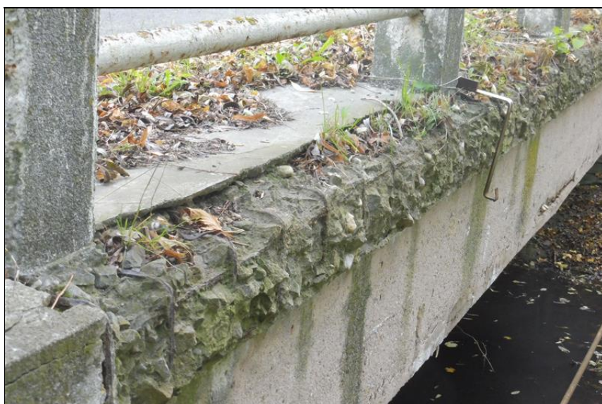
Rozpad římsy.
