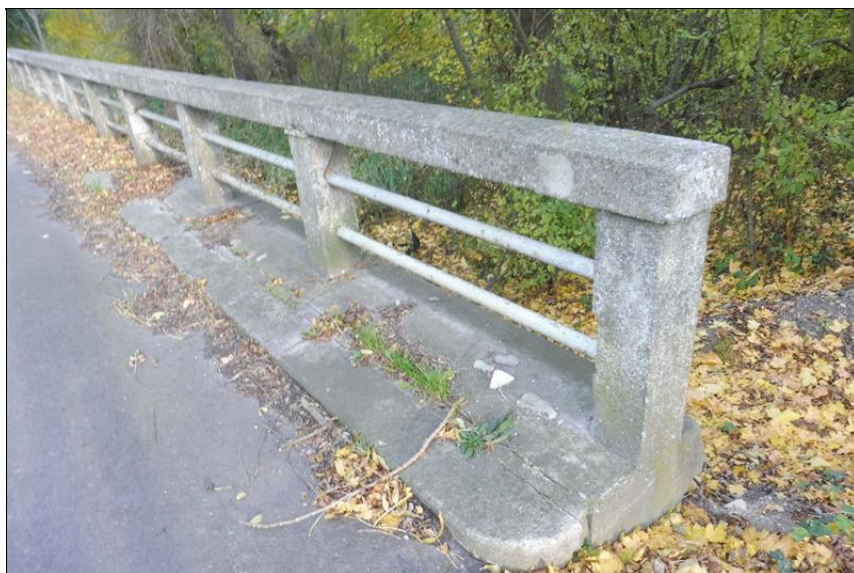
Pohled na pravou stranu mostu.
