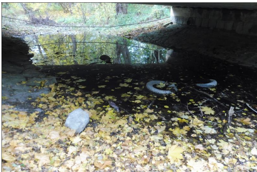
Průhled mostním otvorem.
