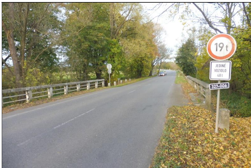
Pohled na most po směru staničení.
