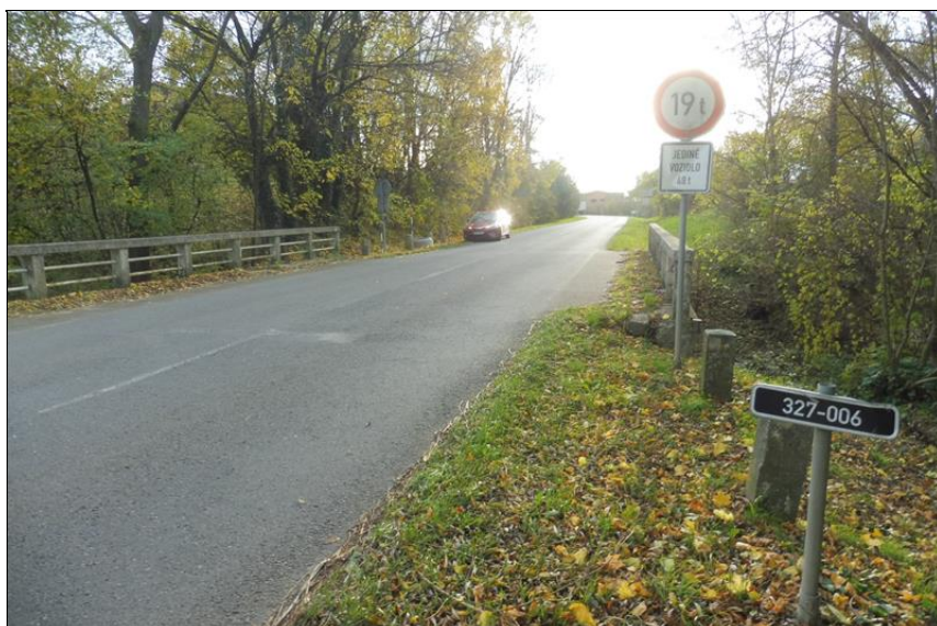
Pohled na most proti směru staničení.
