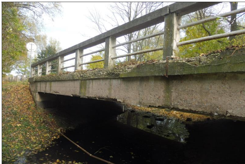
Pohled na bok římsy a nosné konstrukce.
