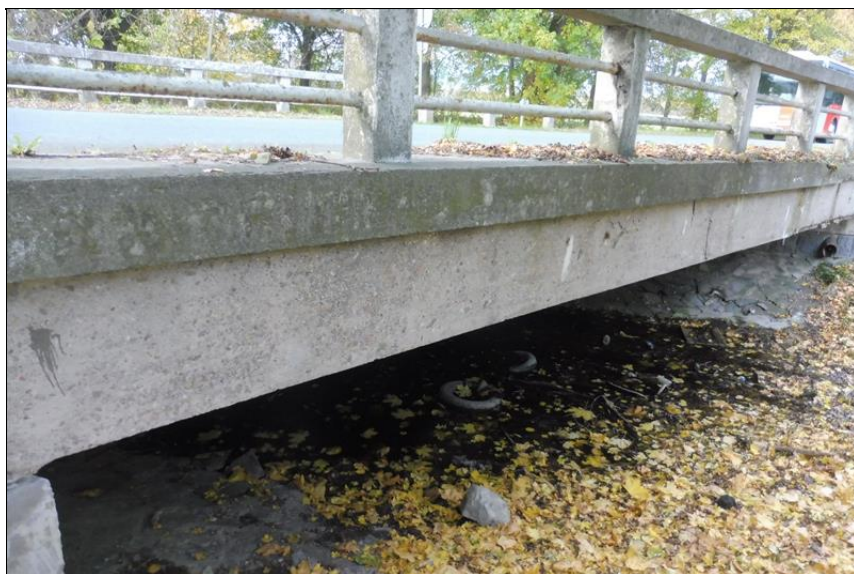
Pohled na most zprava.
