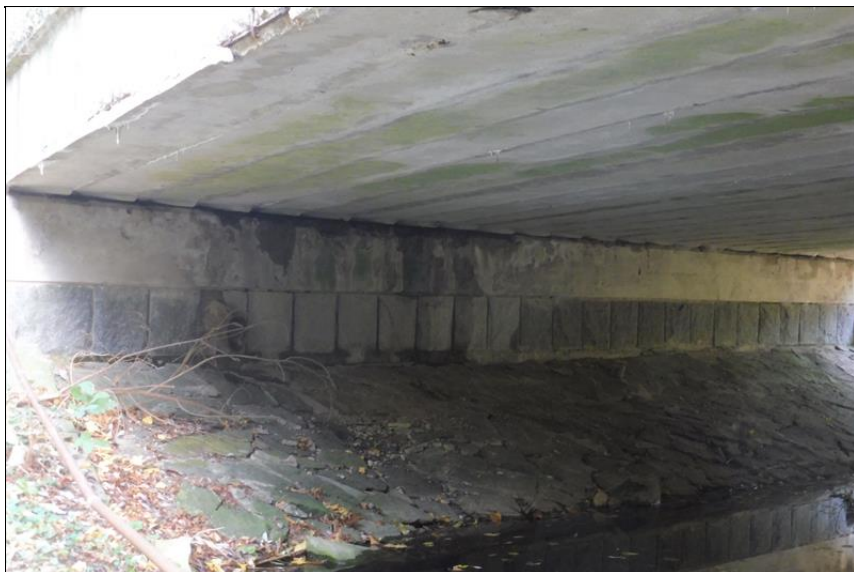
Pohled na opěru 2.
