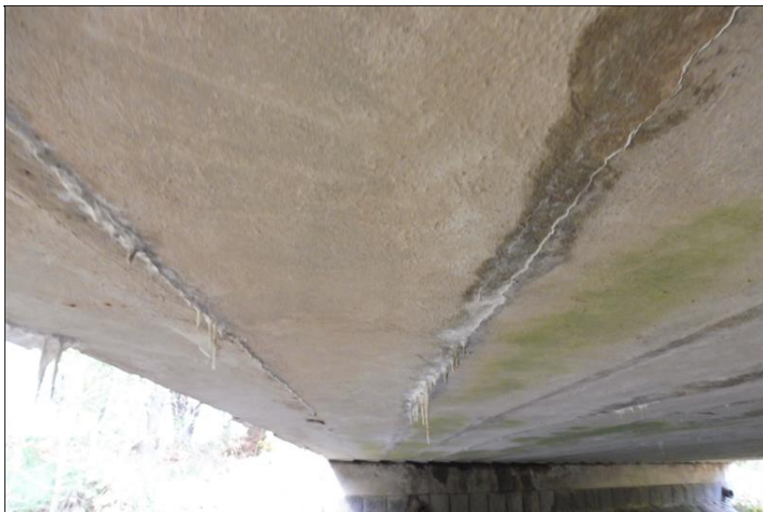
Pohled na spodek nosné konstrukce.
