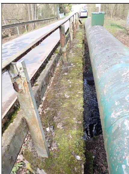
Pohled na římsu na levé straně mostu - silně obrostlá vegetací, silná koroze zábradelního svodidla.
