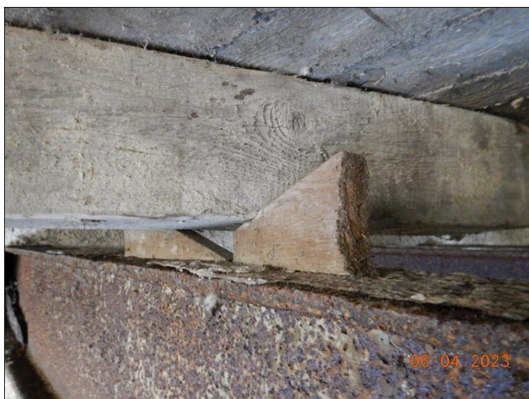
Detail způsobu aktivace dřevěných příčníků a ocelových podélných nosníků.
