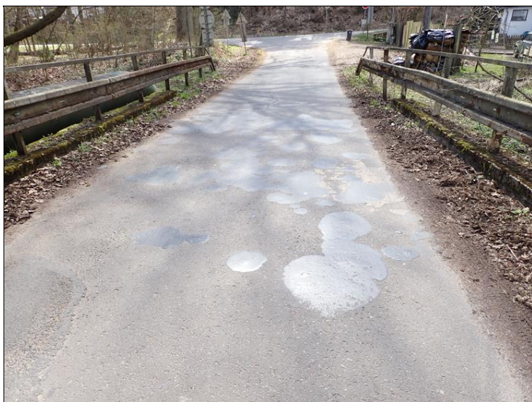
Pohled na římsu na levé straně mostu - silně obrostlá vegetací, silná koroze zábradelního svodidla.
