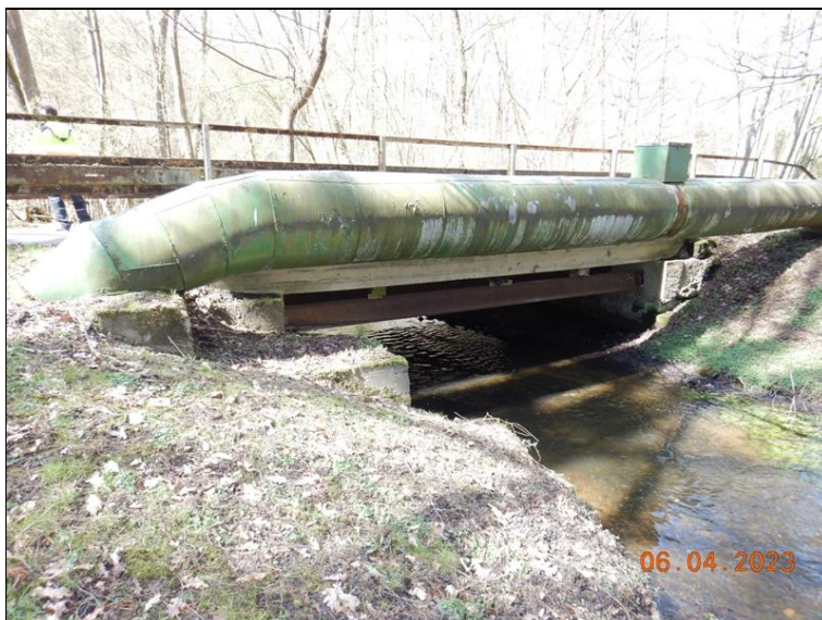
Celkový pohled na levou stranu mostu.
