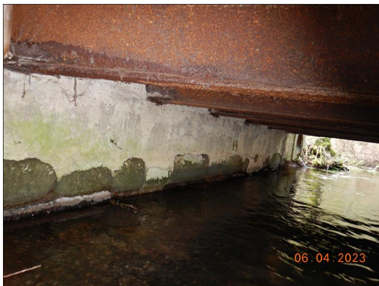
Pohled na opěru O2.
