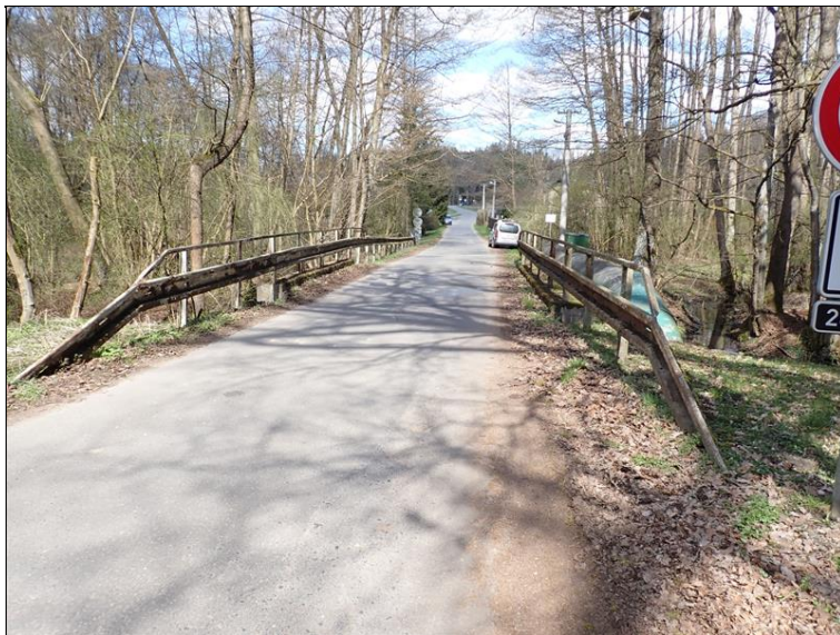
Celkový pohled proti směru staničení.
