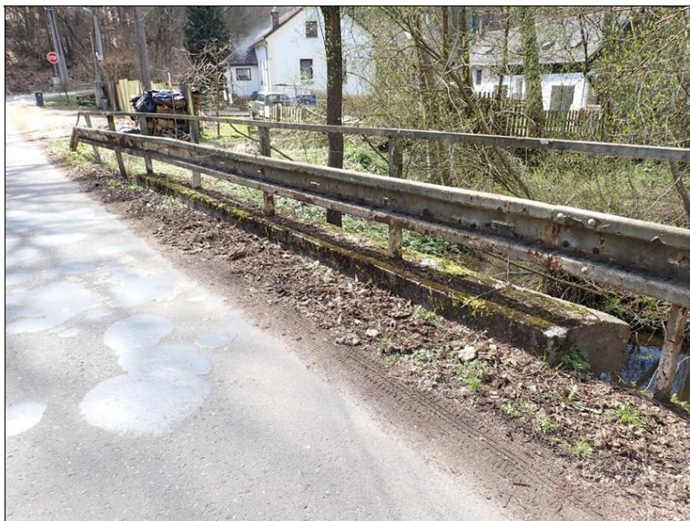
Celkový pohled na svodidlo na mostě na pravé straně.
