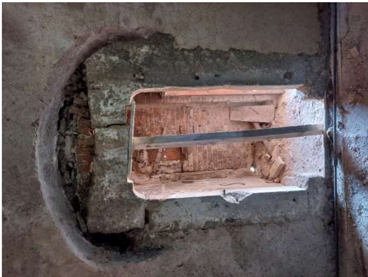
Obrázek 48 - Ostění dveří D.22
