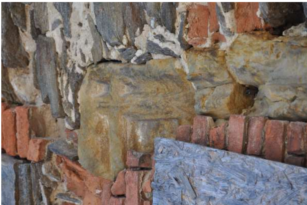
Obrázek 38 - Fragment kamenného ostění o okenního otvoru č. O.23, stav v roce 2024
