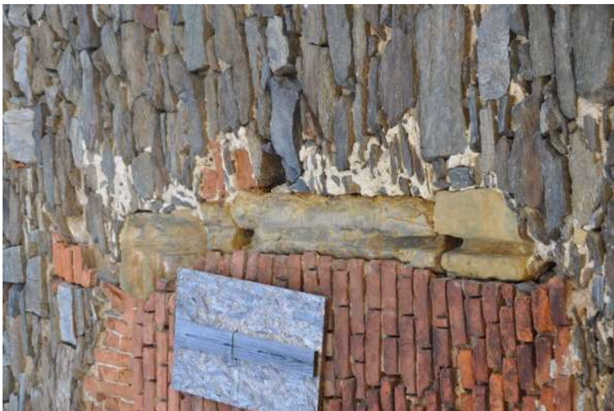
Obrázek 37 - Fragment kamenného ostění o okenního otvoru č. O.23, stav v roce 2024
