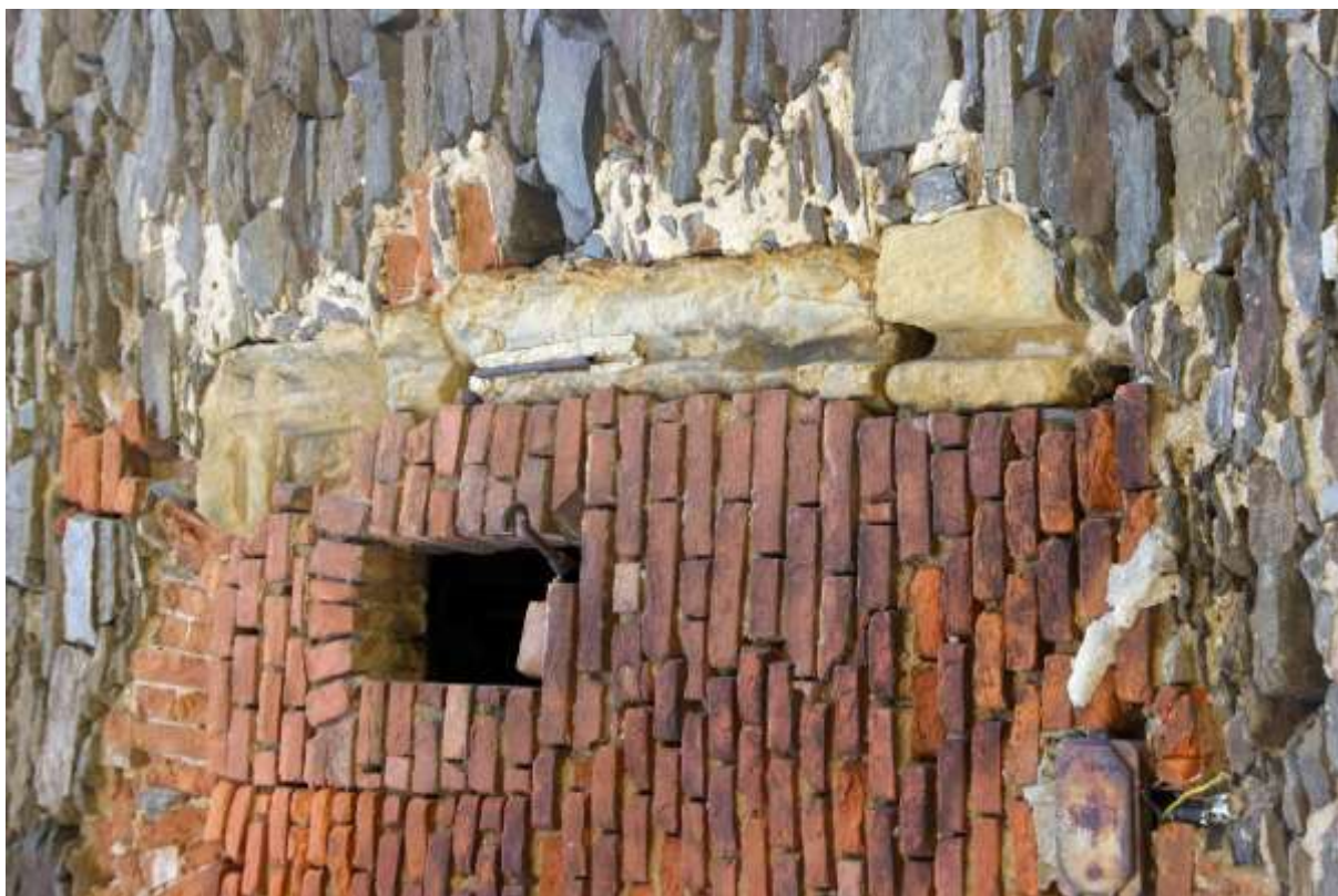
Obrázek 40 - Fragment kamenného ostění o okenního otvoru č. O.23, stav v roce 2014
