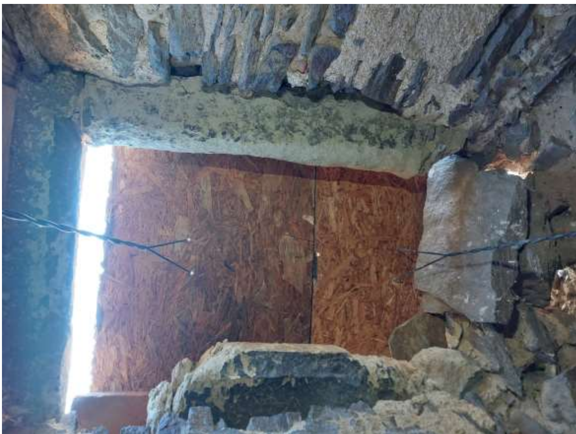
Obrázek 45 - Kamenné ostění, pohled z interiéru
