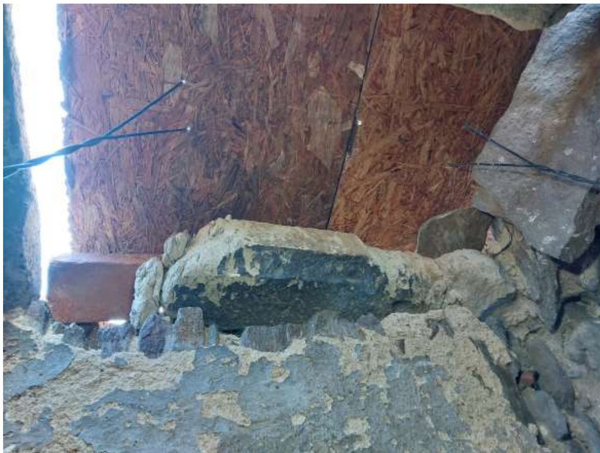
Obrázek 46 - Kamenné ostění, pohled z interiéru
