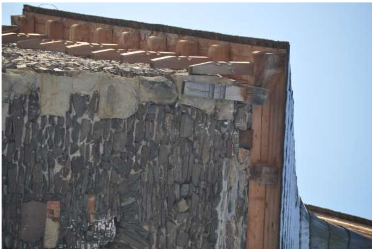
Obrázek 9 - Levé nároží, vrchní část
