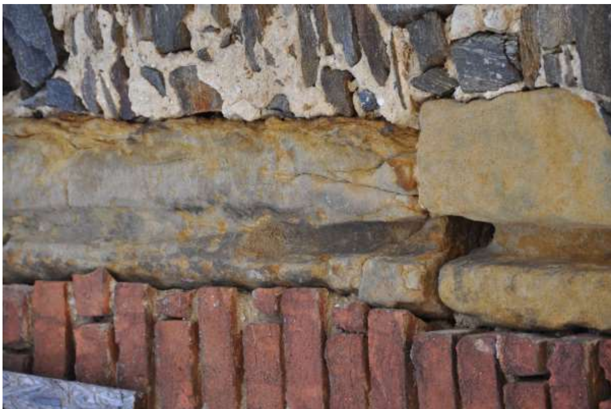
Obrázek 39 - Fragment kamenného ostění o okenního otvoru č. O.23, stav v roce 2024
