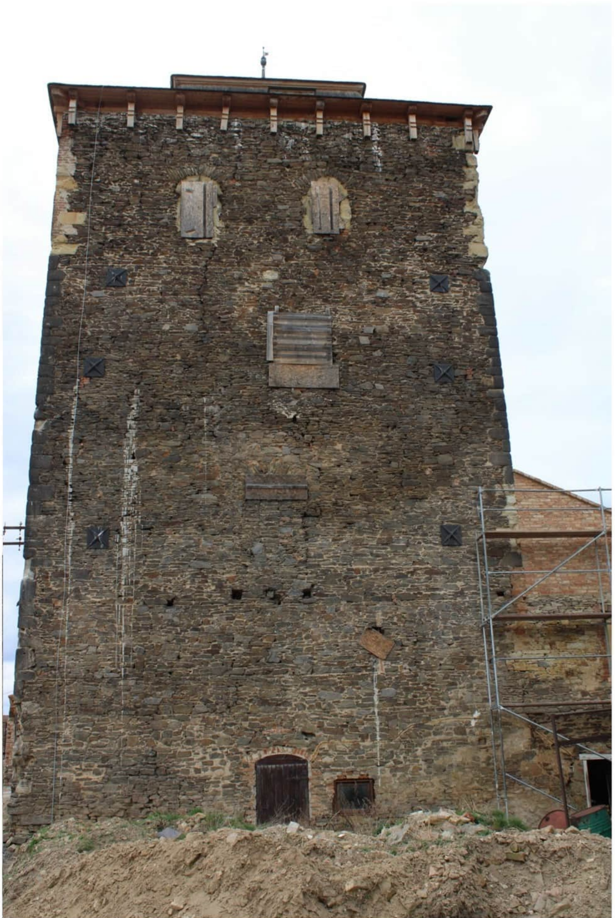
Stav v průběhu rekonstrukce
