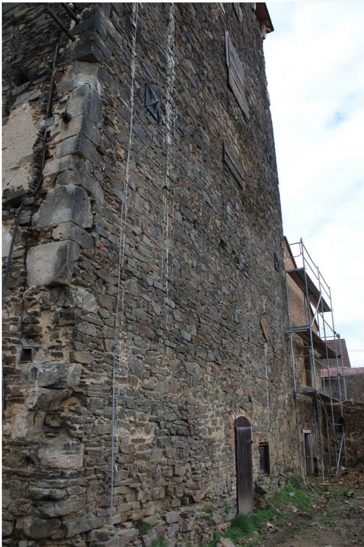
Stav v průběhu rekonstrukce
