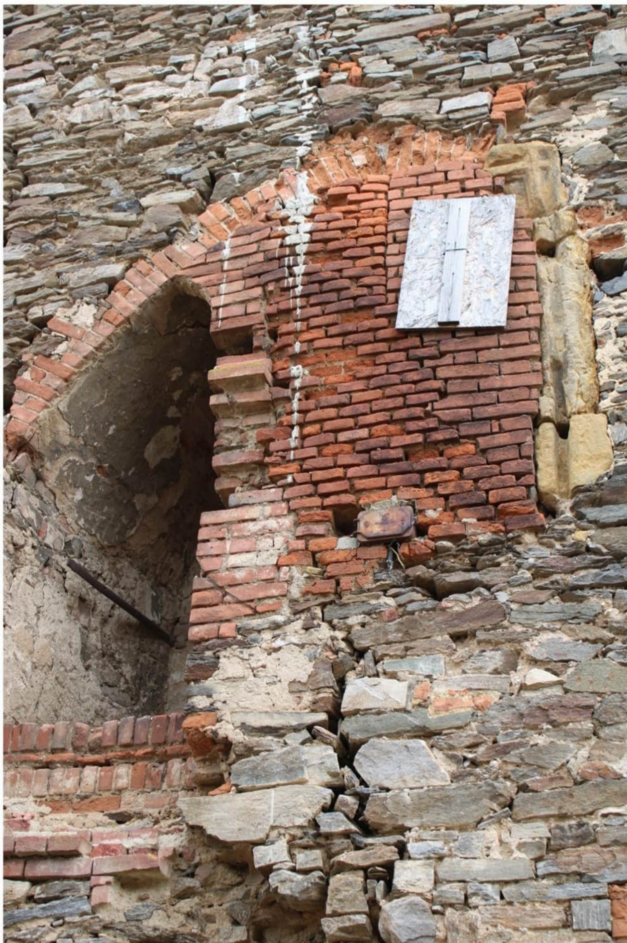
Stav v průběhu rekonstrukce
