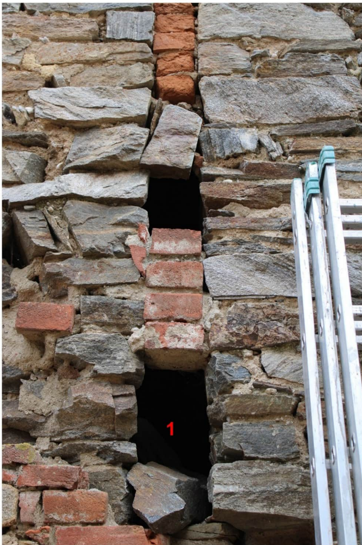
Stav v průběhu rekonstrukce
