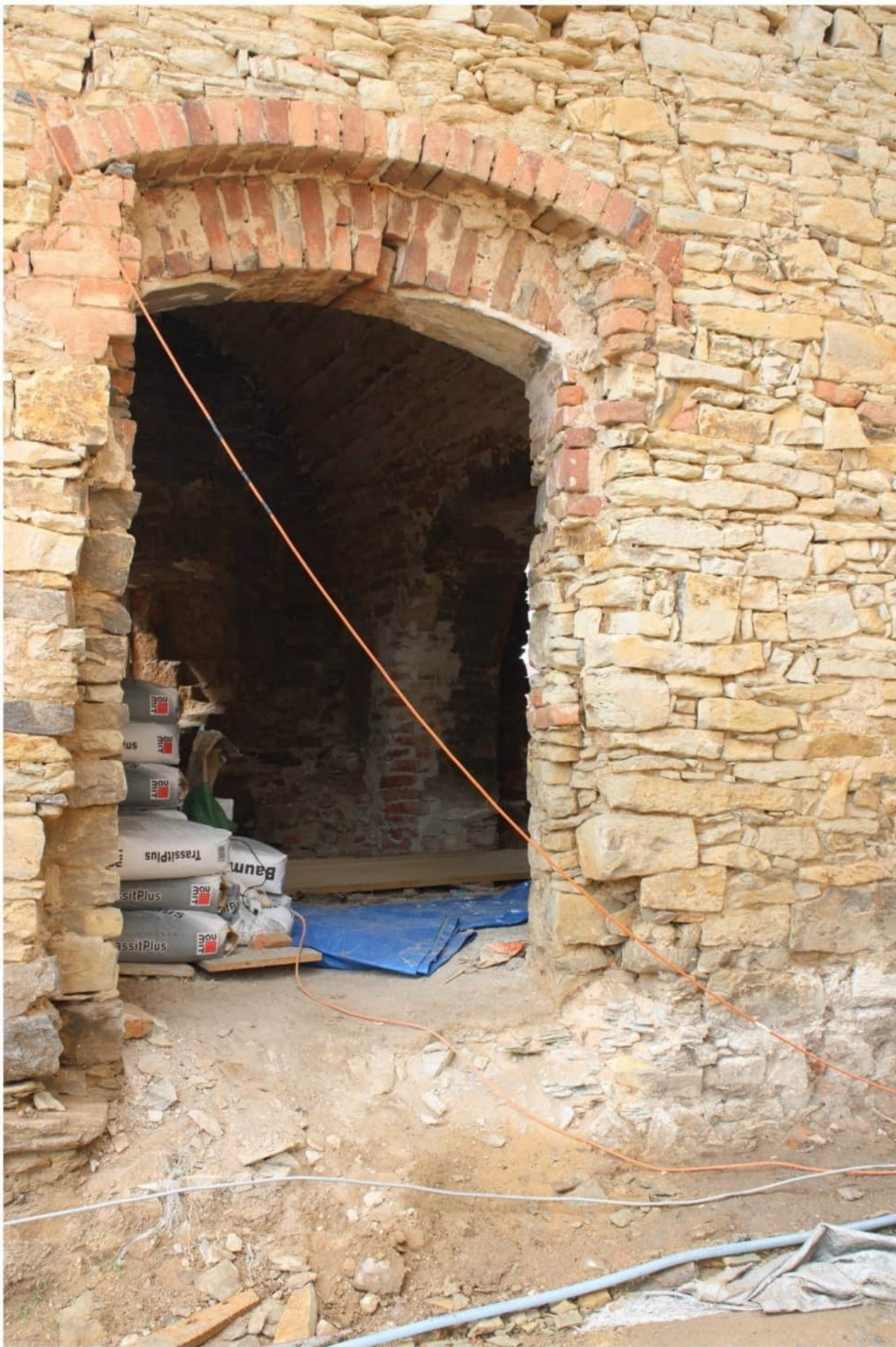
Stav v průběhu rekonstrukce
