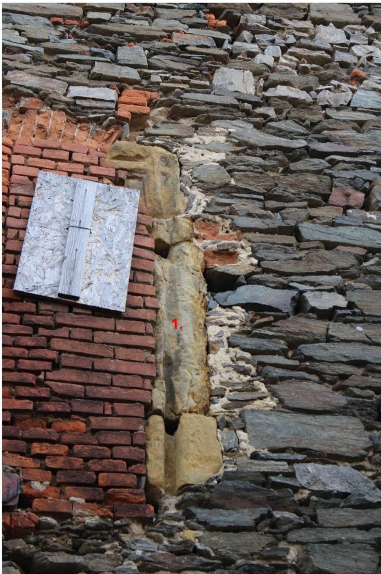
Stav v průběhu rekonstrukce
