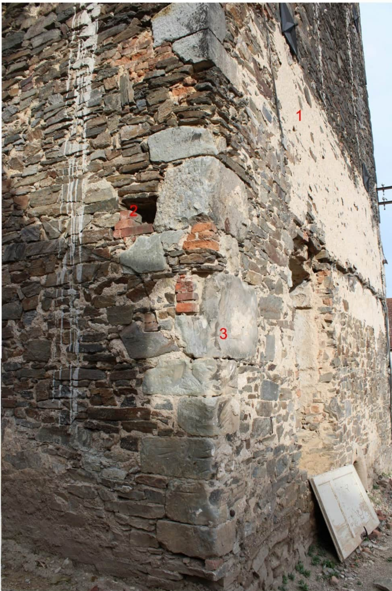
Stav v průběhu rekonstrukce
