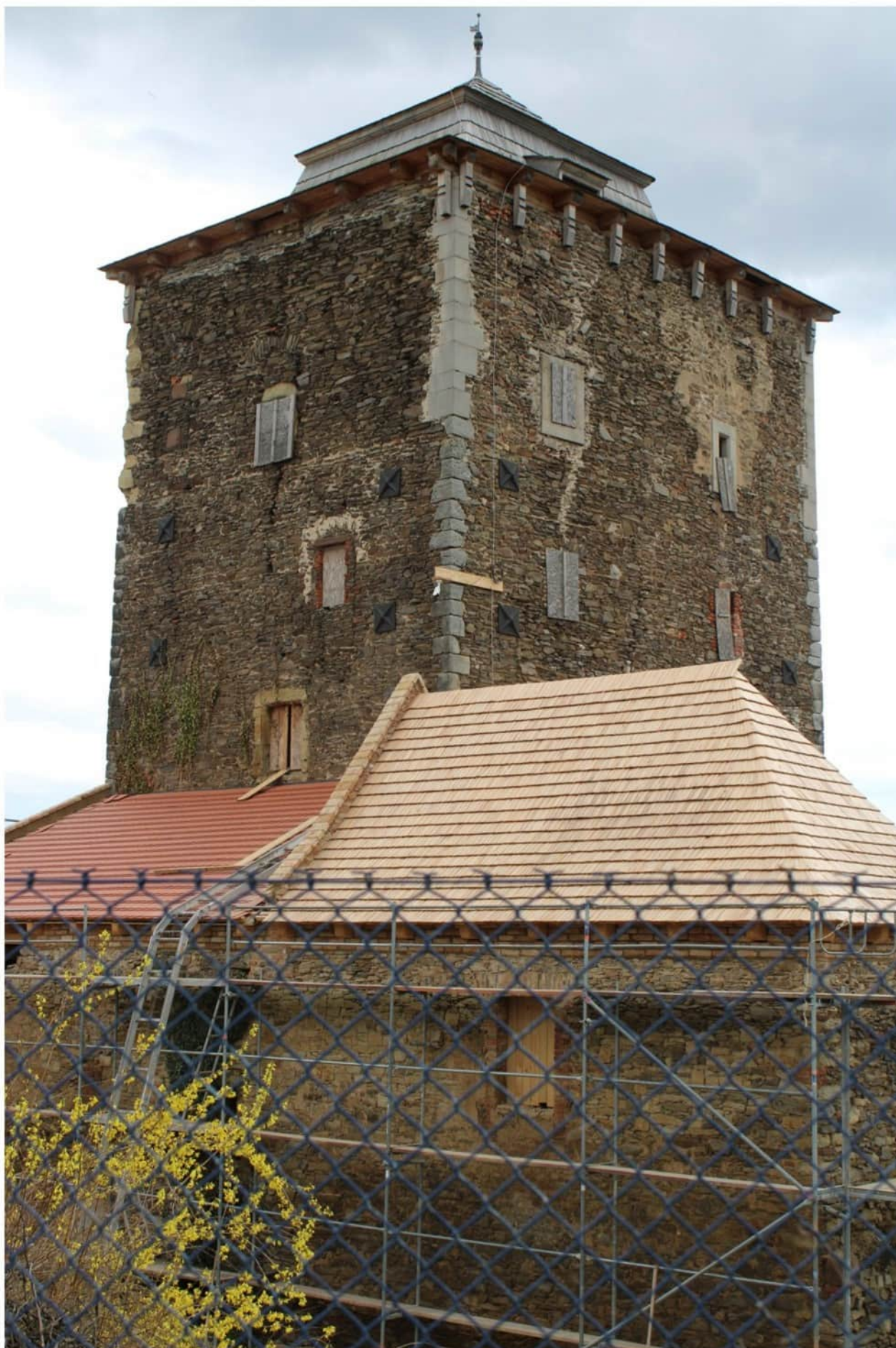
Stav v průběhu rekonstrukce
