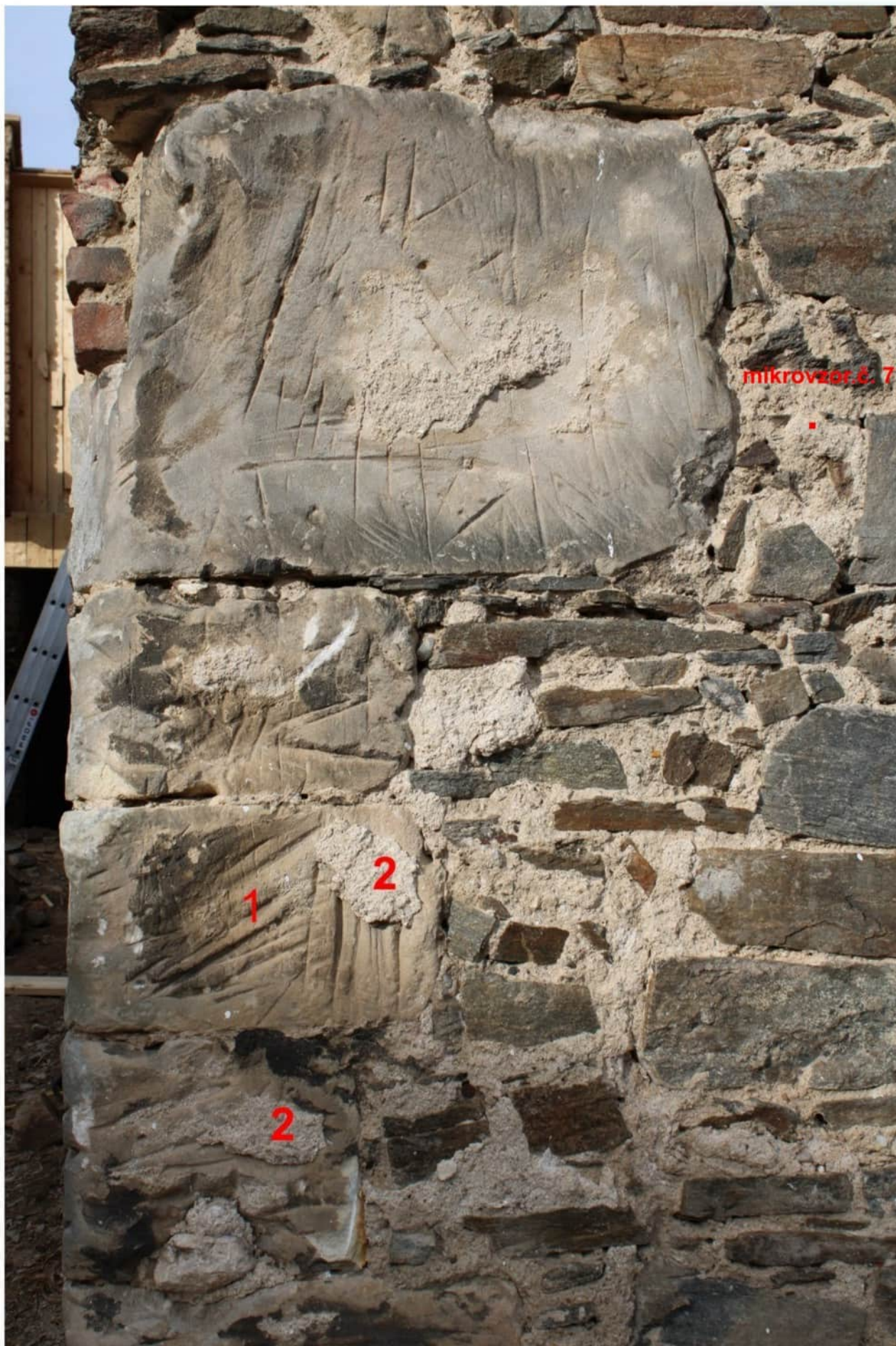
Stav v průběhu rekonstrukce
