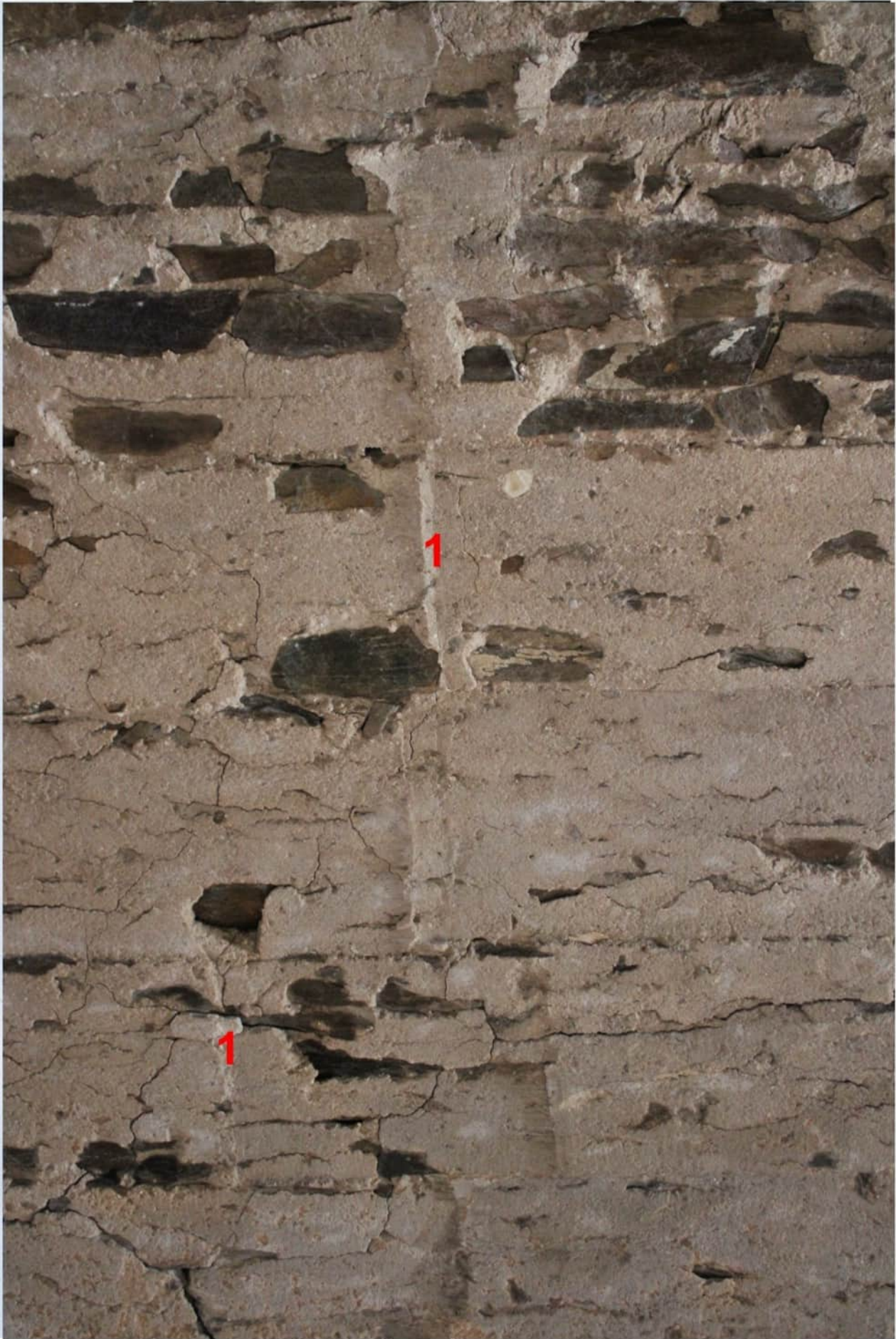
Stav v průběhu rekonstrukce
