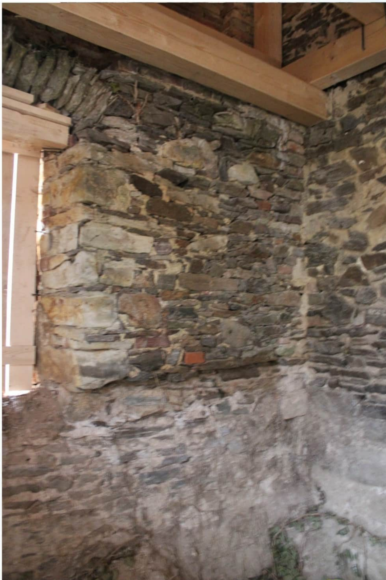
Stav v průběhu rekonstrukce
