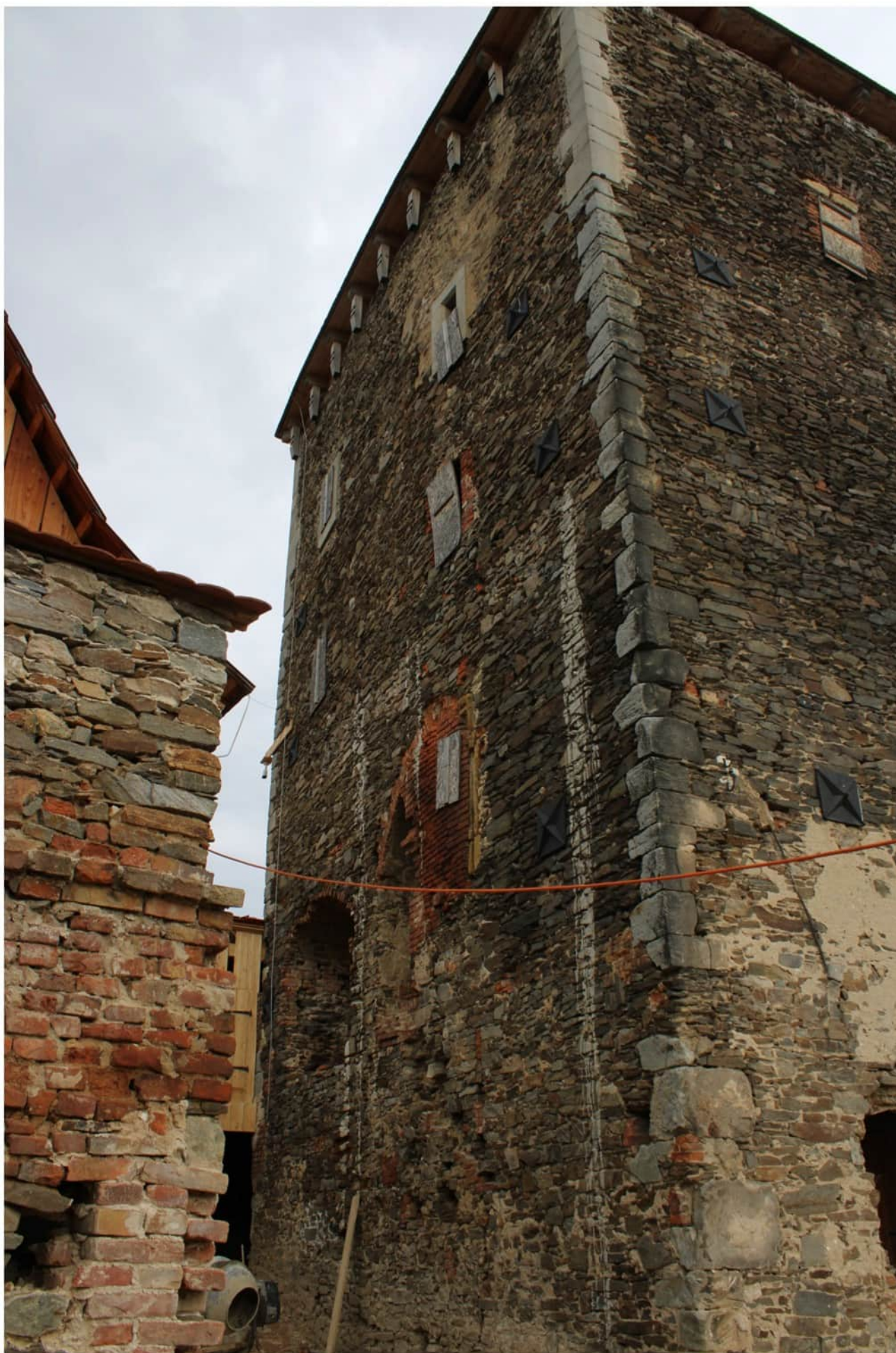
Stav v průběhu rekonstrukce
