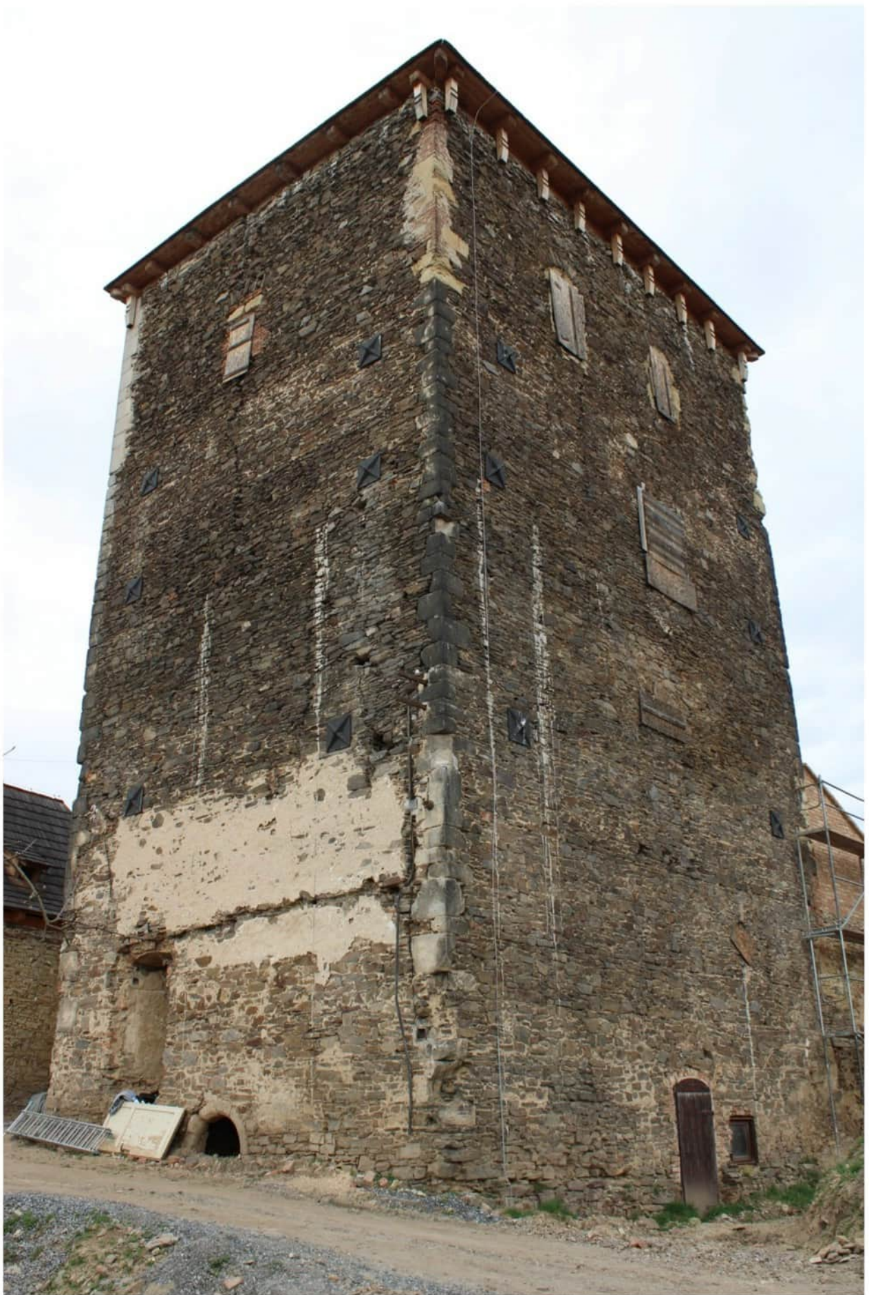
Stav v průběhu rekonstrukce
