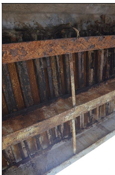
3.4_Detail koroze ocelové NK.jpg
