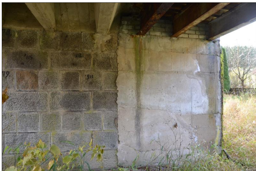
2.7_Píliř 2 přibetonovaná část.jpg
