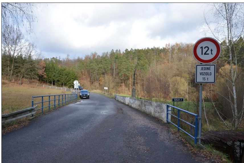
1.2_Pohled proti směru staničení.jpg
