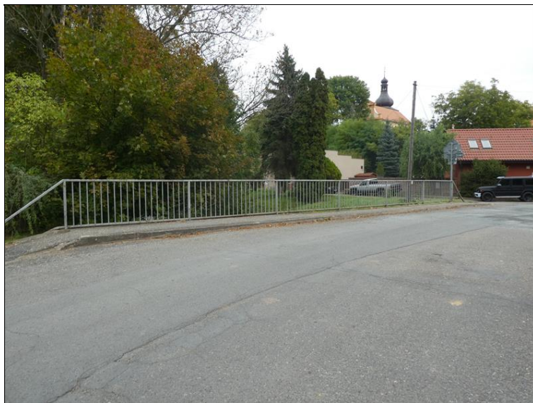
Okraj mostu vlevo.
