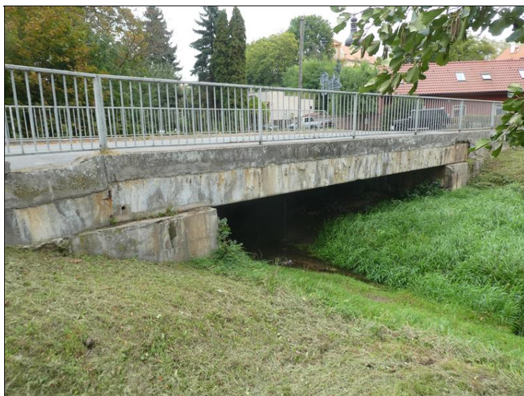
Pohled na most zprava.
