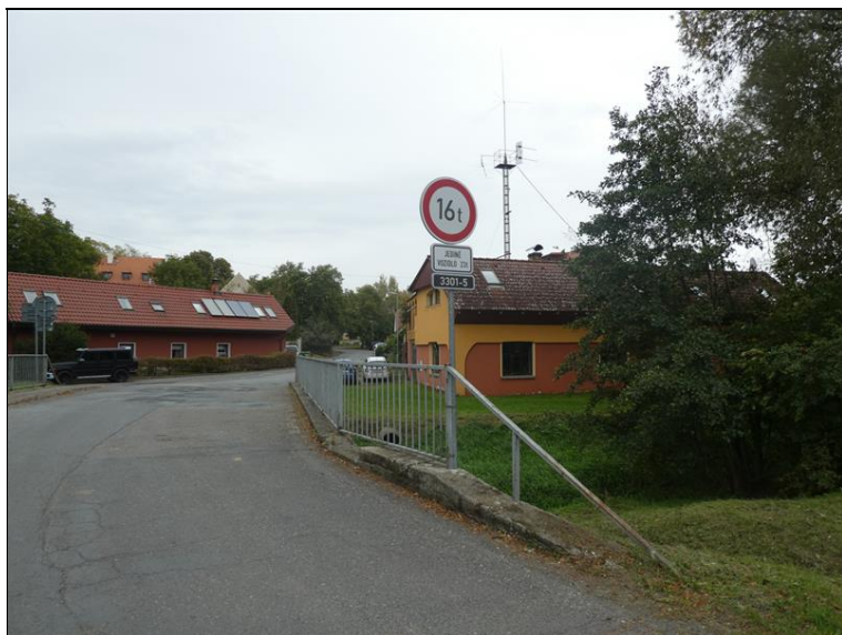
Okraj mostu vpravo.
