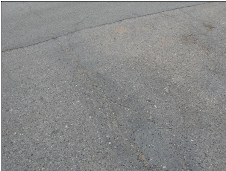
Vozovka na mostě.
