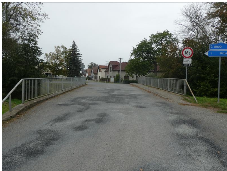
Pohled na most proti směru staničení.
