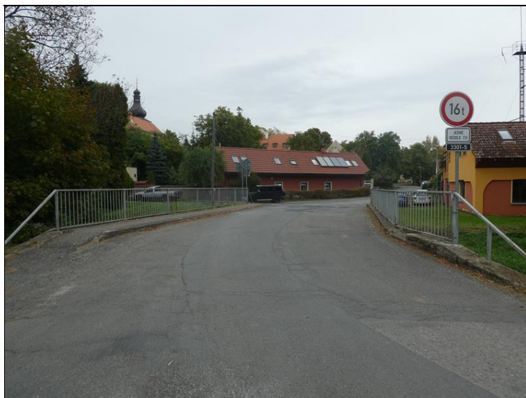
Pohled na most po směru staničení.
