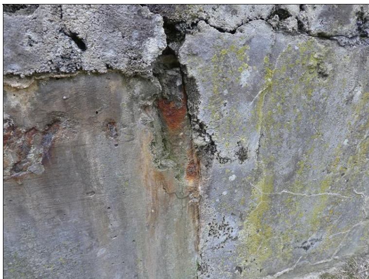
Kotevní deska předpětí u OP1L.
