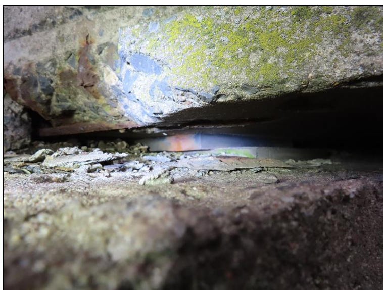
430_Detail uložení krajního nosníku na pilíř P3.JPG
