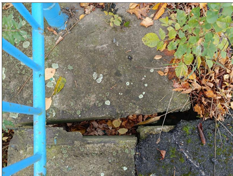
113_Uvolněný koncový blok opěry O5.jpg
