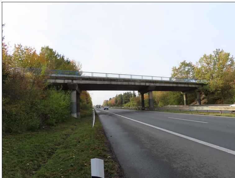
501_Celkový pohled na most.JPG
