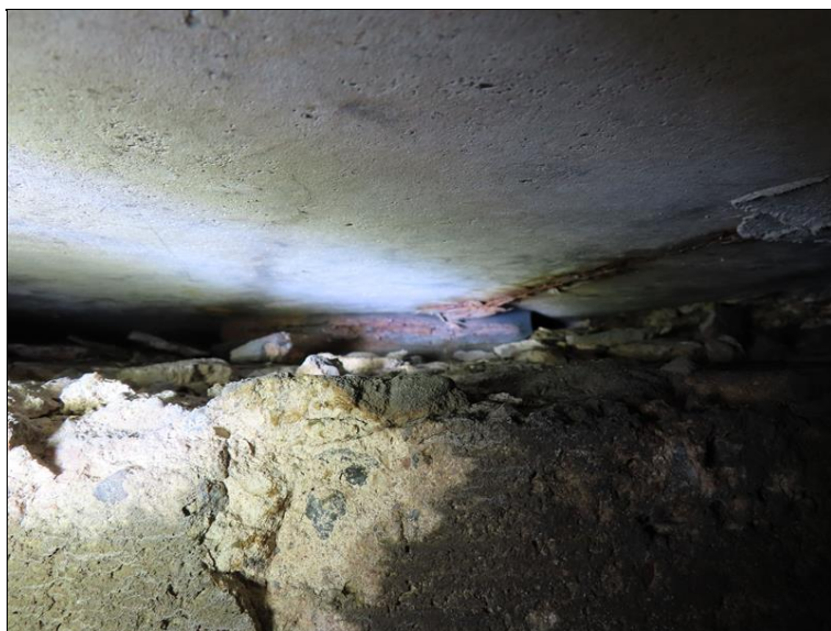
432_Detail uložení nosníku na pilíř P3.JPG
