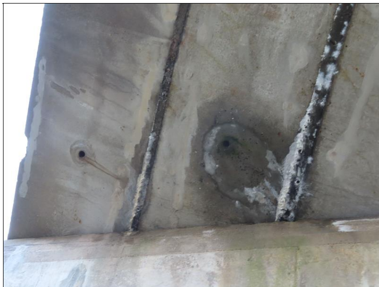
452_Pole 3 stopy po zatékání.JPG
