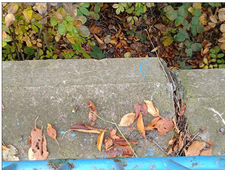
104_Půdorysný posun římsy.jpg
