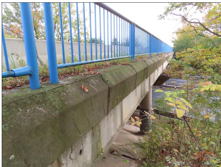
120_Celkový pohled na most.JPG
