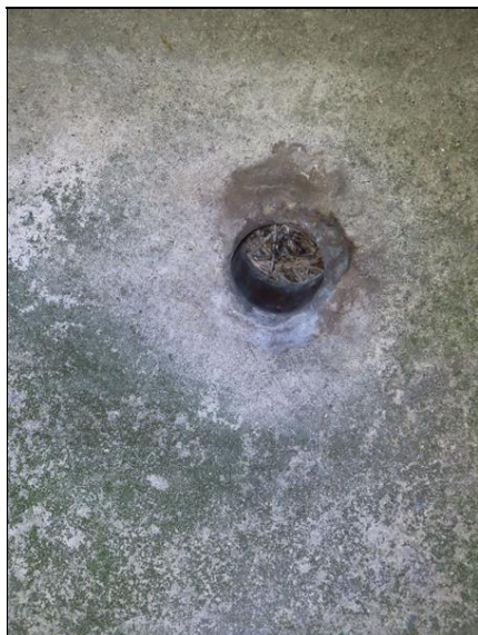
355_Pole 2 neprostupný odvodňovací otvor.JPG
