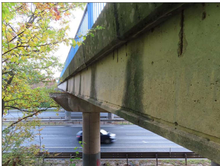
305_Celkový pohled na most.JPG
