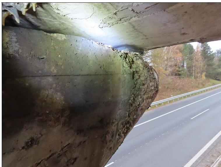
426_Uložení krajního nosníku pole 2 na pilíř P3.JPG
