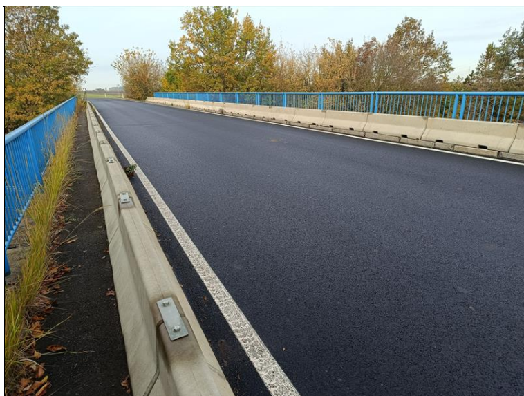
108_Nová vozovka na mostě.jpg
