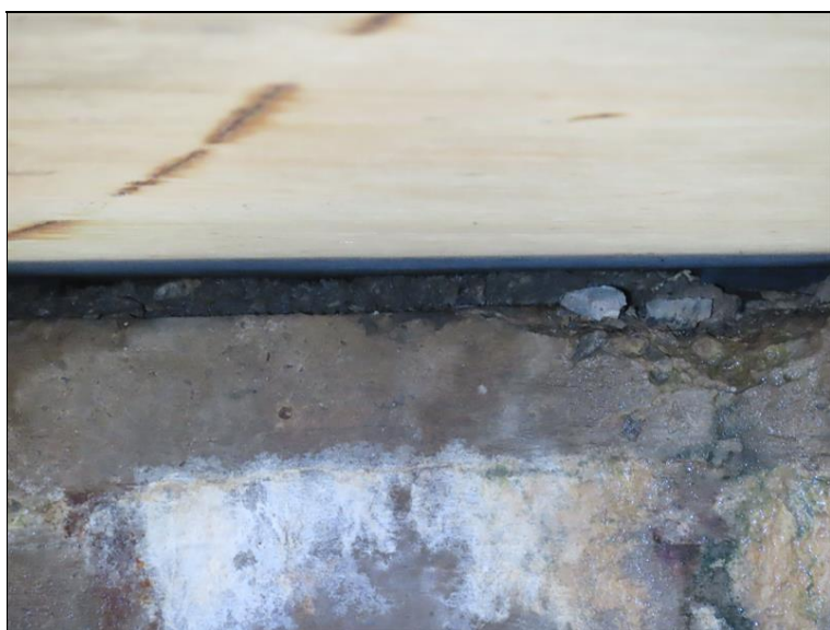
309_Beton před ložisky pilíře P2.JPG
