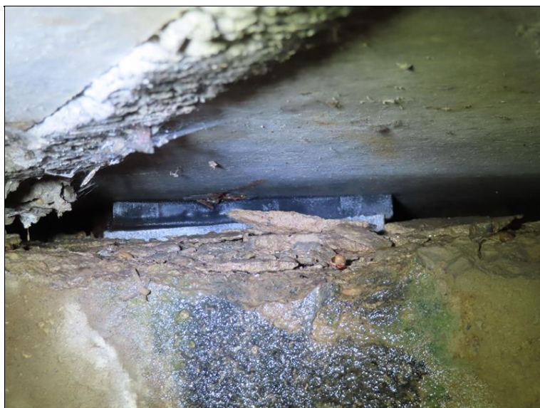
703_Stopy po zatékání na opěru O5.JPG
