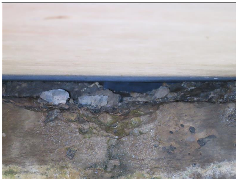
310_Ložisko na pilíři P2.JPG
