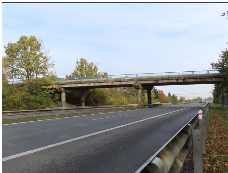
605_Celkový pohled na most.JPG
