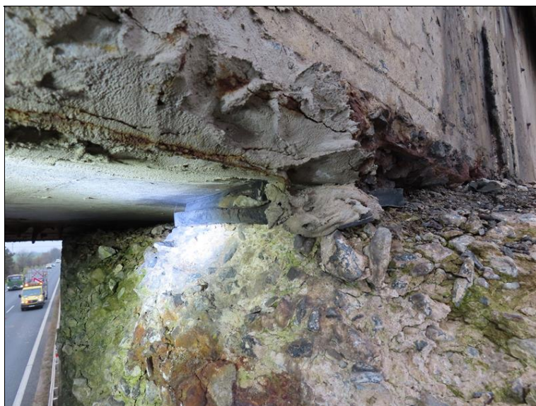
424_Uložení krajního nosníku pole 2 na pilíř P3.JPG
