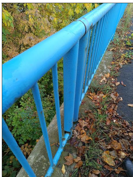
102_Přerušený dolní prvek zábradlí.jpg
