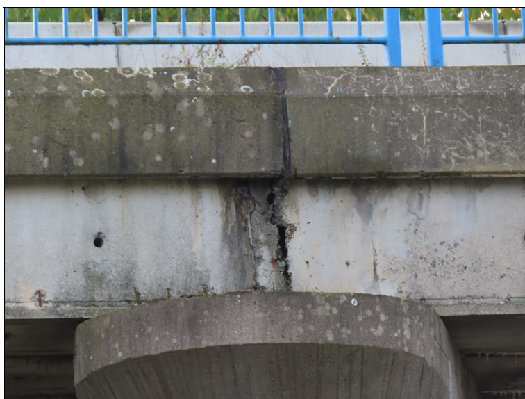
503_Pilíř P4 NK nad pilířem.JPG
