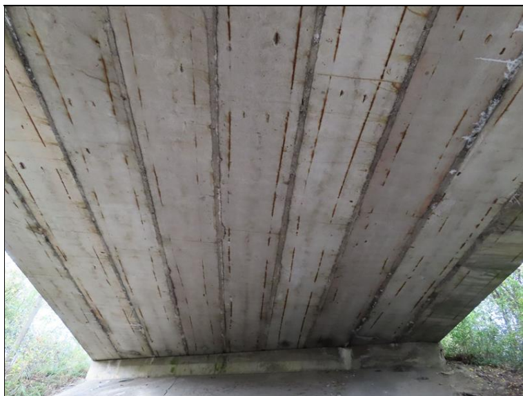
205_Pole 1 opěra O1.JPG
