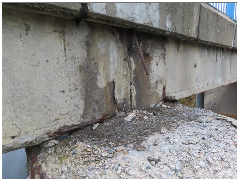
421_Styk nosníků nad pilířem P3.JPG
