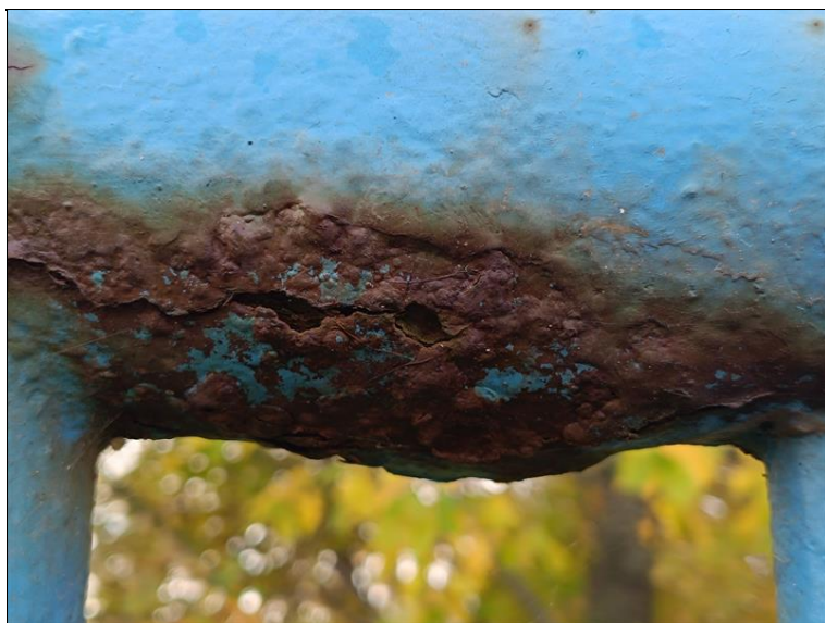
105_Díra v madle zábradlí na jižní římse .jpg
