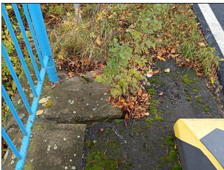
112_Uvolněný koncový blok opěry O5.jpg
