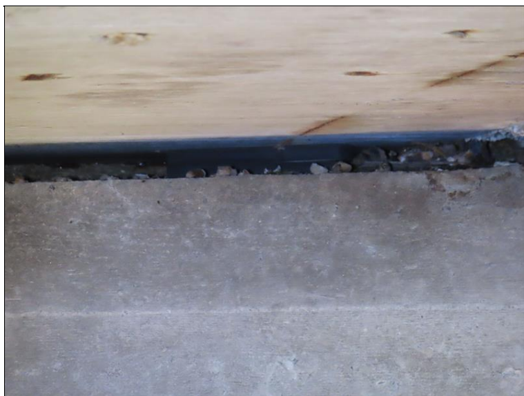
302_Ložisko piliře P2.JPG
