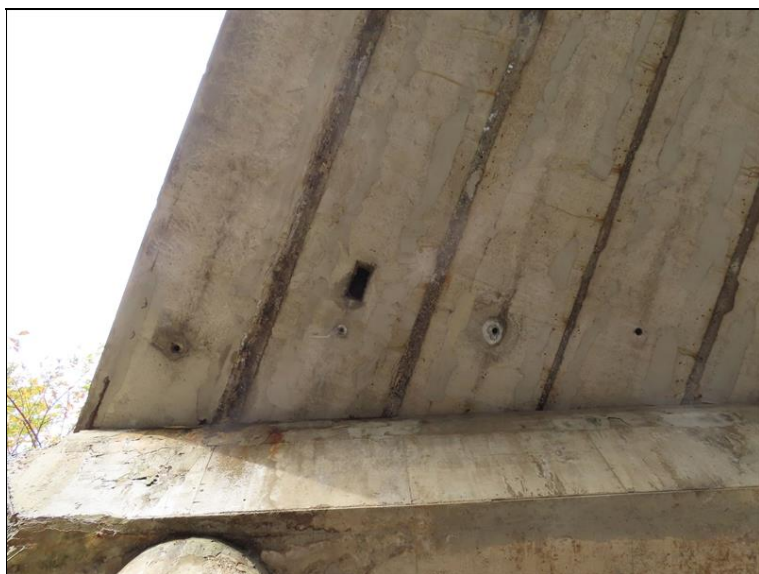
353_Pole 2 sonda do dutiny nosníku.JPG
