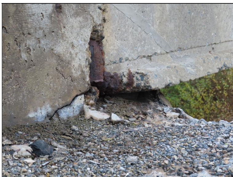
423_Uložení nosníku pole 3 na pilíř P3.JPG
