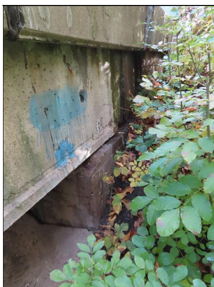
703_Stopy po zatékání na opěru O5.JPG
