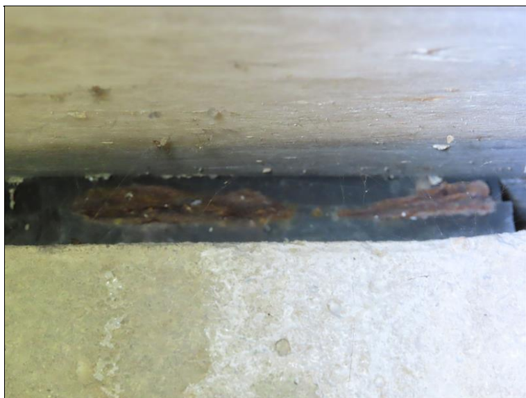
203_Opěra O1 ložisko.JPG
