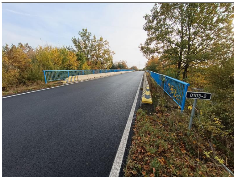
113_Celkový pohled na most ve směru do Záp.jpg
