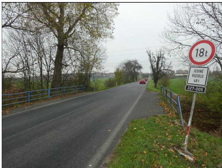
Pohled na most po směru staničení.
