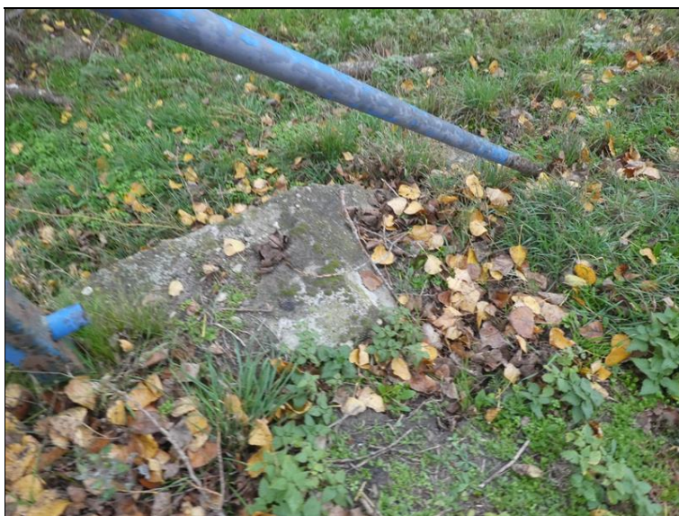
Nezakotvené zábradlí.
