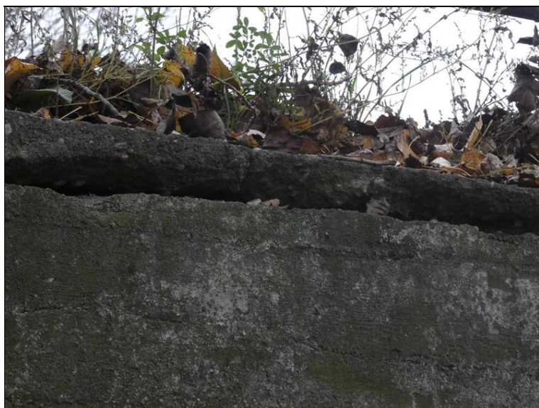
Podélná spára v římse.
