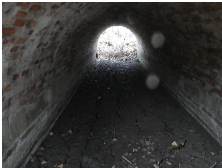
Průhled mostním otvorem.
