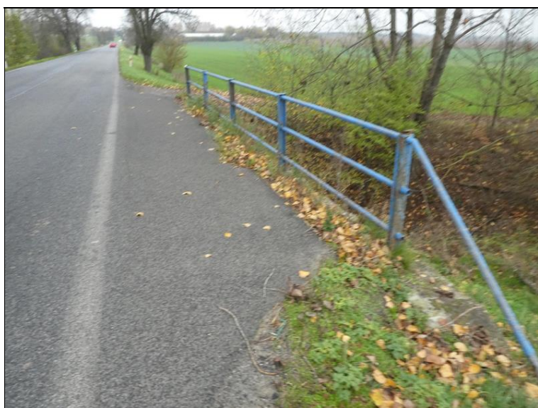
Pohled na pravou stranu mostu.
