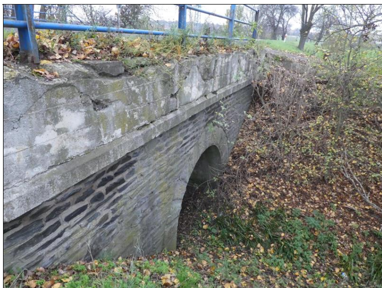
Pohled na most zprava.
