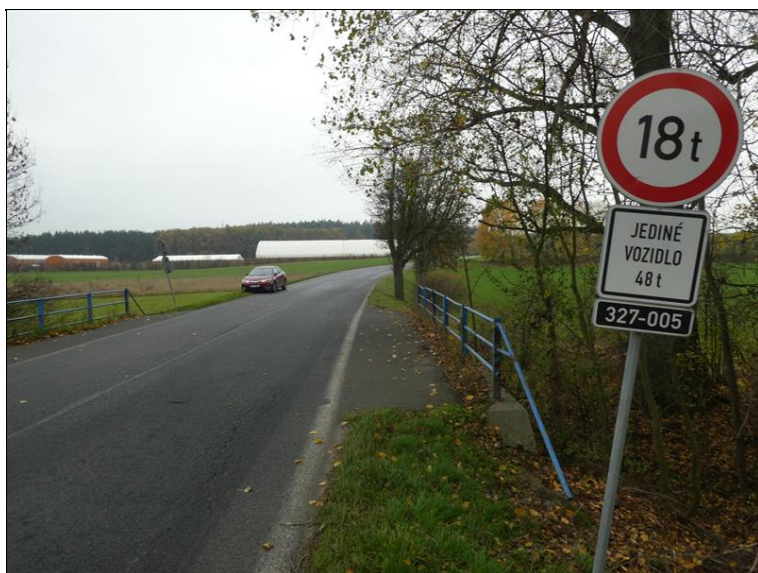
Pohled na most proti směru staničení.
