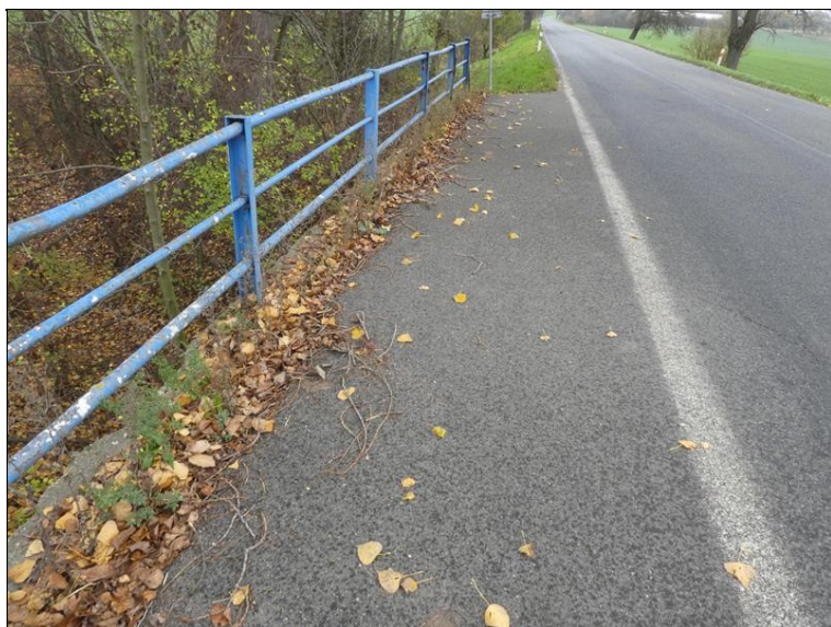
Pohled na levou stranu mostu.
