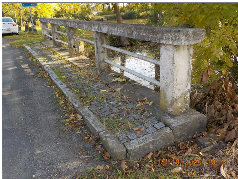
hrany sloupků a horního madla, koroze odhalené výztuže.
