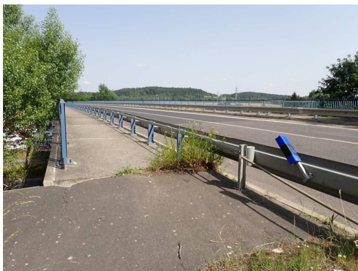
Obr.12: Římso vpravo Uchycená vegetace ve spáře římsy. Uvolněný modrý směrový sloupek
