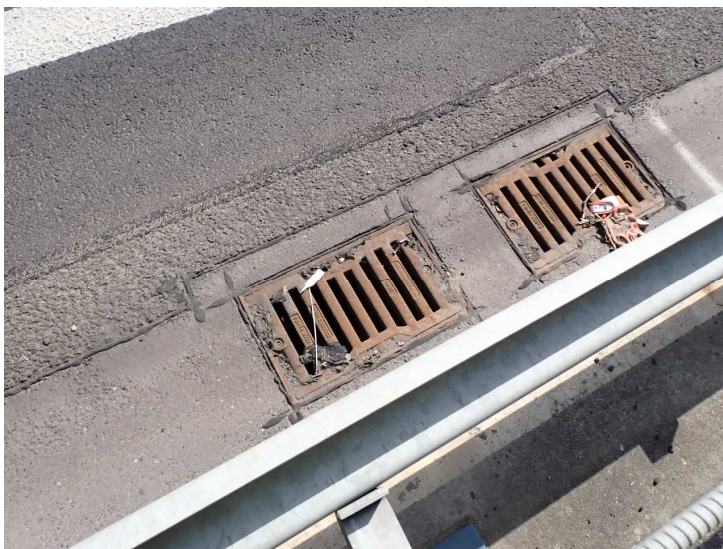
Obr.10: Odvodňovače u opěry 1 Nánosy a nečistoty na mřížích odvodňovačů
