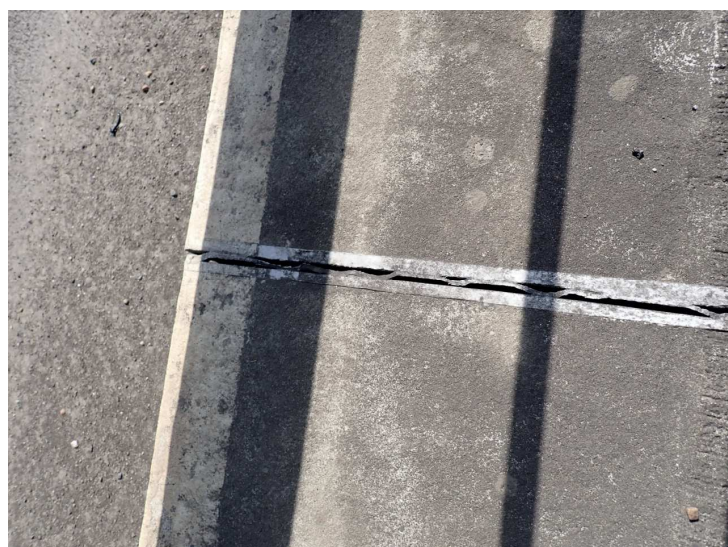
Obr.3: Římsa vpravo Vyžilé těsnění dilatační spáry římsy.
