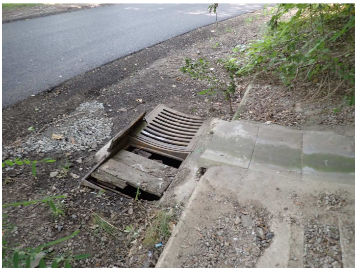
Obr.22: Vtok do kanalizace před opěrou 1
