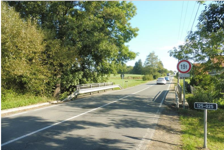
Pohled na most po směru staničení.
