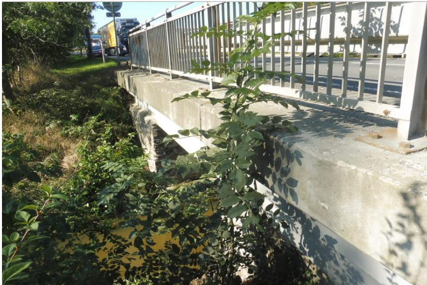
Pohled na most zprava.
