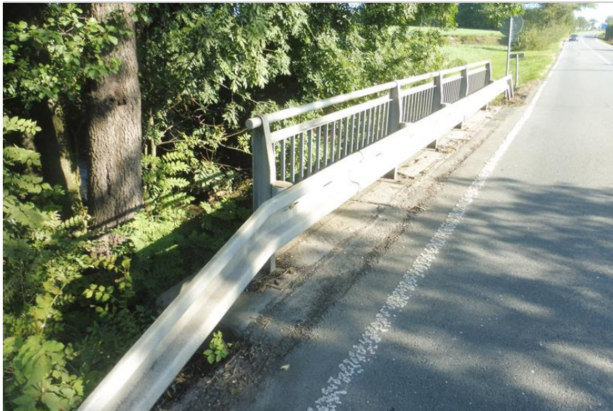
Pohled na levou stranu mostu.
