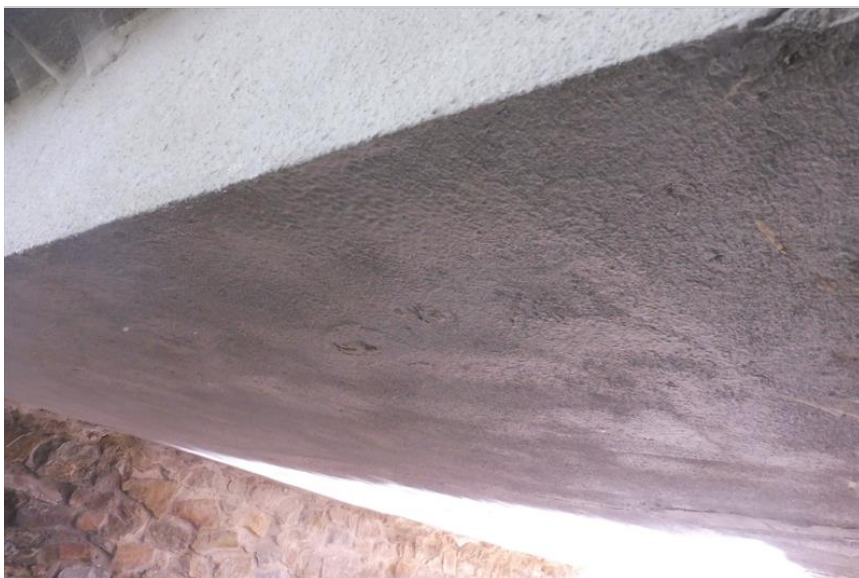
Pohled na spodek nosné konstrukce.
