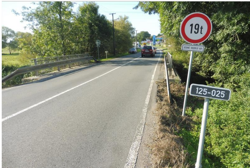
Pohled na most proti směru staničení.
