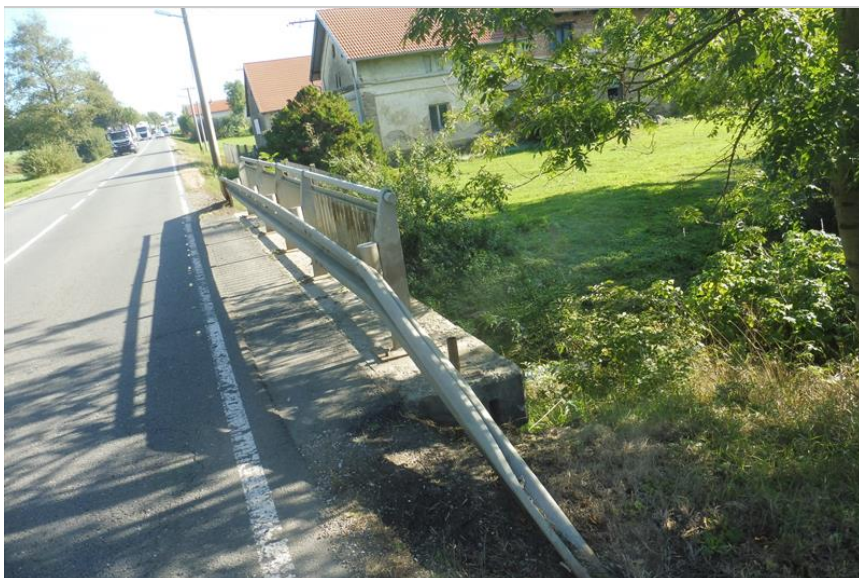
Pohled na pravou stranu mostu.
