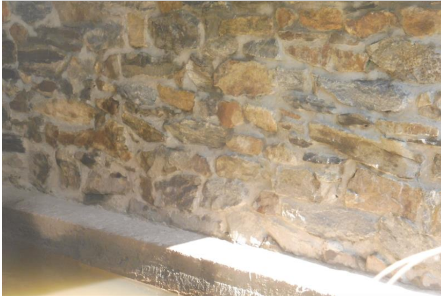
Pohled na opěru 2.
