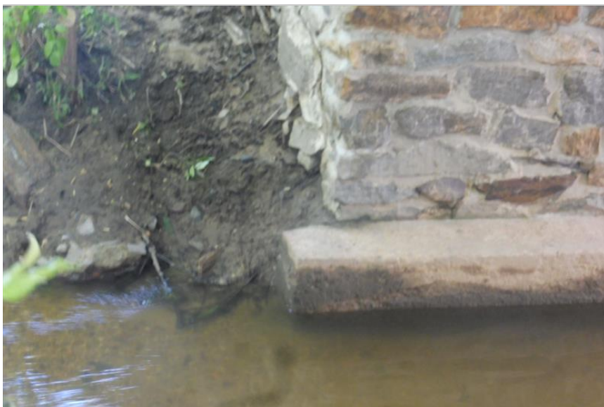
Poškození prahu před O1 P.
