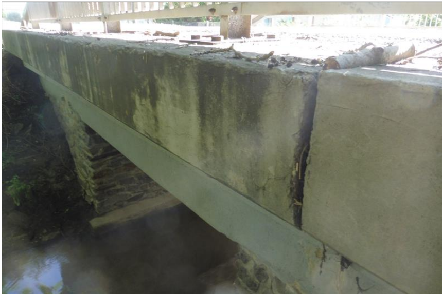
Pohled na bok římsy a nosné konstrukce.
