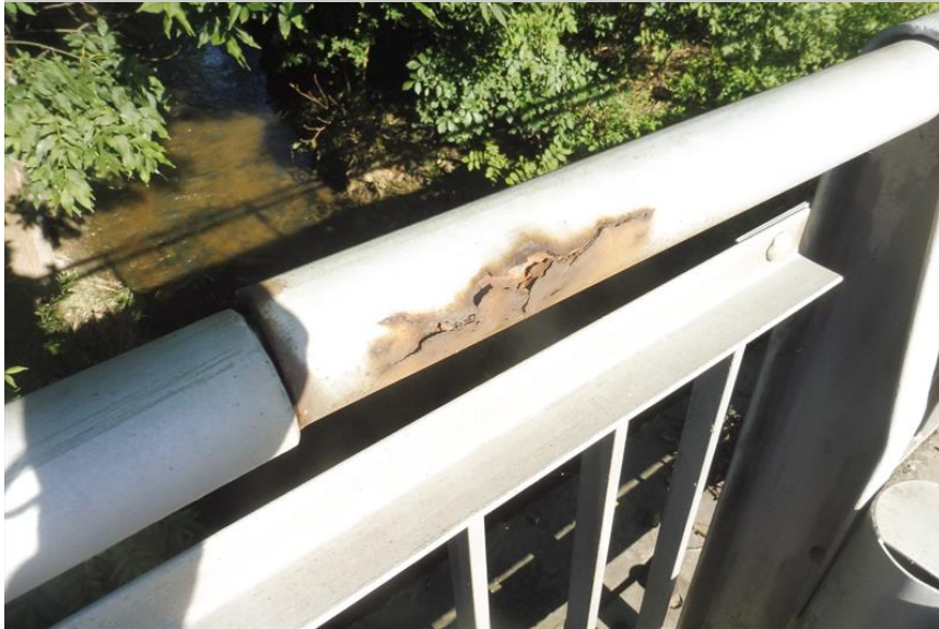
Koroze zábradlí.
