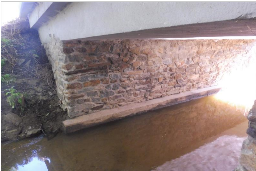
Pohled na opěru 1.
