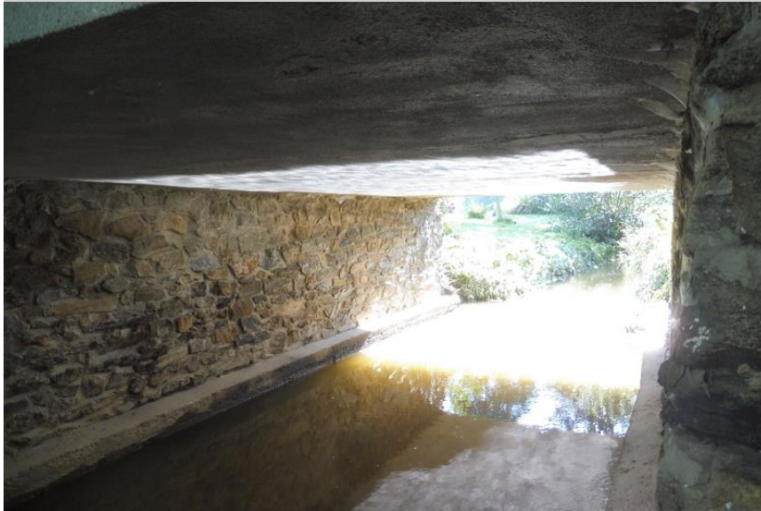
Průhled mostním otvorem
