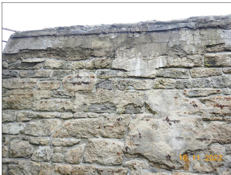
Levá čelní zeď - povrchová degradace zdiva, výluhy.
