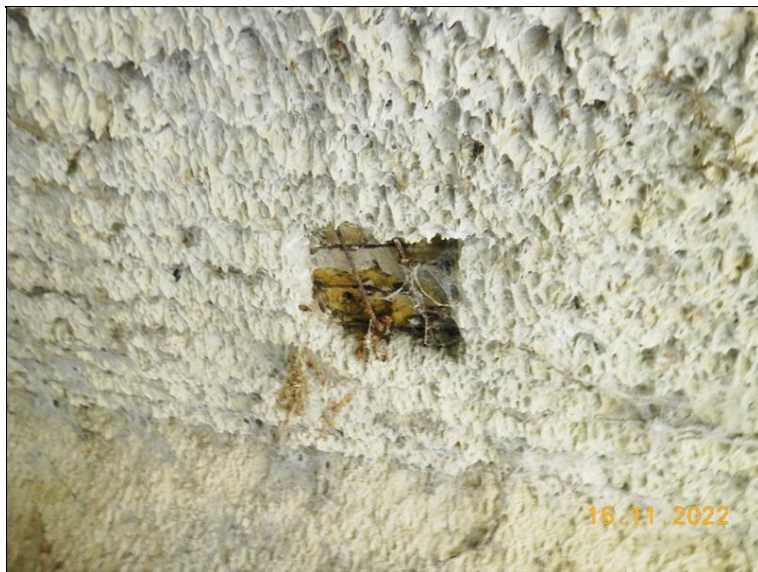
OP1 - rozpad torkretu a koroze kari sítě.
