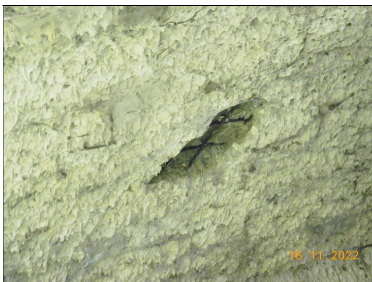
OP1 vlevo - rozpad torkretu a koroze kari sítě.
