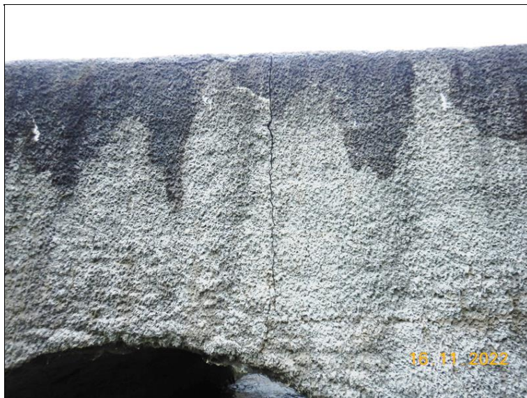
Pravá čelní zeď - svislá trhlina, separace torkretu od zdiva.
