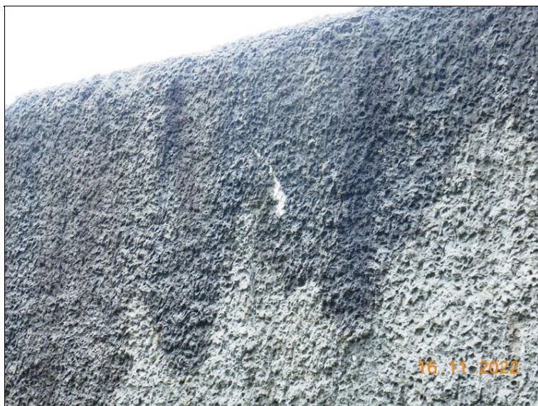
Pravá čelní zeď - lokálně trhliny s výluhy.
