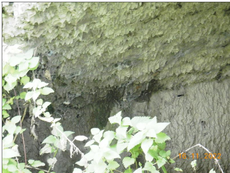
OP1 vlevo - průsaky v patě klenby.
