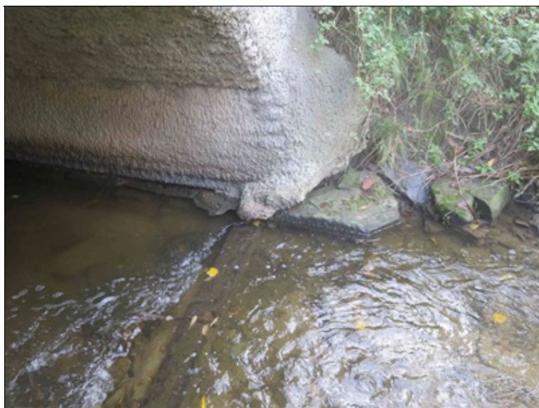
částečně podemletý dřík opěry v úrovni kolísání běžné hladiny poroka
