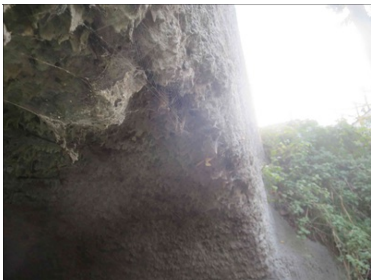
trhlina v torkretu na hraně klenbového pasu
