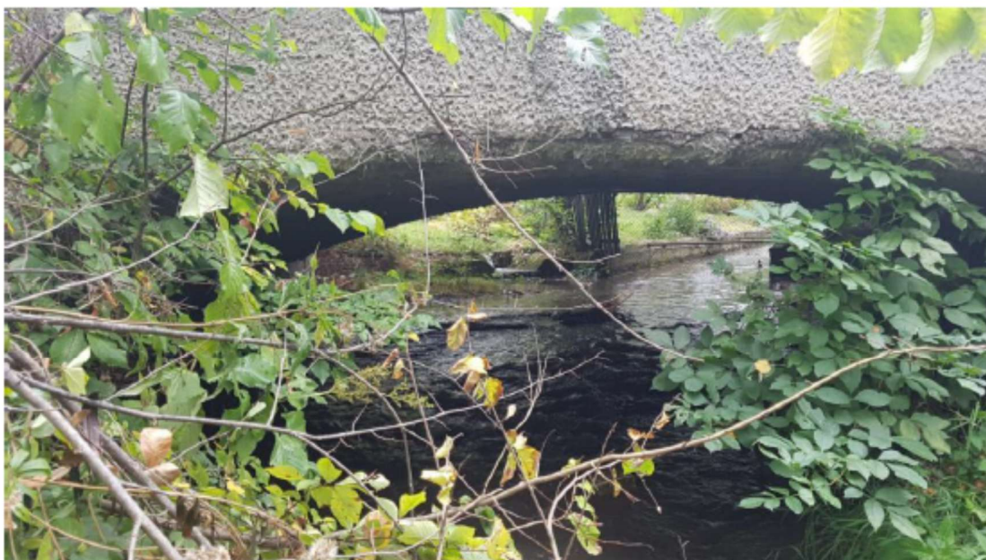
Pohled pod most proti směru vodního toku
