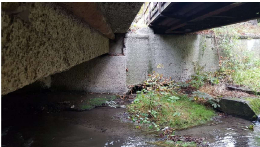
Pohled na napojení opěru lávky a most
