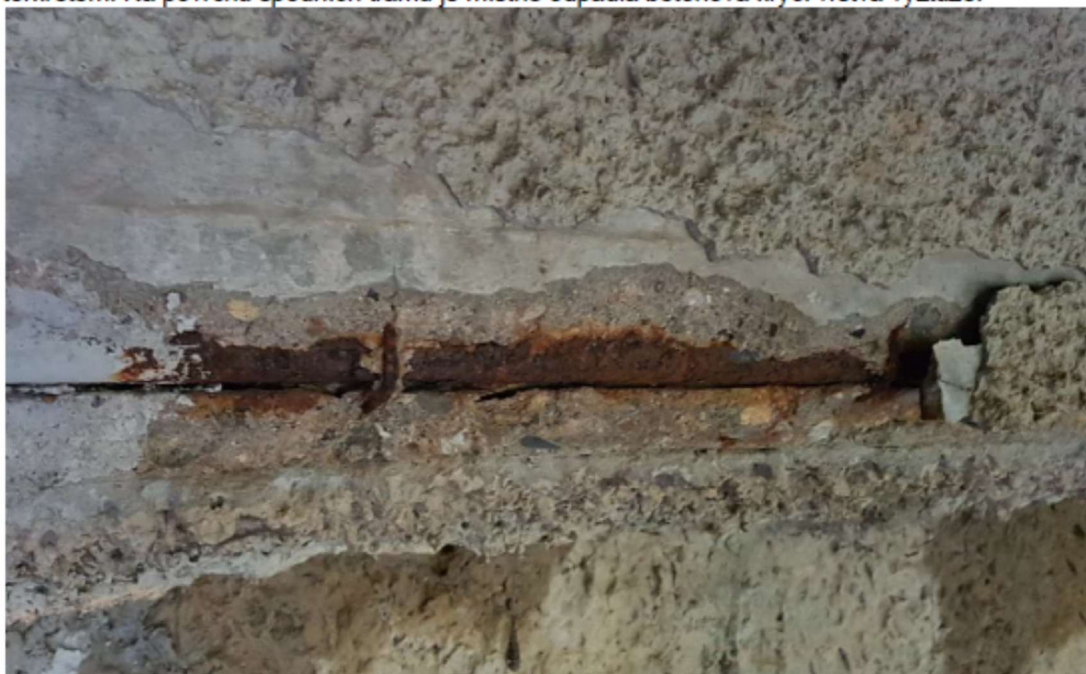
Odpadlá betonová krycí vrstva výztuže na trámové konstrukci
