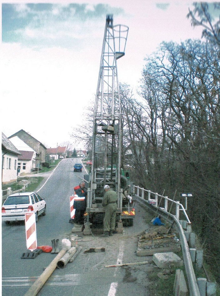
Obr. 1 Vrtná souprava UGB 50 - M při realizaci vrtu J 1.
