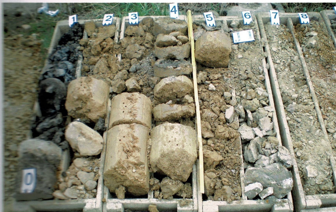
Obr. 3 Vzorkovnice s jádrem z vrtu J 1, hl. 0,0 – 7,0 m. Povrch konstrukce vozovky 0,0 m je v levém dolním rohu skupiny vzorkovnic. Kryt vozovky se skládal z asfaltového betonu (tři vrstvy - celkem 22 cm) a pod ním se nacházely původní granodioritové dlažební kostky (o hraně 11 cm) uložené do pískového podsypu (tl. 3 cm). Podklad vozovky tvořilo drcené kamenivo (velikosti 1 - 3 cm) obalované asfalem . Celková tloušťka konstrukce vozovky byla 1,0 m. Silniční podloží až do 7,3 m tvořil násyp - převážně jílovitý (s úlomky).
