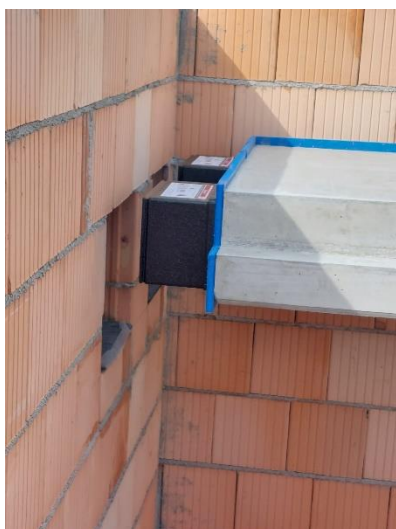
Obr. 19: Příklad schodišťového systému ochrany proti kročejovému zvuku [zdroj: https://www.schoeck-wittek.cz/ a vlastní]
