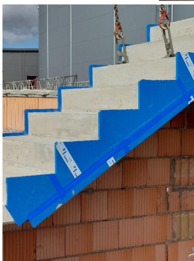
Obr. 19: Příklad schodišťového systému ochrany proti kročejovému zvuku [zdroj: https://www.schoeck-wittek.cz/ a vlastní]
