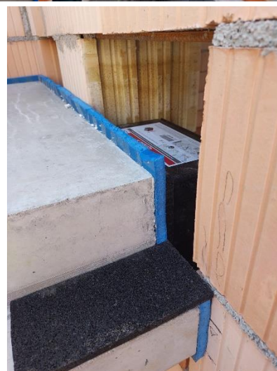
Obr. 19: Příklad schodišťového systému ochrany proti kročejovému zvuku [zdroj: https://www.schoeck-wittek.cz/ a vlastní]
