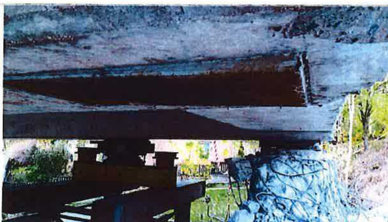
Demolice OP6, podepření NK u OP6
