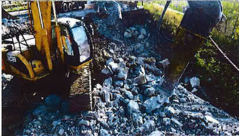
Bourání přechodové oblasti za OP6
