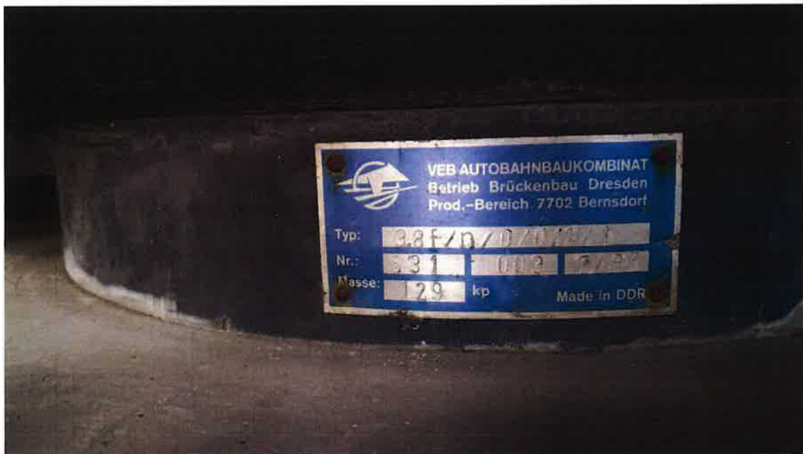
Opěra O1, pravé ložisko – pohled na výrobní štítek.
