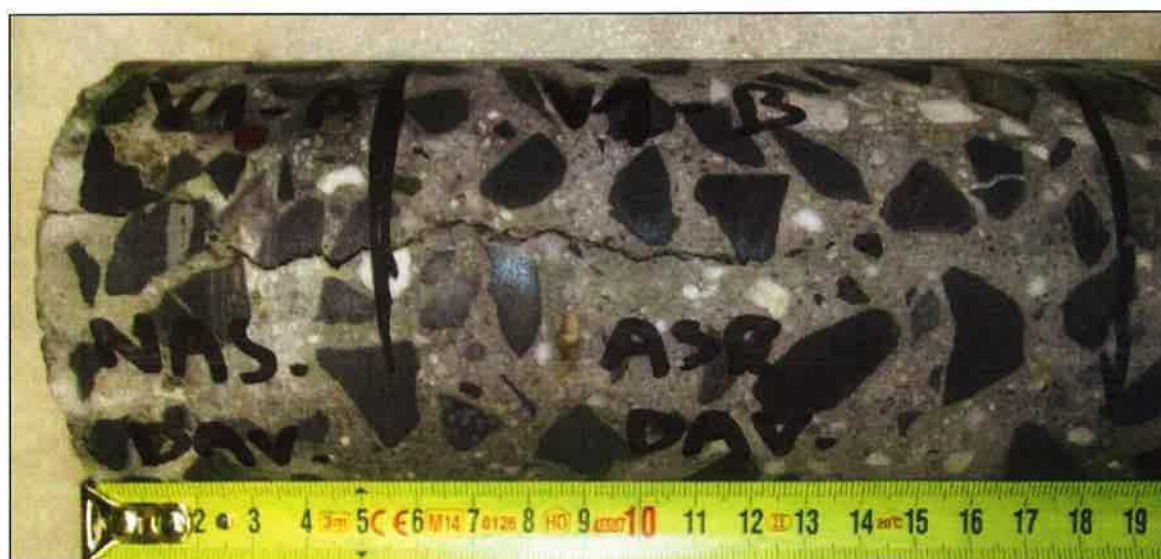
Foto 2: Pohled na trhlinu u líce vzorku V1
