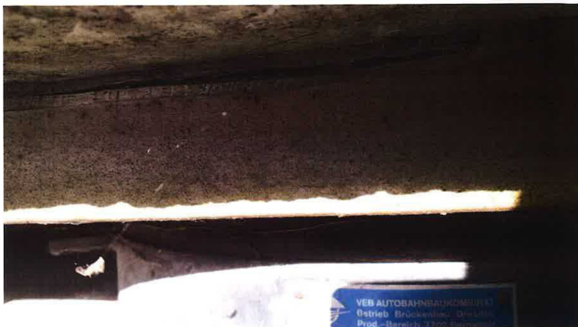
Opěra O1, pravé ložisko – pohled na zdvojeninu PVC nebo polyamidové vložky mezi klínovou deskou a nosnou konstrukcí.
