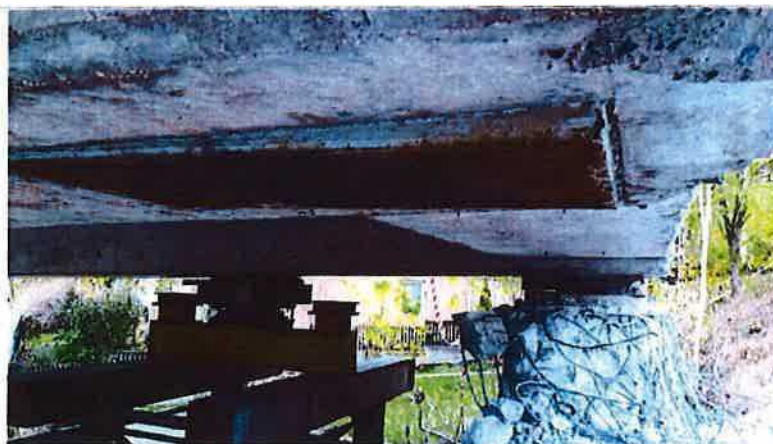
Demolice OP6, podepření NK u OP6
