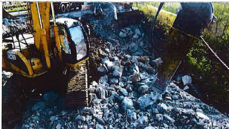
Bourání přechodové oblasti za OP6
