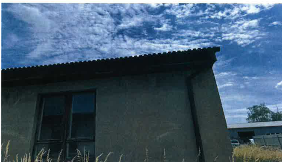
Budova č.3 - Vyměnit žlab 4 m do osazených háků
