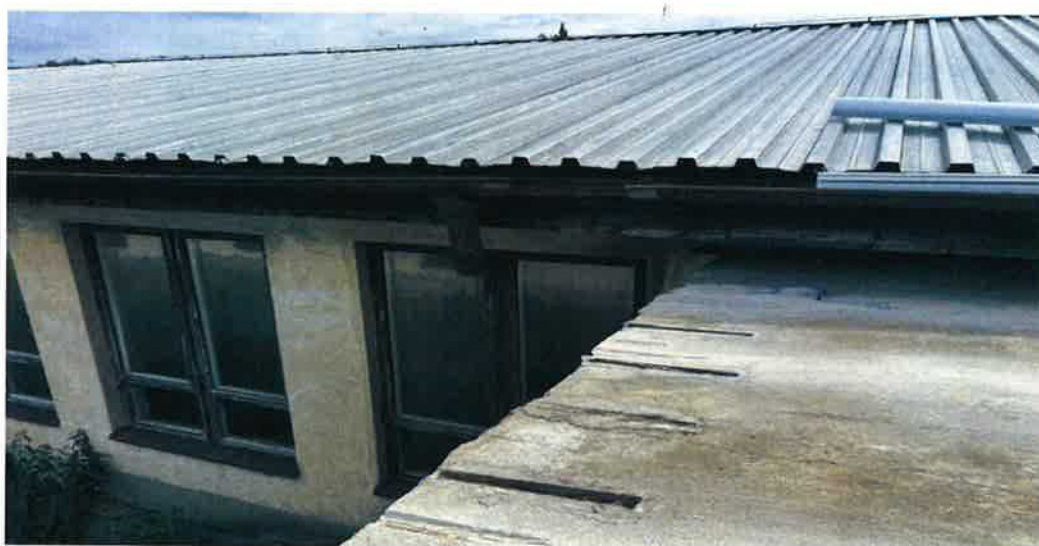
Budova č. 3 -výměna žlabu včetně háků 3 bm
