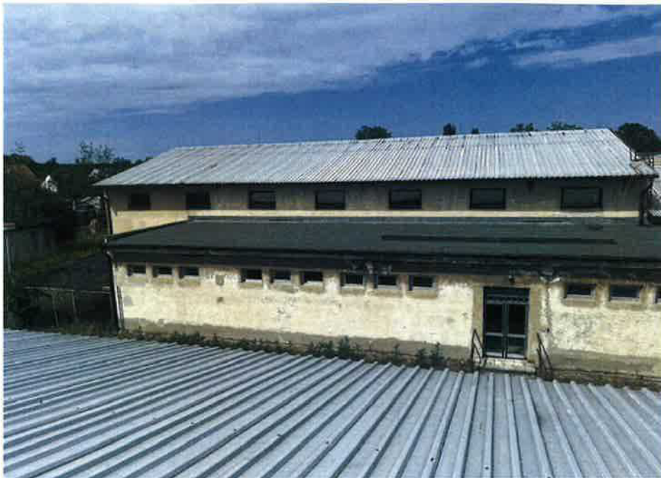
Přístavek u objektu č.1 -doplnit asfaltový modifikovaný pás -oprava napojení omítky na klempířský prvek ve spoji u zdi
