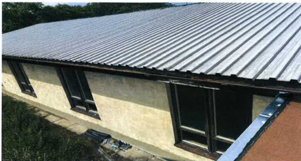
Budova č.3 – výměna žlabu a doplnění háků
