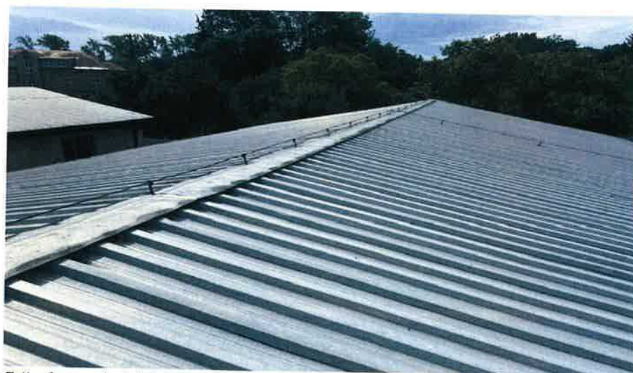
Střecha nad objektem č.2 – připevnit hřebenáče
