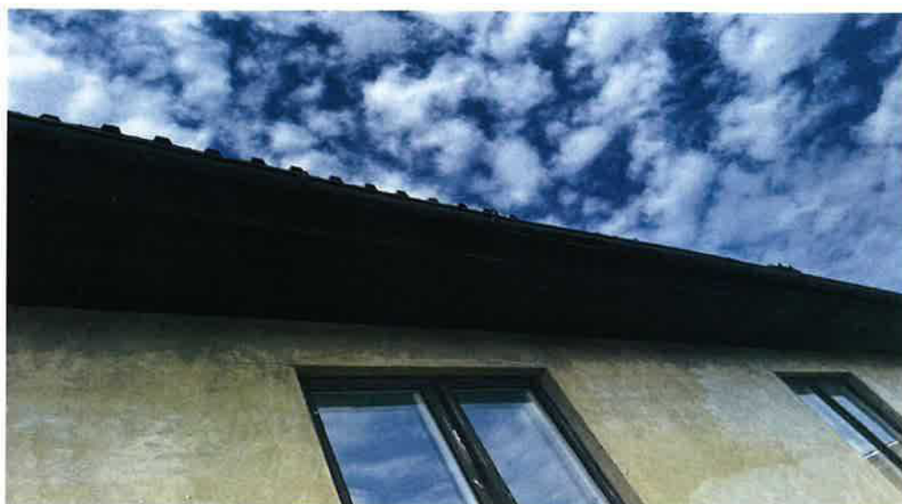
Budova č. 3 – výměna žlabu včetně háků 4 bm
