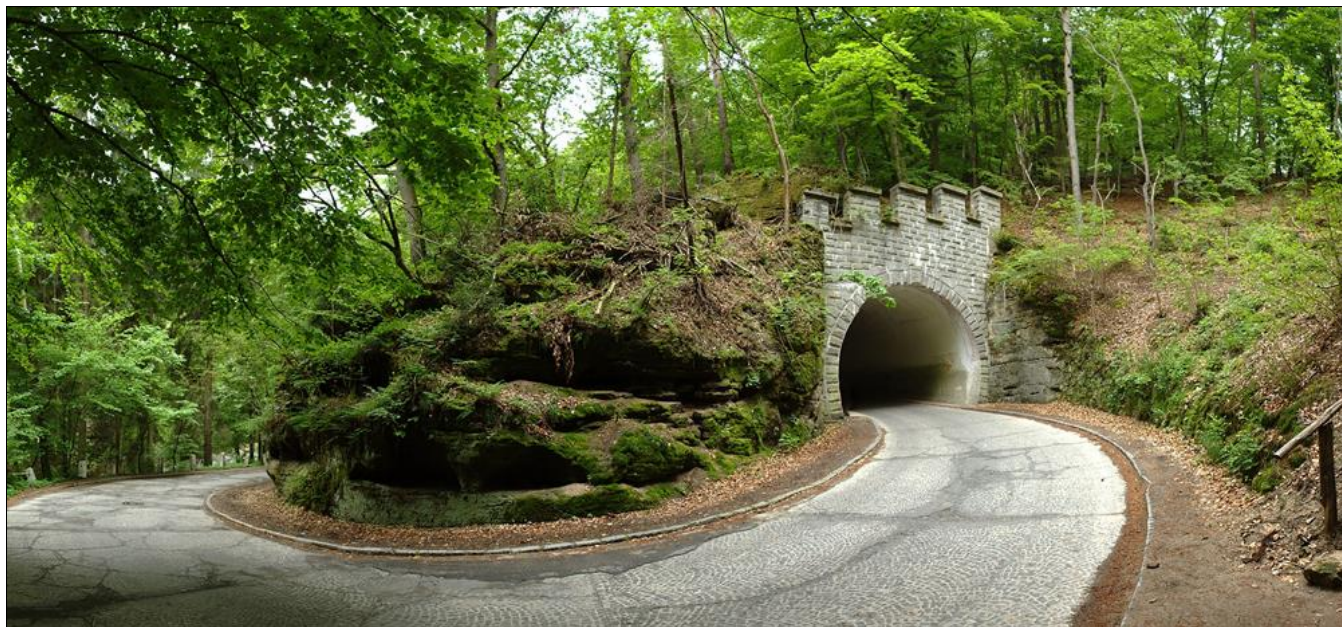
3-Východní portál a přilehlá točka.jpg
