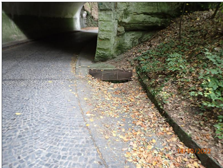
46 - Krycí ocelová mříž pro šachtu odvodnění PK před západním portálem vpravo.
