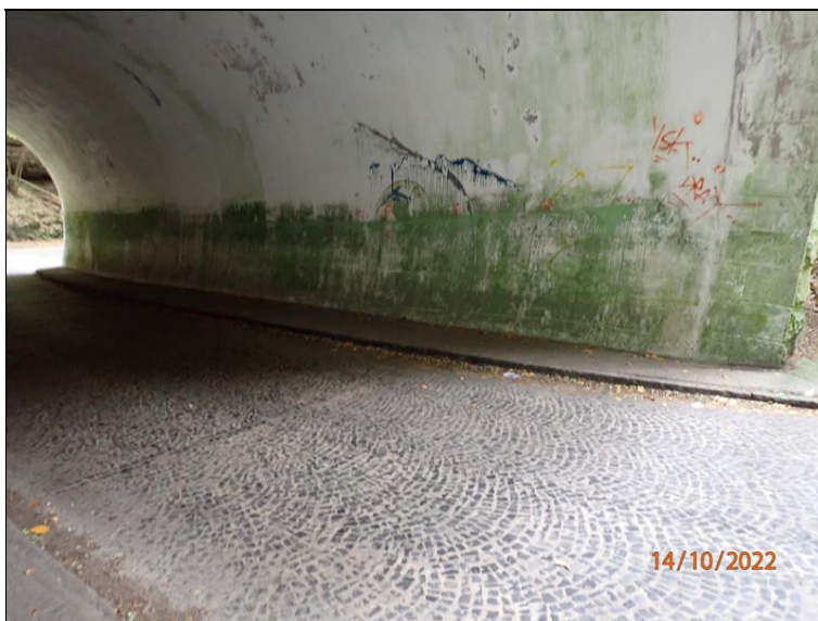
18 - Celkový pohled na pravou stranu tunelu (pravou opěru) od levé strany západního portálu
