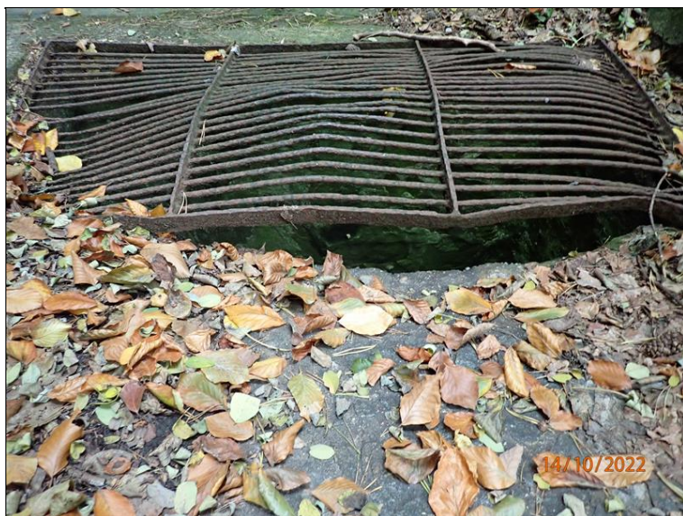
47 - Detail ocelové mříže z předchozího snímku.
