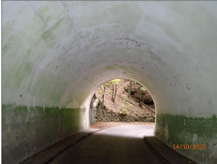
16 - Pohled zdola po směru staničení III/2733 na východní polovinu podjezdu (tunelu)
