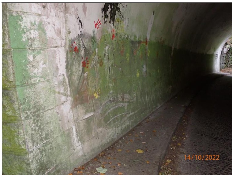
23 - Pohled na levý chodník v podjezdu od levé strany západního portálu (po směru staničení)
