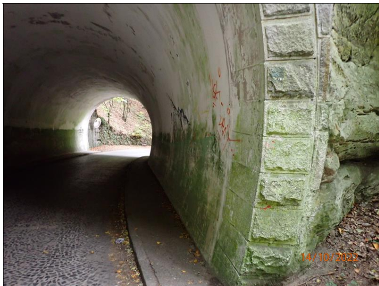
22 - Pohled na pravý chodník v podjezdu od pravé strany západního portálu (po směru staničení)
