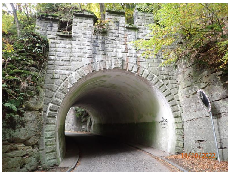
08 - Pohled do podjezdu od východního portálu (proti směru staničení)
