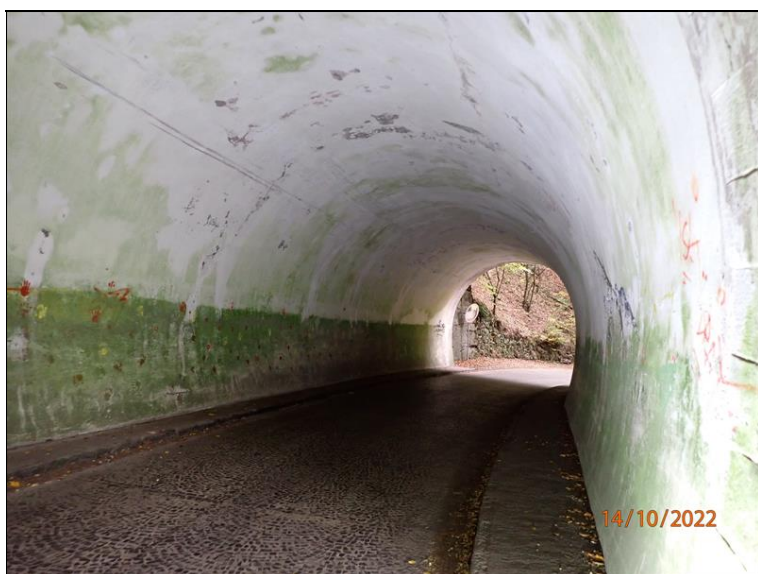
39 - Vozovka z kamenné mozaikové dlažby zvýšené obrubníky a betonové oboustranné chodníky v podjezdu, pohled od pravé strany po směru staničení.
