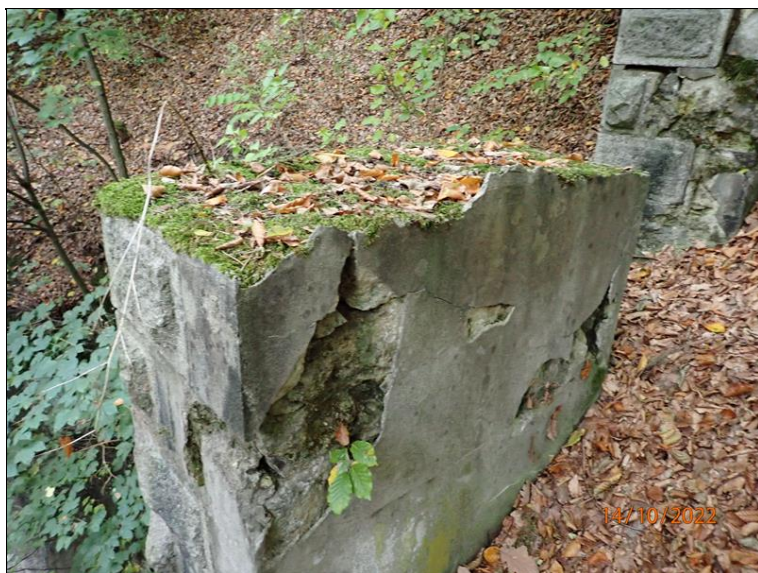
77 - 1. vnitřní sloupek (zleva) cimbuří západního portálu - pohled na vnitřní (rubovou) stranu.
