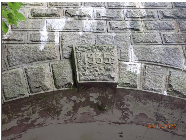
37 - Vrcholový klenák západního portálu s letopočtem zahájení výstavby tunelu.
