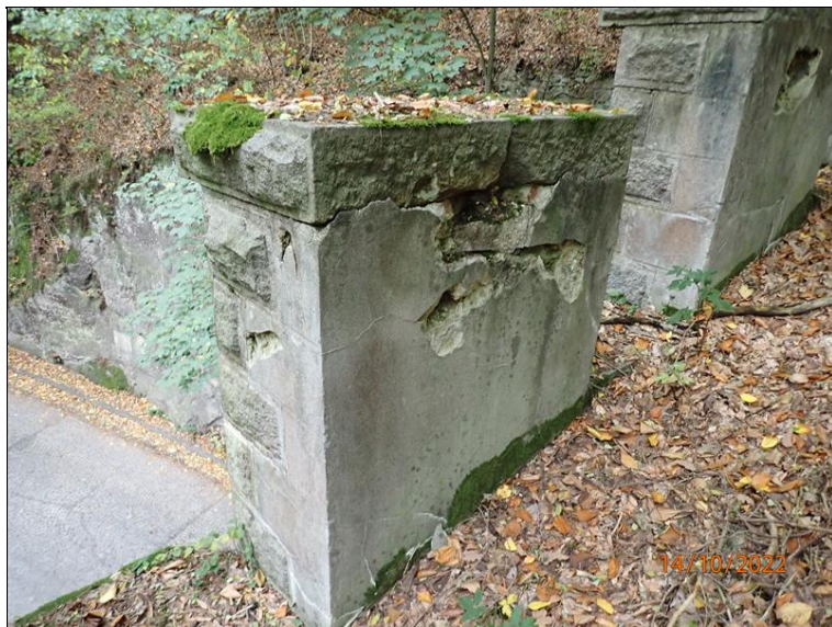
76 - 1. vnitřní sloupek (zprava) cimbuří západního portálu - pohled na vnitřní (rubovou) stranu.
