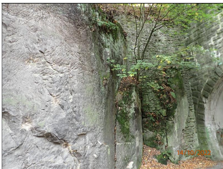
06 - Navazující zárubní zděná stěna a skalní masiv po levé straně západního portálu tunelu
