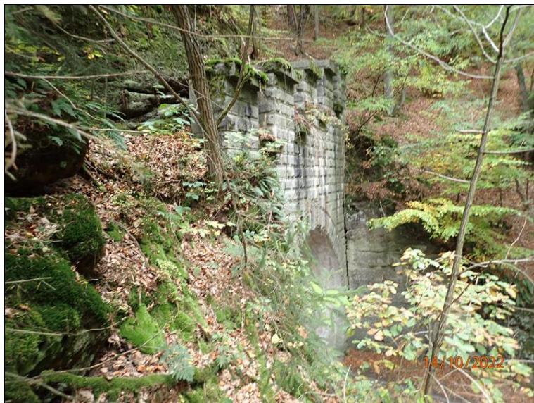
31 - Boční pohled shora na cimbuří a horní část východního portálu tunelu (zprava)
