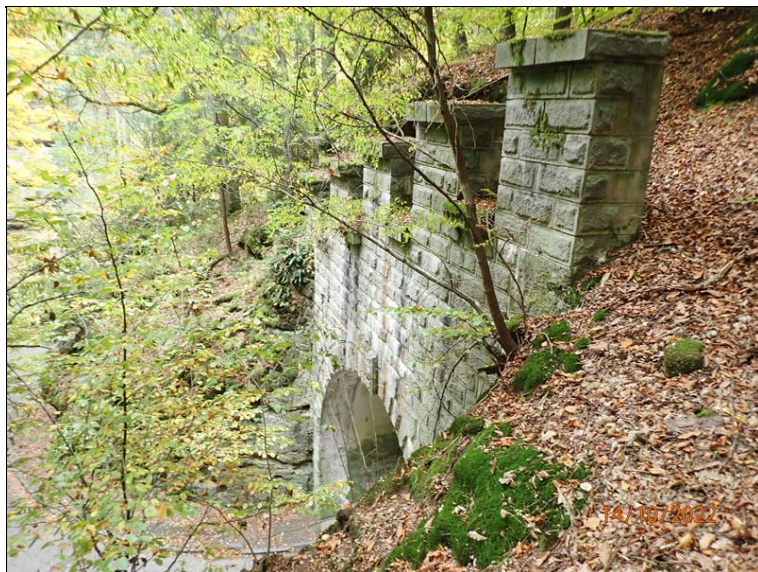
79 - Cimbuří východního portálu v celkovém bočním pohledu shora ze svahu před levou stranou tunelu.
