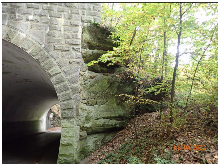
05 - Navazující skalní masiv po pravé straně západního portálu tunelu
