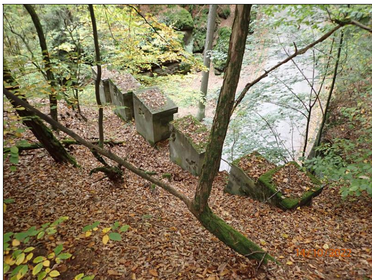
26 - Pohled shora (z levé strany) na cimbuří západního portálu tunelu
