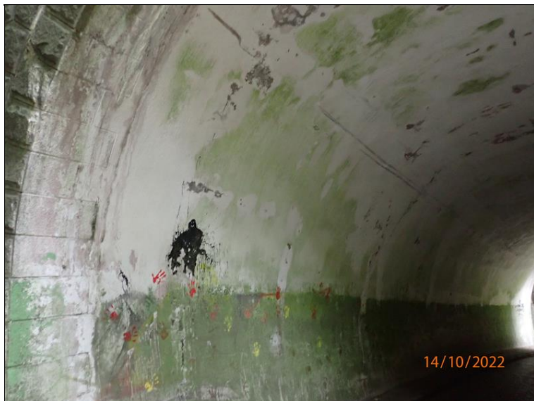
64 - Betonová obezdívka tunelu (levá opěra) v pohledu od levé strany západního portálu.
