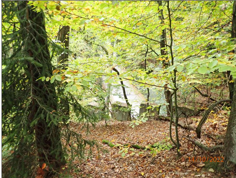
28 - Pohled shora (z nadloží přibližně nad vrcholem tunelu) na západní polovinu (proti směru staničení PK)
