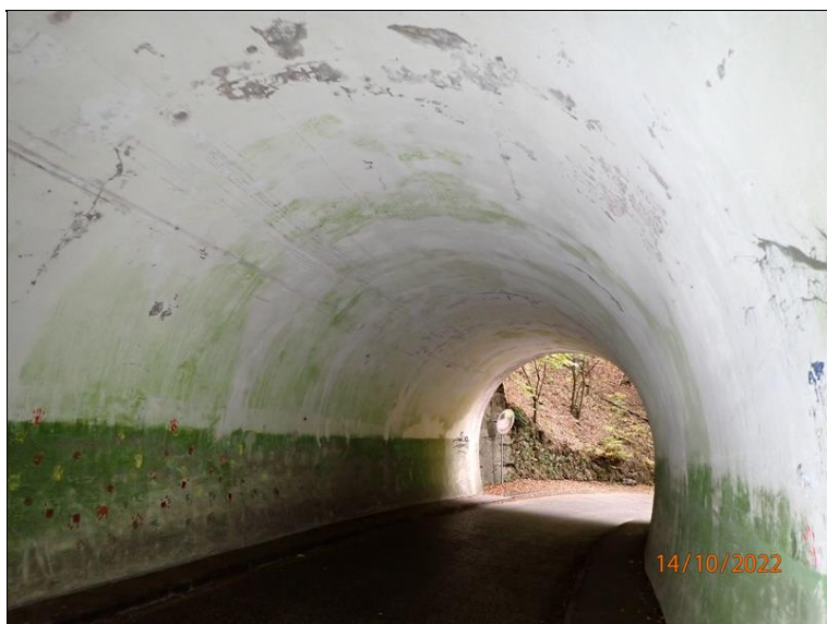
66 - Východní polovina betonové obezdívky tunelu v pohledu ze střední části tunelu od pravé opěry (po směru staničení).
