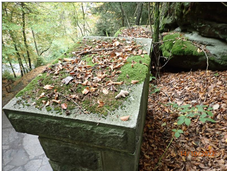
82 - 1. vnitřní sloupek (zleva) cimbuří východního portálu - pohled zleva.
