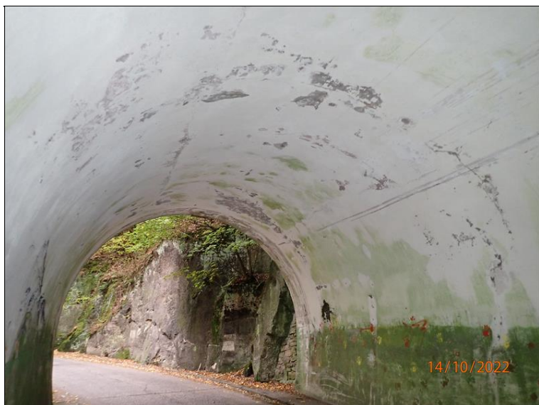
65 - Západní polovina betonové obezdívky tunelu v pohledu ze střední části tunelu od pravé opěry (proti směru staničení).
