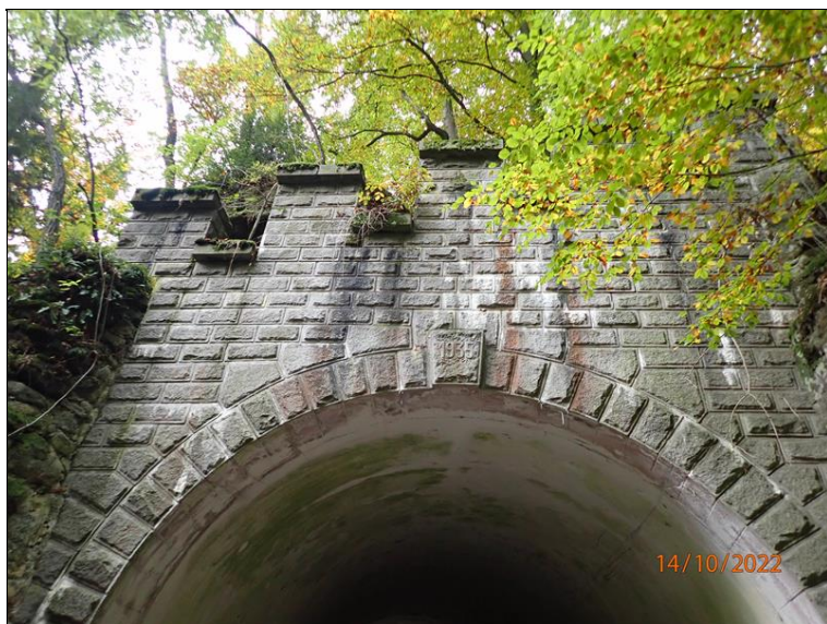
55 - Čelní zeď a cimbuří v horní části východního portálu v pohledu zdola z prostoru vozovky.
