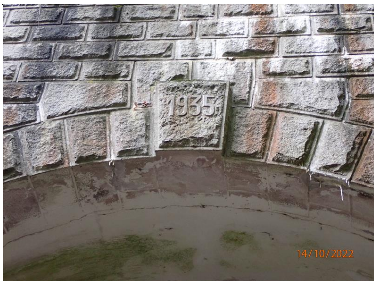
38 - Vrcholový klenák východního portálu s letopočtem zahájení výstavby tunelu.
