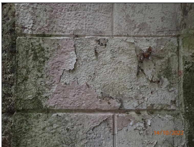
57 - Detail natřeného řádkového zdiva východního portálu (lokace viz předchozí snímek).
