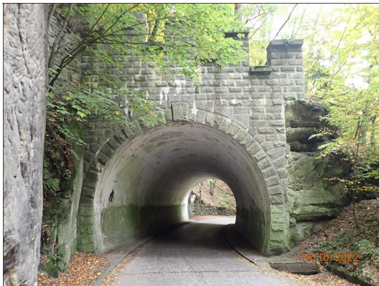
04 - Západní portál tunelu v bližším čelním pohledu (z III/2733)
