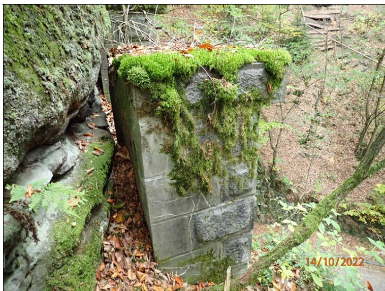
80 - Krajní (pravý) sloupek cimbuří východního portálu - pohled na vnější bok.
