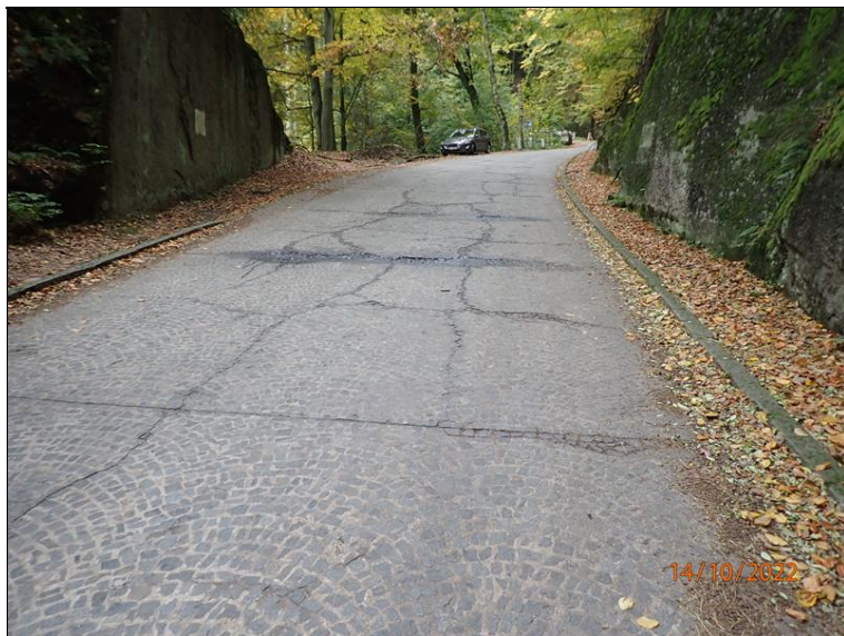
43 - Vozovka před západním portálem tunelu (pohled proti směru staničení).
