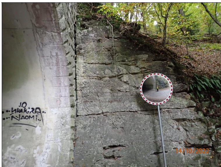
13 - Navazující zárubní zděná stěna a skalní masiv po levé straně východního portálu tunelu
