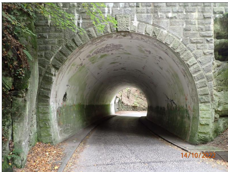
07 - Pohled do podjezdu od západního portálu (po směru staničení)
