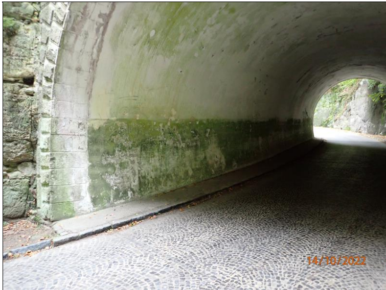
20 - Celkový pohled na pravou stranu tunelu (pravou opěru) od levé strany východního portálu
