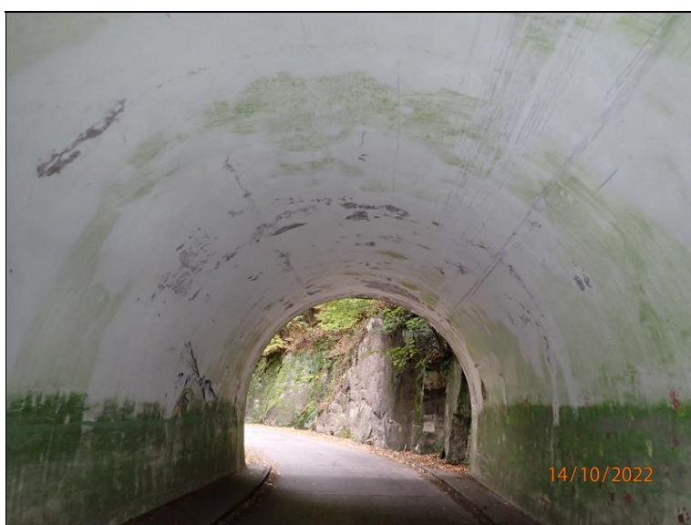
15 - Pohled zdola proti směru staničení III/2733 na západní polovinu podjezdu (tunelu)
