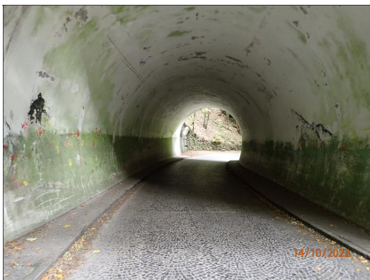
14 - Pohled po směru staničení III/2733 do podjezdu zpod západního portálu
