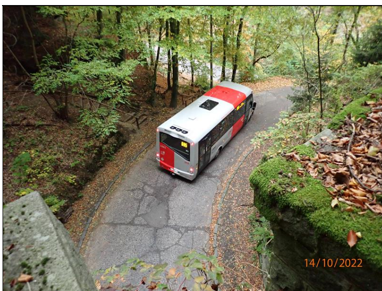
30 - Pohled shora na PK od cimbuří východního portálu tunelu (po směru staničení)
