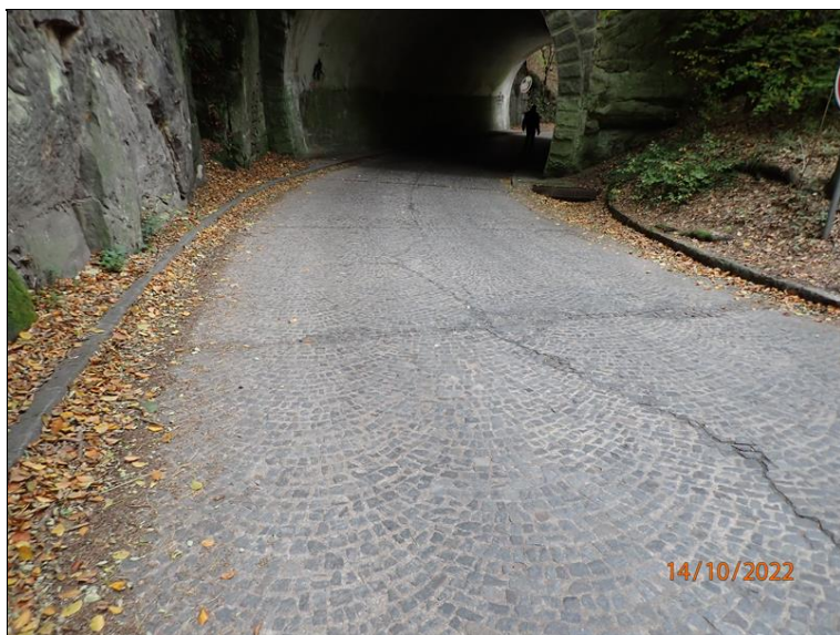
44 - Vozovka před západním portálem tunelu (pohled po směru staničení).
