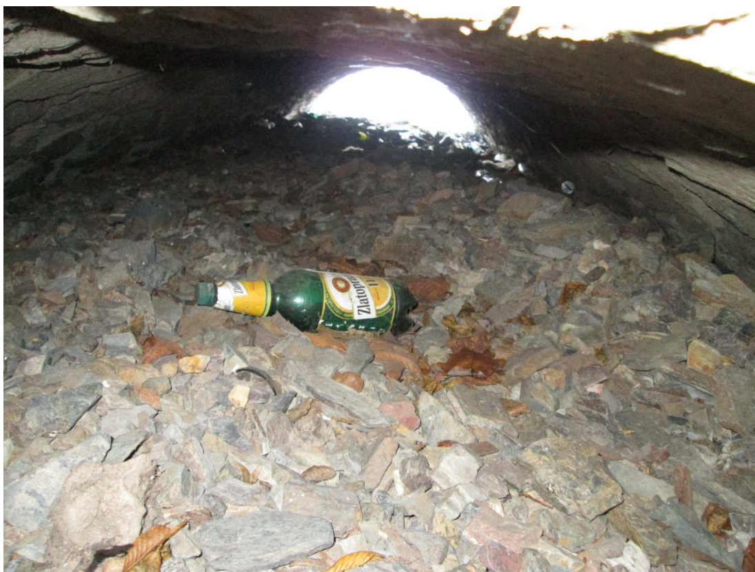
Mostní otvor zprava. Silné nánosy.
