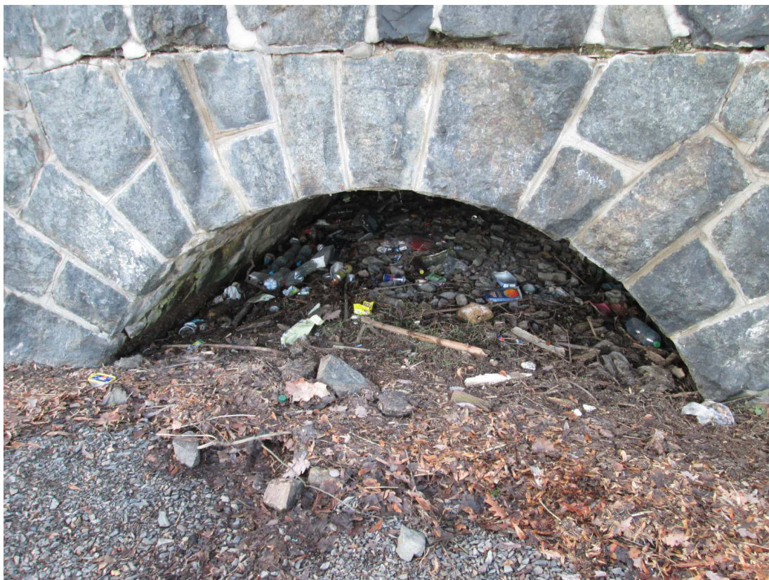
Mostní otvor zprava. Silné nánosy.
