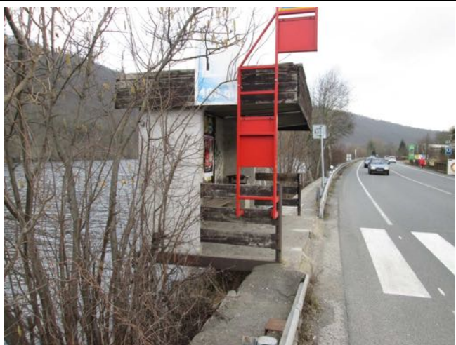
Přístřešek autobusové zastávky uložený na opěrné zdi.
