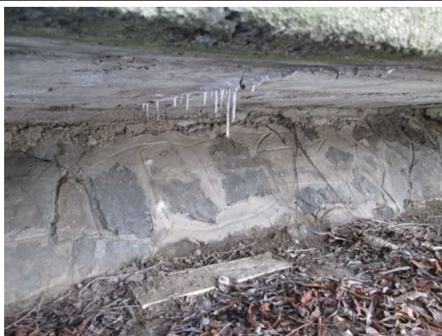
Konzola. Trhlina, silné průsaky, výluhy, krápníky.
