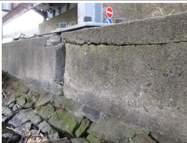
Delaminace horní části římsy.
