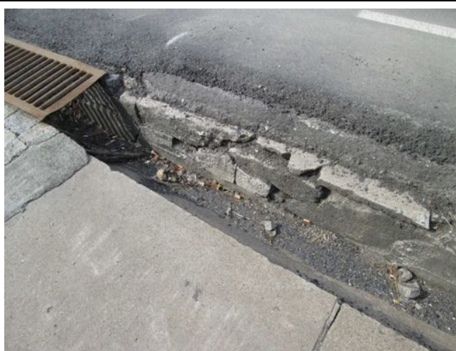
Masivní degradace betonu, rozpad.
