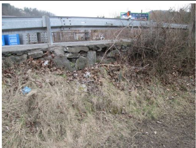
Masivně vydrolené spáry, rozvolněné zdivo, část kamenných bloků chybí.
