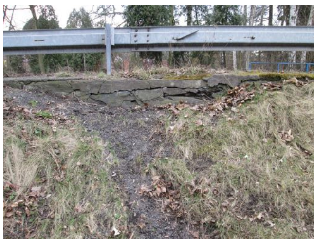
Masivně vydrolené spáry.
