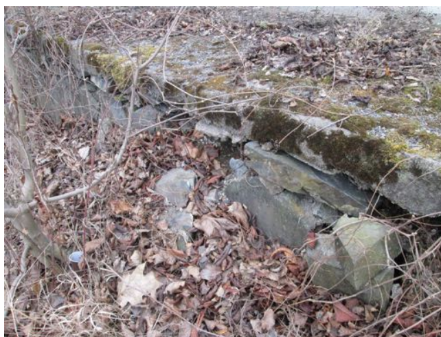
Masivně vydrolené spáry, rozvolněné zdivo.
