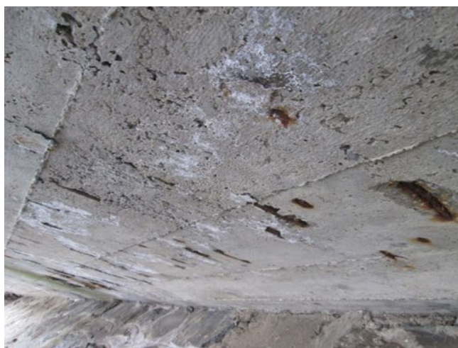
Podhled konzoly. Průsaky. Odpadlá krycí vrstva, koroze obnažené výztuže.
