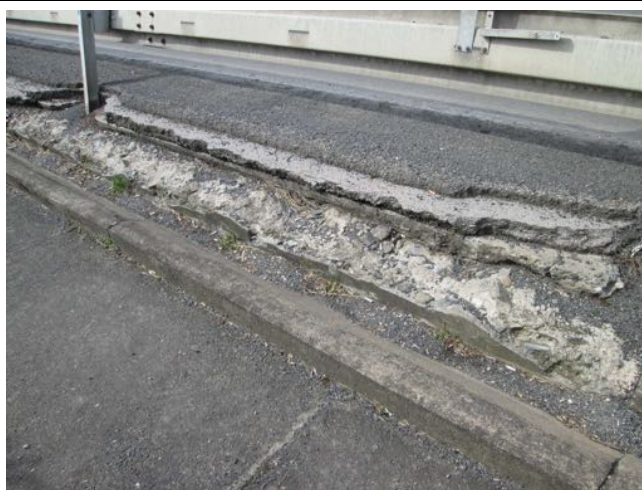
Masivní degradace betonu, rozpad. Část zdi chybí.
