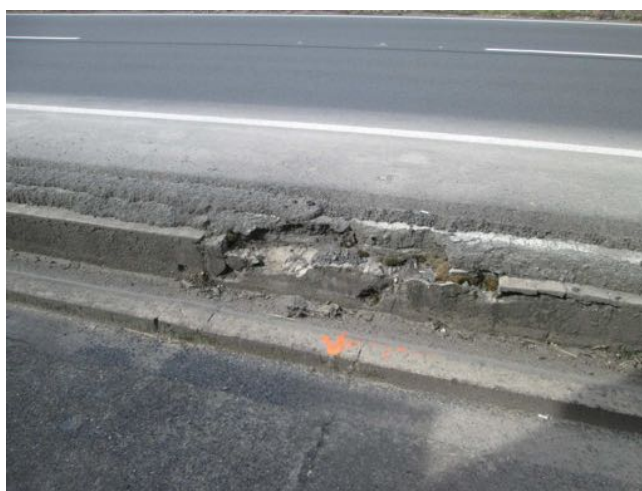
Masivní degradace betonu, rozpad.
