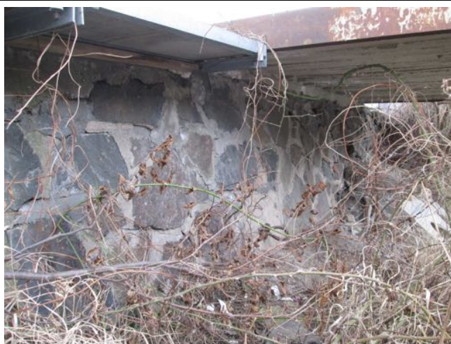
Stav zdiva pod přístřeškem autobusové zastávky. Lokálně vydrolené spáry.
