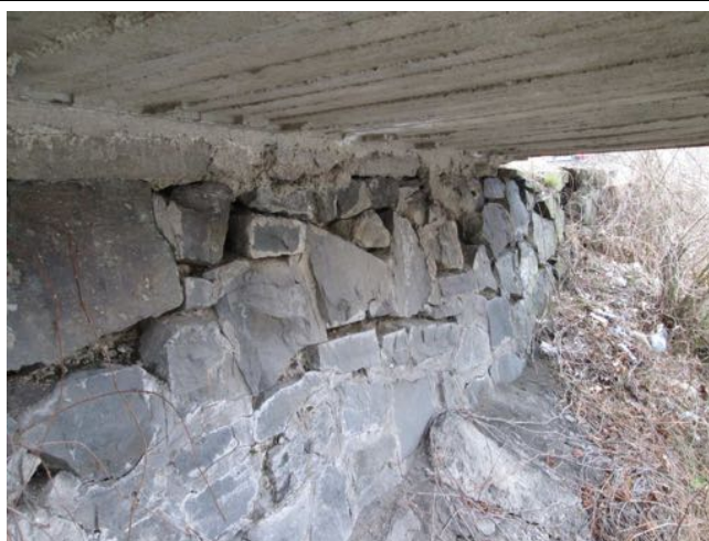
Stav zdiva pod přístřeškem autobusové zastávky. Masivně vydrolené spáry.
