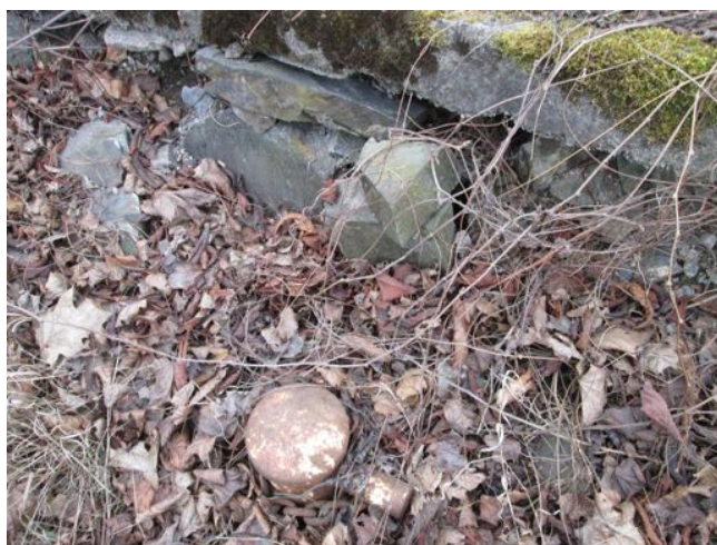
Masivně vydrolené spáry, rozvolněné zdivo.
