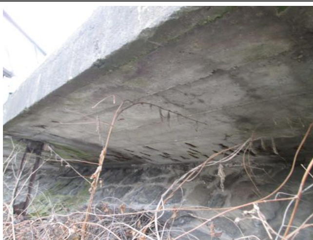
Podhled konzoly. Stopy zatékání. Bionapadení.
