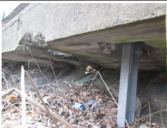
Sloupek svodidla proražený konzolou. Otevřená dilatační spára.
