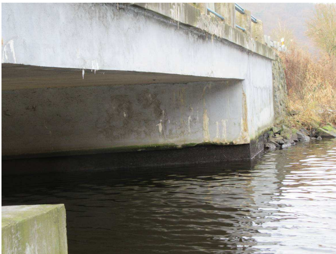
OP1 vlevo. Trhlíny, výluhy na opěře a NK. Výluhy a krápníky na římse.
