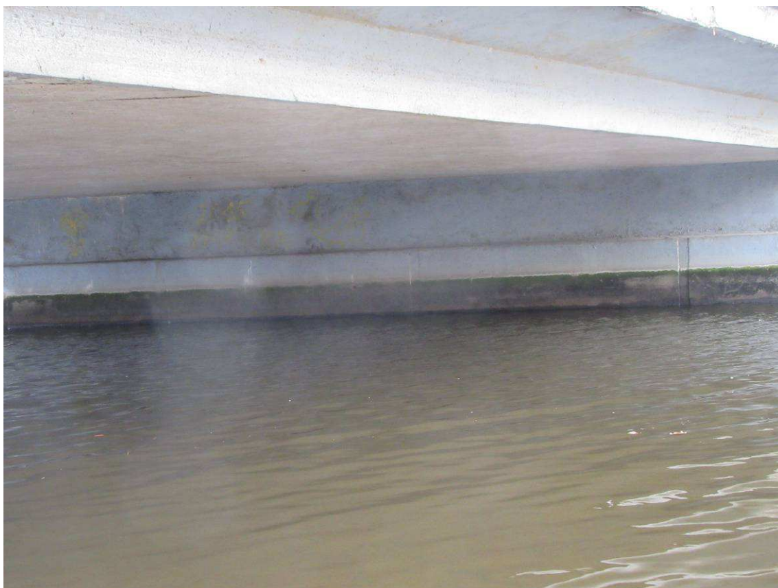
OP2. Trhliny a výluhy.
