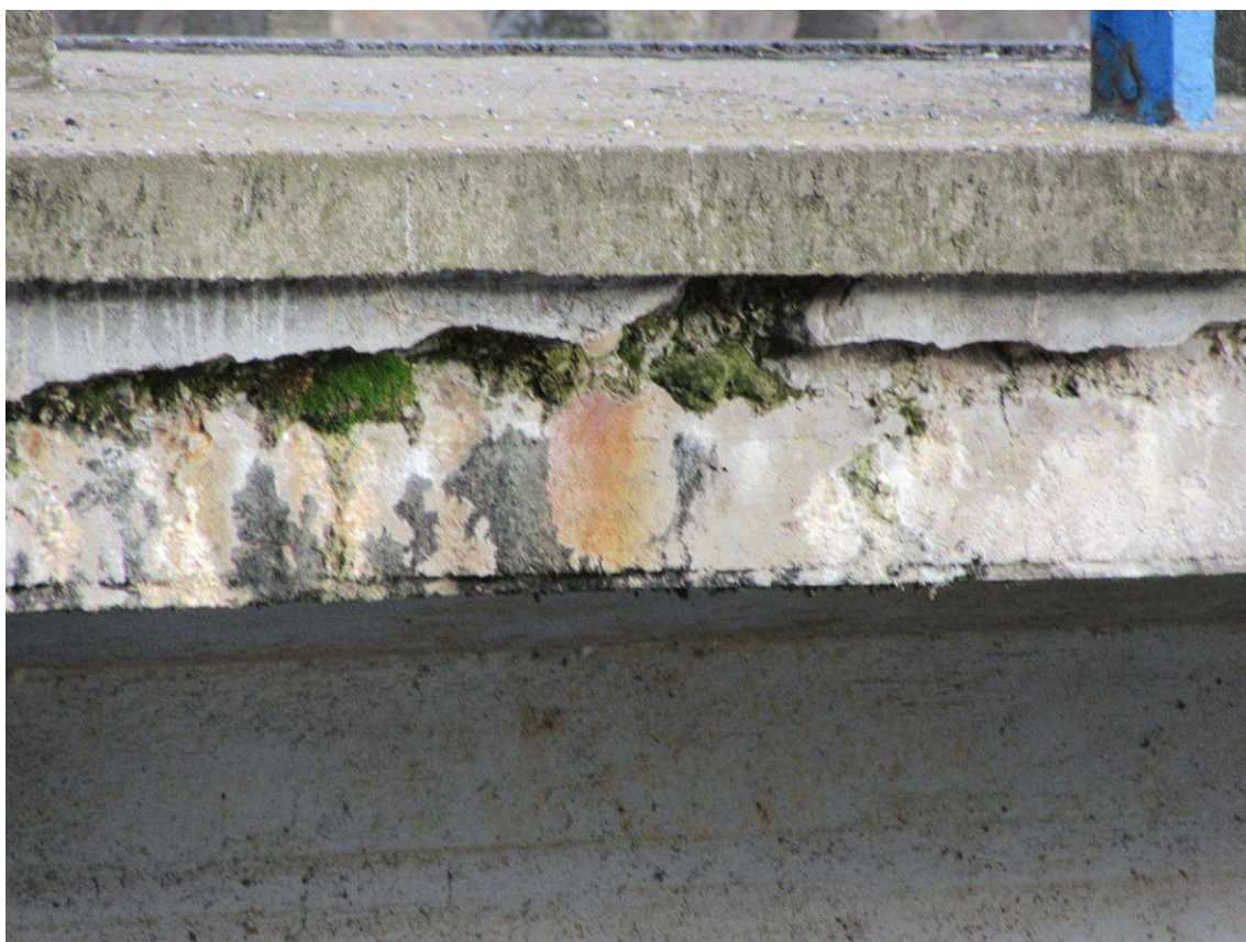
Pravý bok. Opadaná omítka, degradace betonu, povrchový rozpad, biologické napadení.
