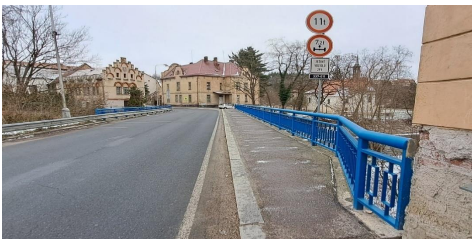
Obr 12: Pohled na most ev.č. 337-011 proti směru staničení
