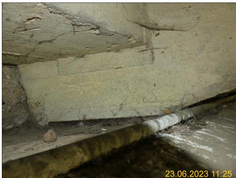
Uložení na OP2
