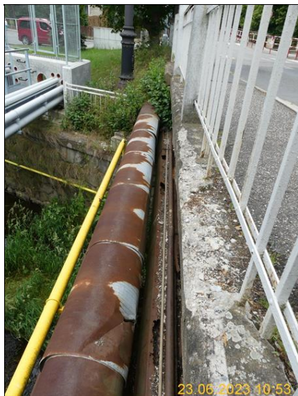
Levá římsa a potrubí podél mostu
