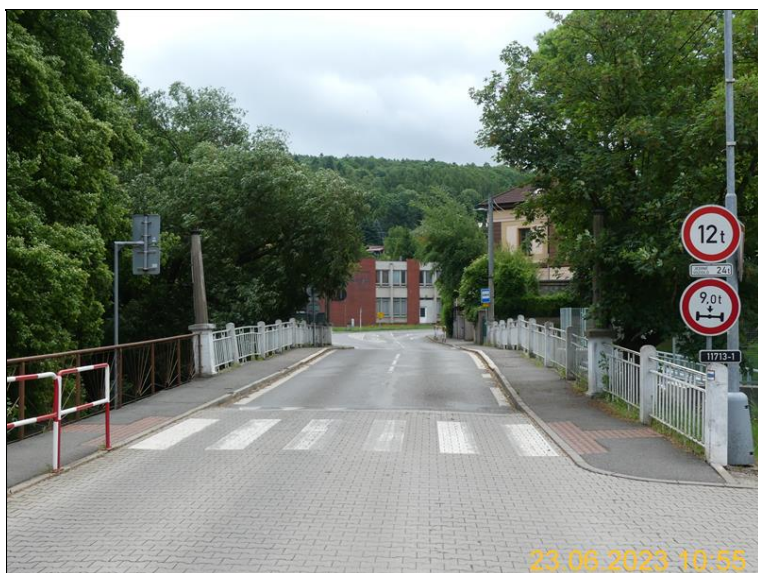
Celkový pohled proti směru staničení
