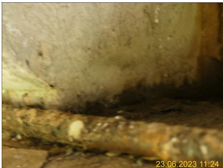
Uložení na OP1
