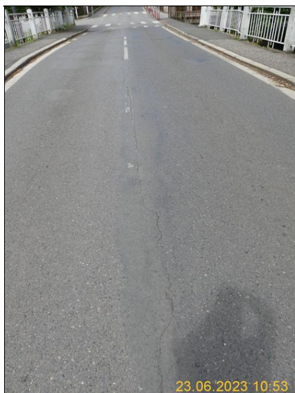
Trhlina na vozovce v ose mostu
