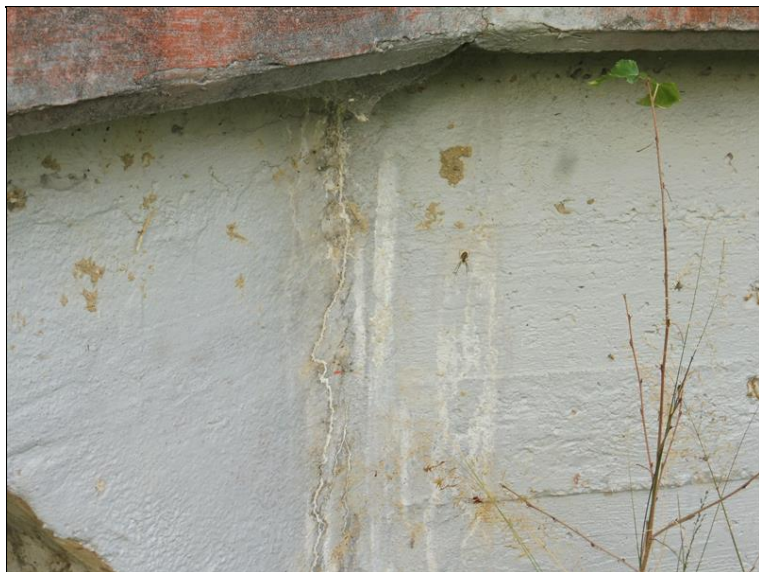
Potečené KŘ2P + svislá trhlina s výluhy.
