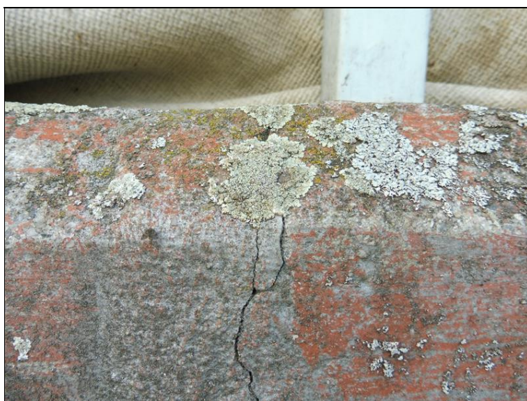
Trhlina v P římse.
