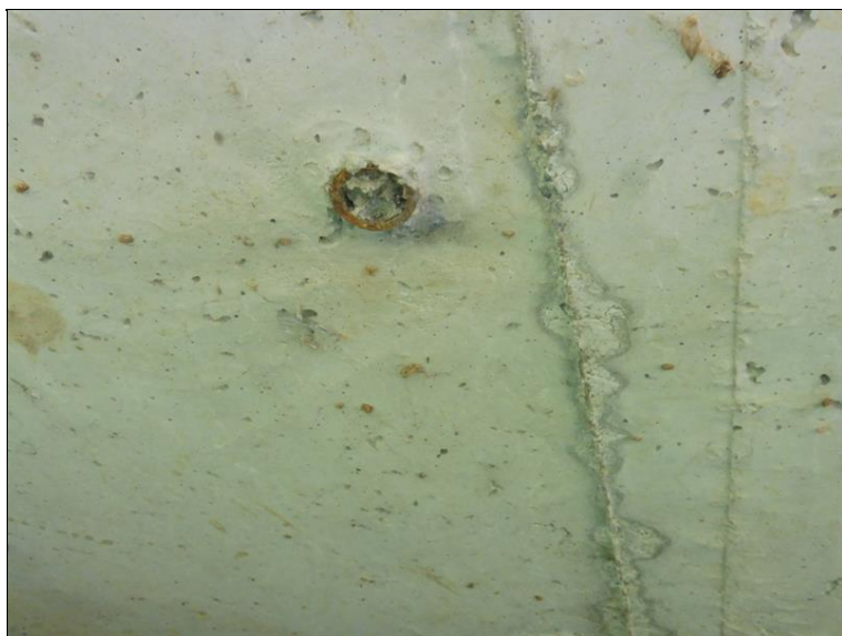
Koroze ocel. prvku (trubku) v NK.
