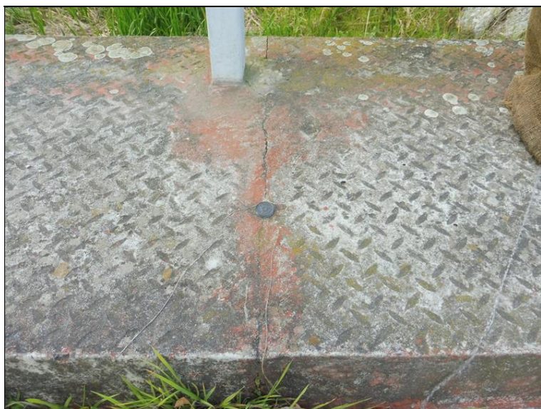
Trhlina v L římse.
