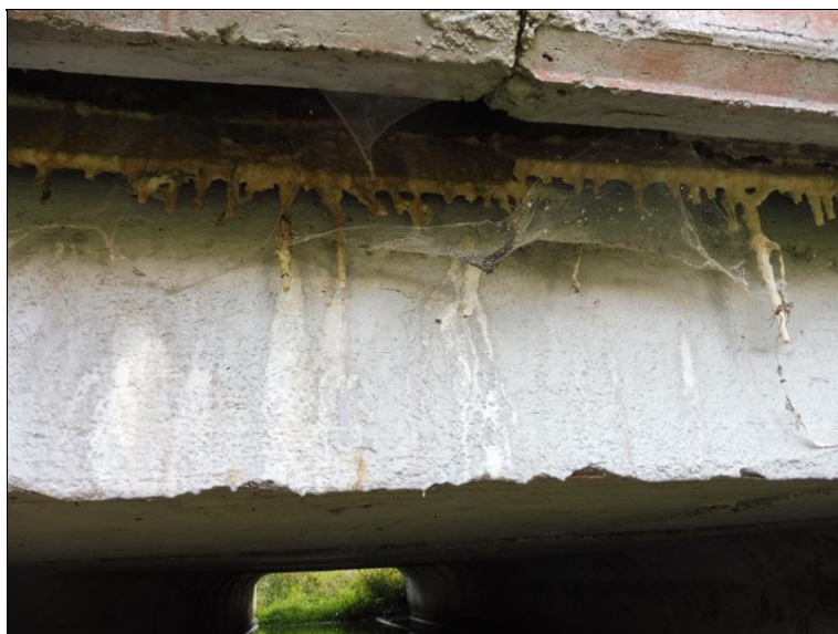
Krápníky na okapní hraně izolace mostovky v L.
