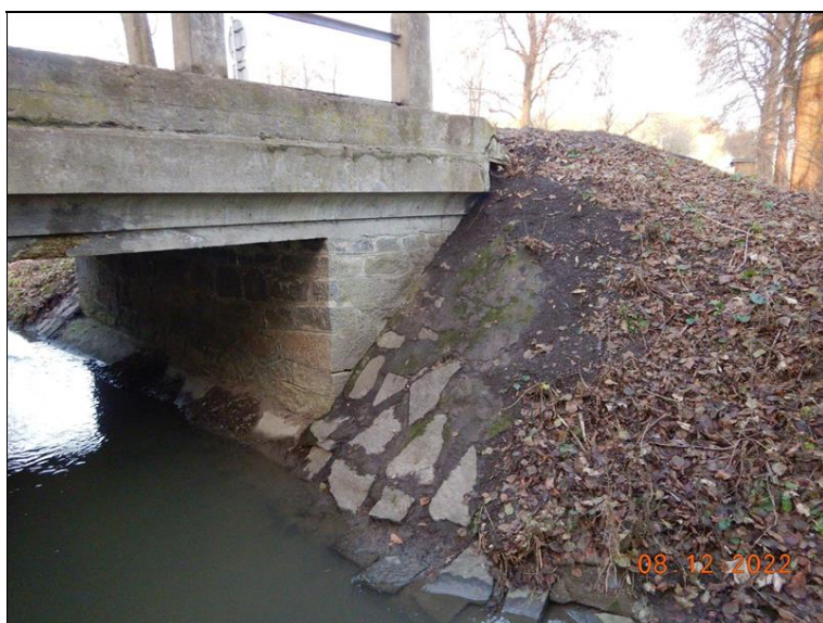
Pohled na levé křídlo opěry O1 a opevnění svahového kuželu
