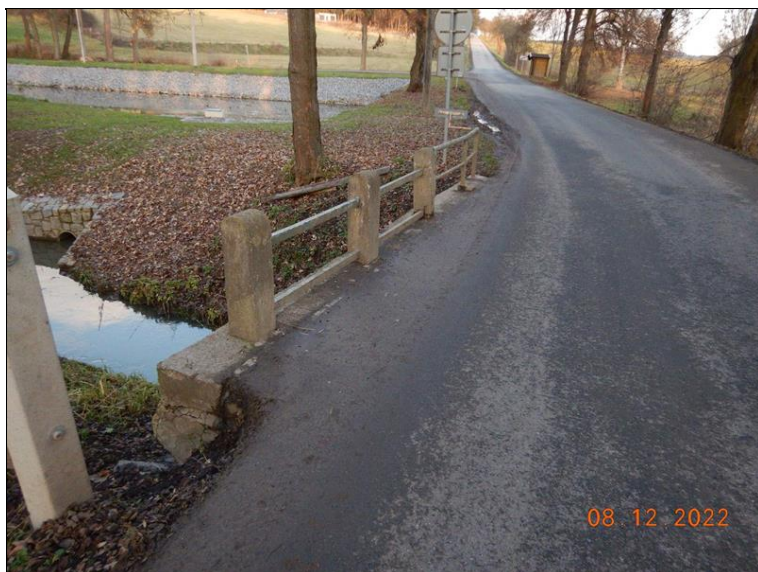
Pohled na pravou římsu mostu proti směru staničení - nevyhovující ukončení římsy a zábradlí vpravo za mostem.
