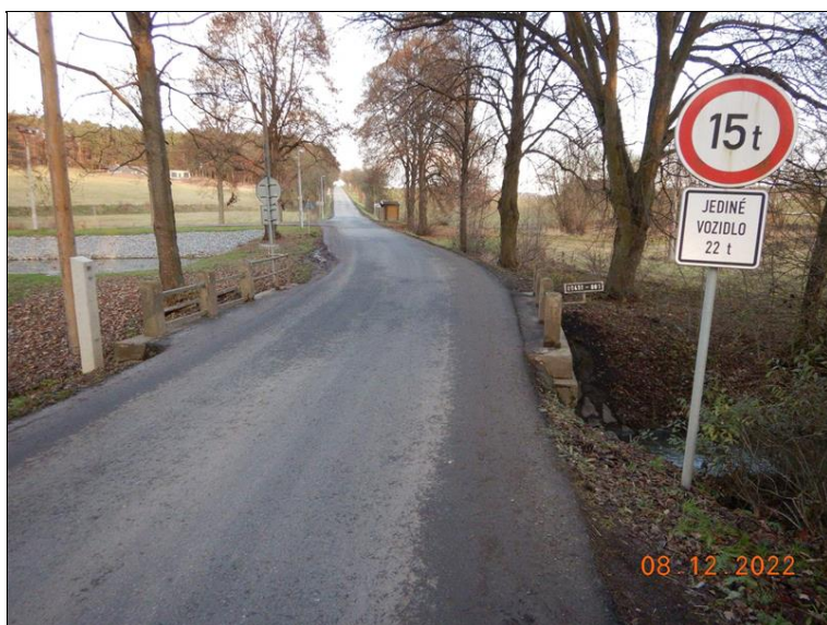
Celkový pohled na most proti směru staničení - uspořádání na mostě, chybějící zachytňý systém vlevo za mostem
