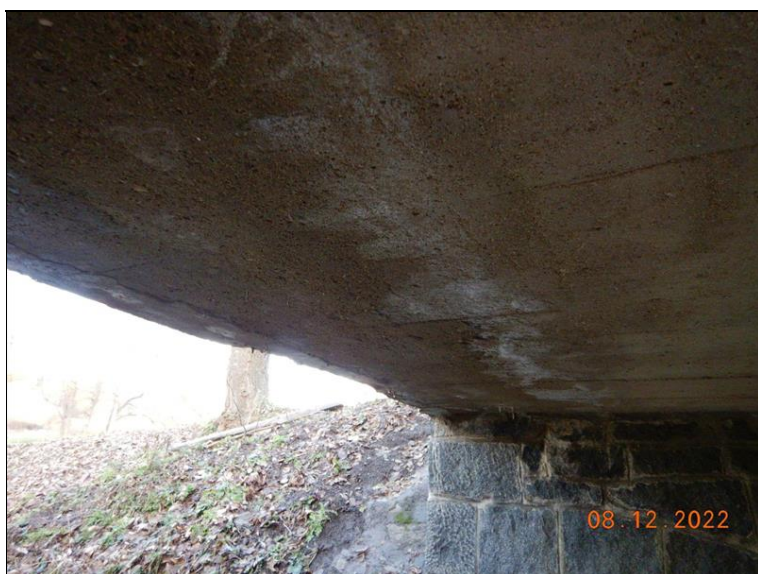
Podhled nosné konstrukce vpravo - zatékání na spodní líc nosné konstrukce
