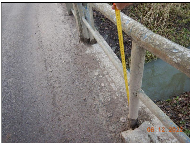
Pohled na zábradlí na mostě vpravo- výška max. 750 mm, vozovka přebalena do úrovně horní hrany římsy.
