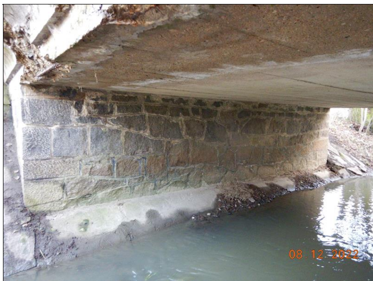
Pohled na opěru O1 zprava a podhled nosné konstrukce vpravo - zatékání přes římsu, lokální poškození opevnění koryta pod mostem.
