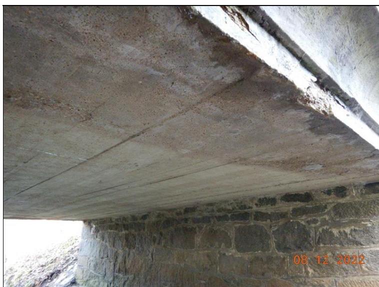
Pohled na opěru O1 a podhled nosné konstrukce zprava - lokální poškození betonu NK vlivem zatékání pod římsou.
