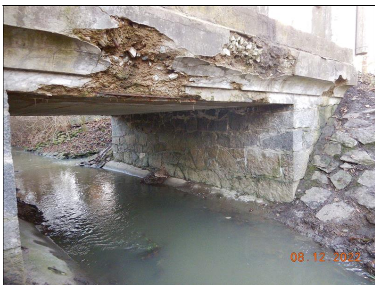
Pohled na opěru O2 zprava, poškození římsy a nosné konstrukce vpravo vlivem zatížení přes římsu.
