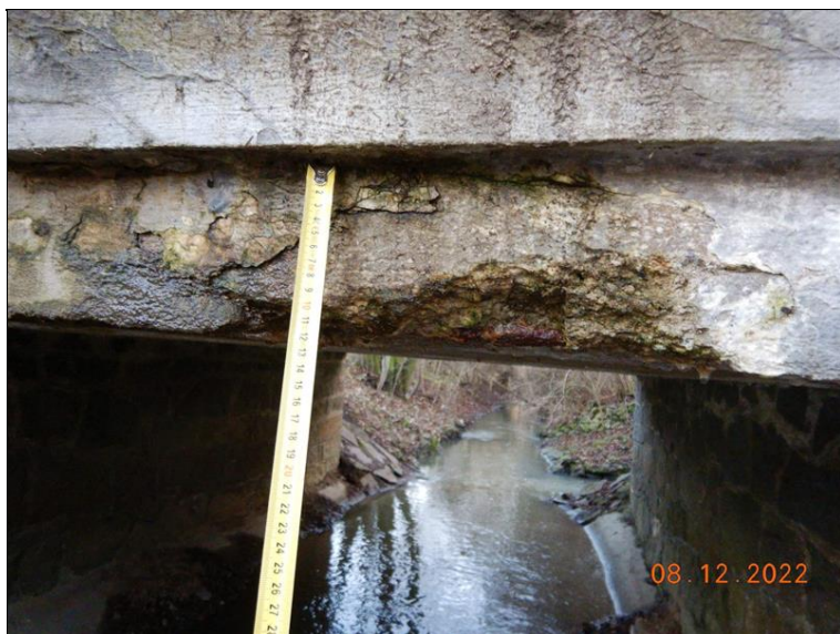
Detail poškození betonu nosné konstrukce vpravo vlivem zatékání - obnažená korodující výztuž desky.
