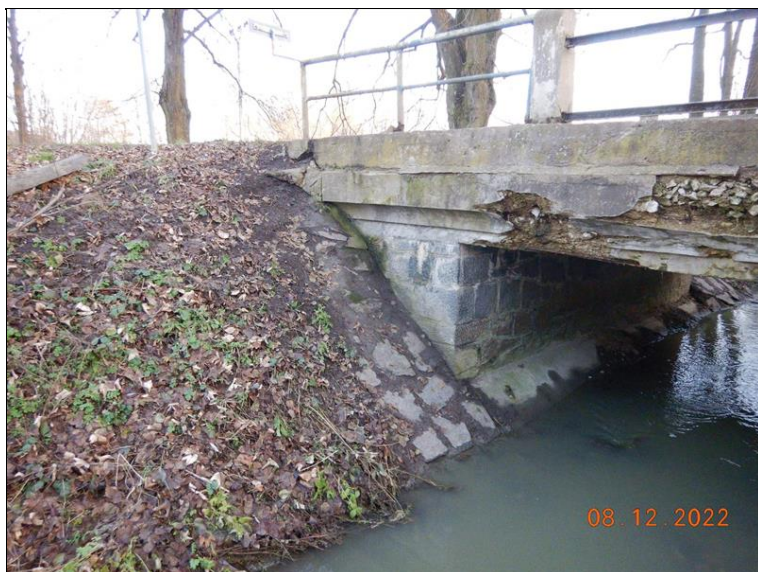
Pohled na pravé křídlo opěry O1 a římsu zprava - zatékání přes římsu a degradace betonu římsy a nosné konstrukce
