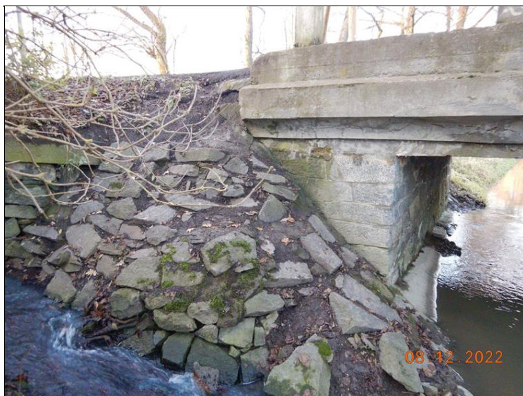
Pohled na levé křídlo opěry O2 a opevnění svahového kuželu - nevyhovující napojení římsy na krajnici vlevo u opěry O2
