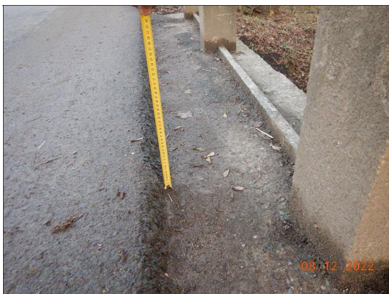
Detail přebalení vozovky vlevo na mostě - až 8 cm nad úroveň horní hrany římsy
