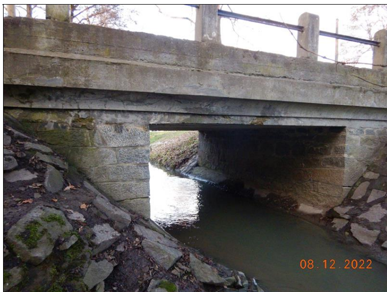
Pohled na most zleva - lokální zatékání přes římsu a degradace betonu nosné konstrukce
