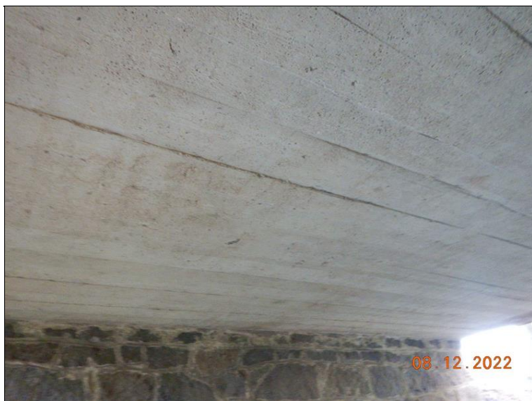
Typický stav na pohledu nosné konstrukce - bez poruch
