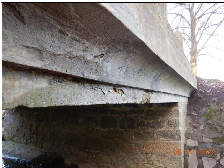
Detail poškození nosné konstrukce vlevo na mostě - bez obnažení betonářské výztuže
