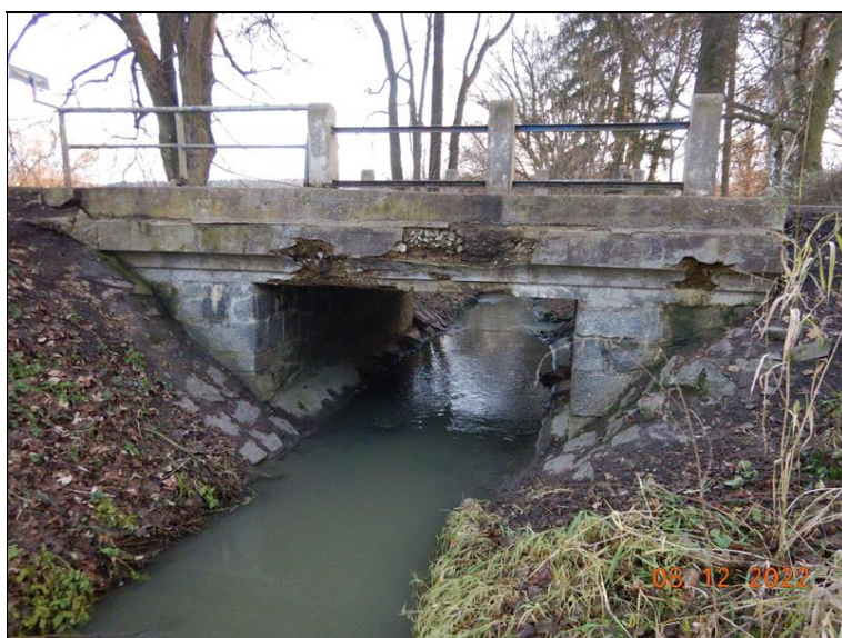
Pohled na most zprava - zatékání přes římsu a degradace betonu římsy a nosné konstrukce
