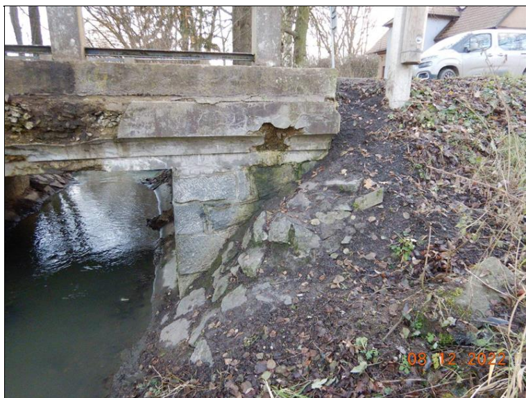
Pohled na pravé křídlo a opevnění svahového kuželu opěry O2, zatékání pod římsou na křídle
