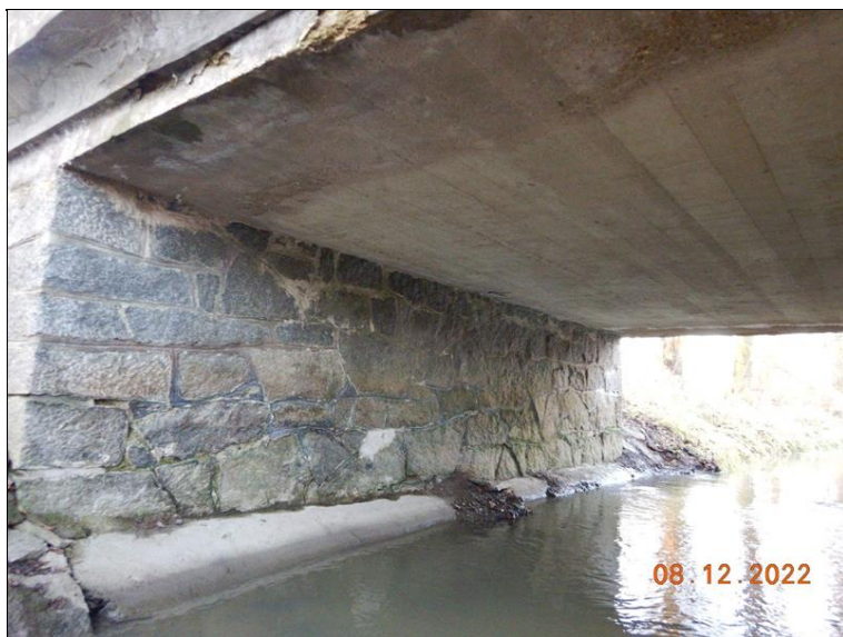
Pohled na opěru O2 zleva - lokální poškození opevnění koryta pod mostem
