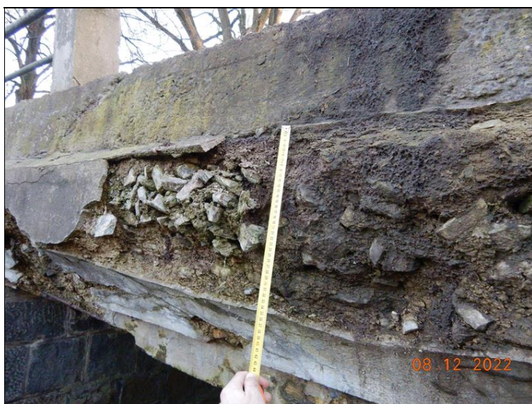
Detail poškození betonu římsy vpravo vlivem zatékání.
