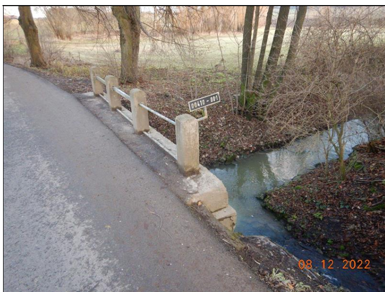
Pohled na levou římsu od opěry O2 - nevyhovující ukončení římsy a zábradlí vlevo na opěře O2
