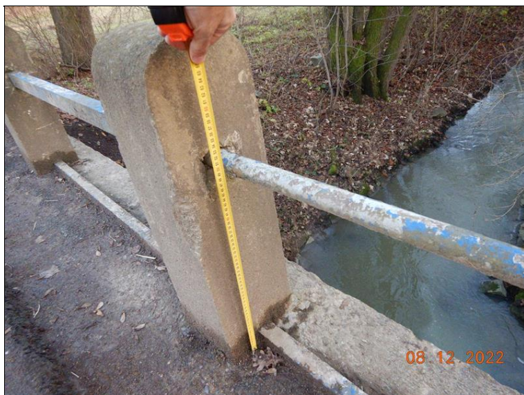
Pohled na zábradlí na mostě vlevo - výška max. 600 mm, vozovka přebalena cca 8 cm nad úroveň horní hrany římsy.
