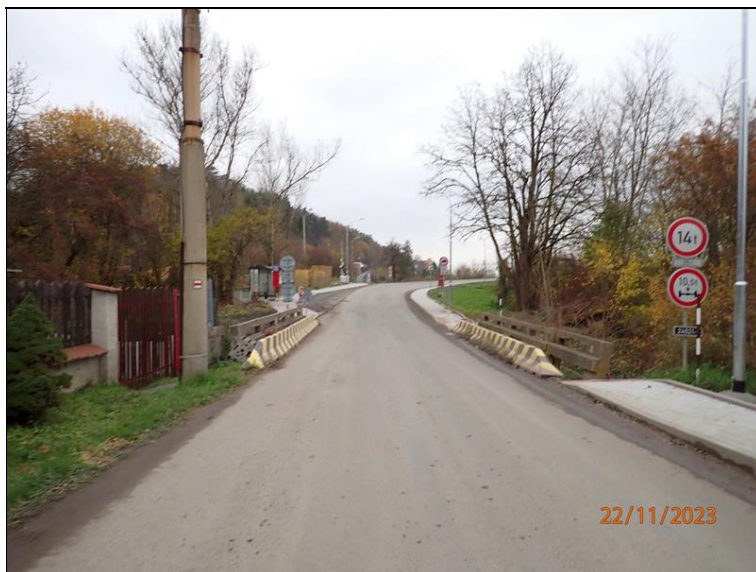
01 po směru staničení.JPG
