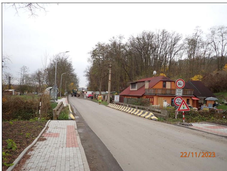
02 proti směru staničení.JPG
