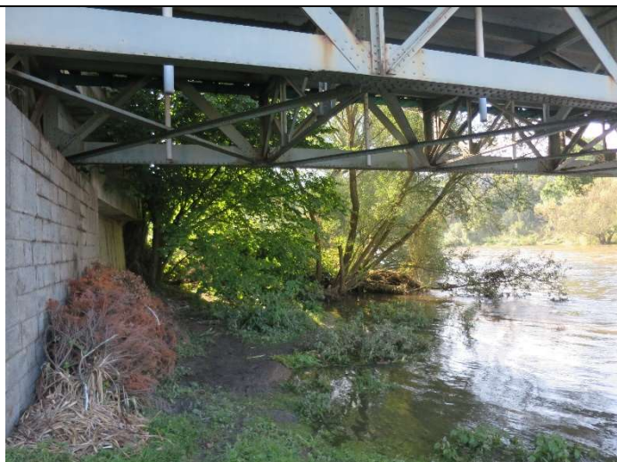
Foto č. 7: Pravobřežní mostní opěra.
