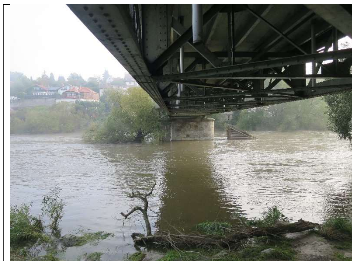
Foto č. 1: Podhled přemostění.
