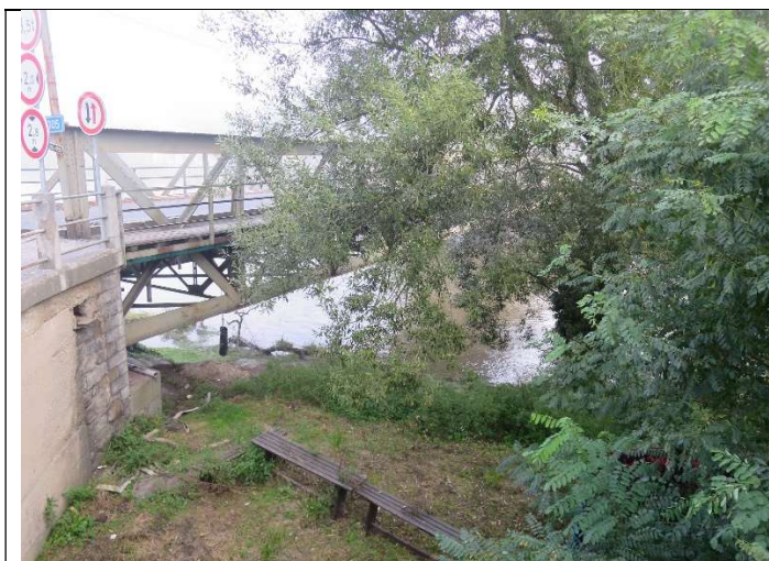
Foto č. 5: Levobřežní mostní opěra.
