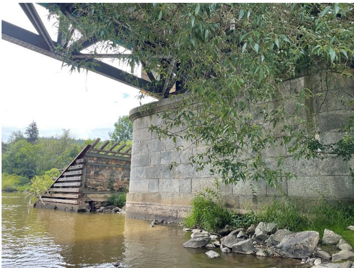
Obrázek 10: Mostní pilíř s přítomností balvanů, zdroj: vlastní, 6/2024.
