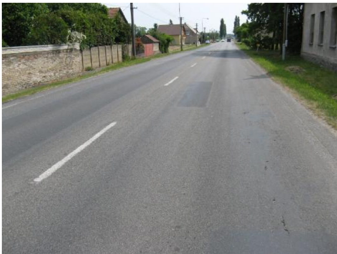
F67, km 36,187+ Vyjeté koleje, mozaikové trhliny v jízdní stopě.
