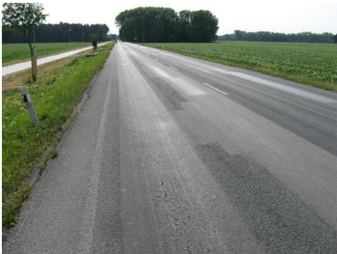
F04, km 31,087+ Mozaikové trhliny v jízdní stopě, cca 30 % povrchu ošetřeno nátěrem.
