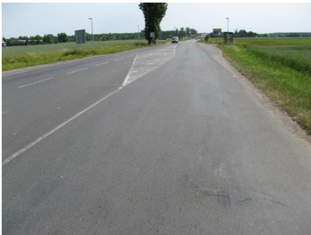
F75, km 36,787+ Vpravo rozvětvené trhliny.
