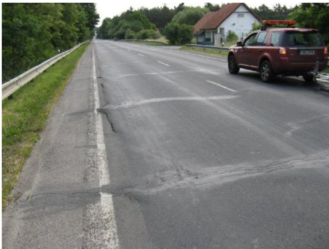
F37, km 33,677+ Příčné rozvětvené trhliny, hrboly, vyjeté koleje.
