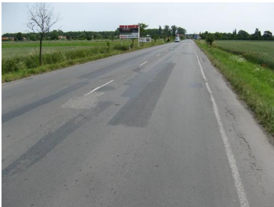
F79, km 37,087+ Koroze EKZ ošetřená vysprávkami.
