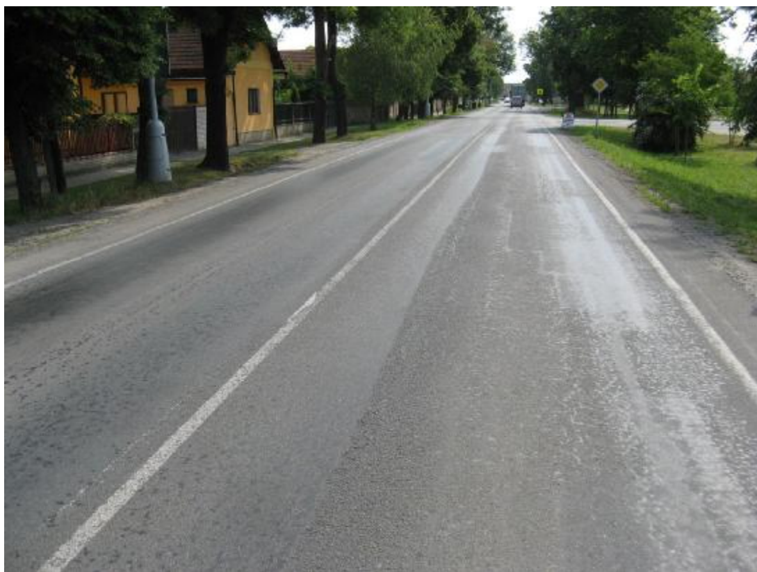
F24, km 32,677+ Ztráta makrotextury v jízdnicích stopách.
