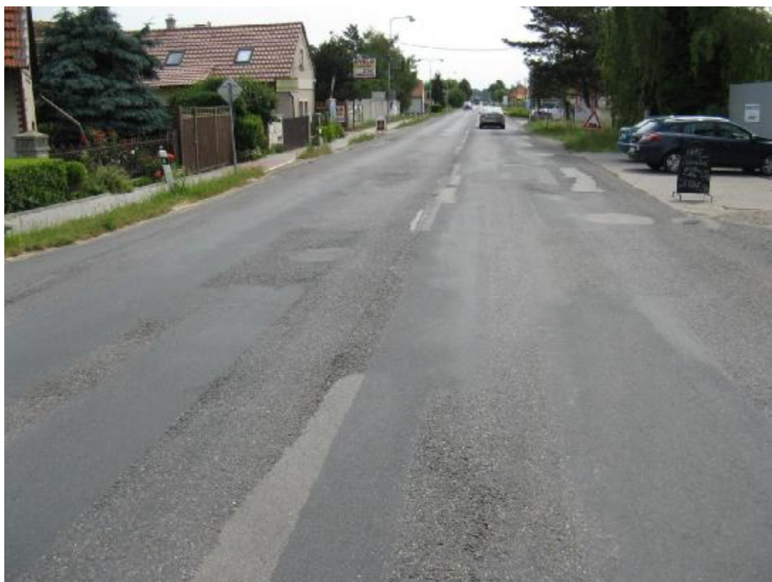
F54, km 34,987+ Hlubková koroze, vysprávkky, vyjeté koleje.
