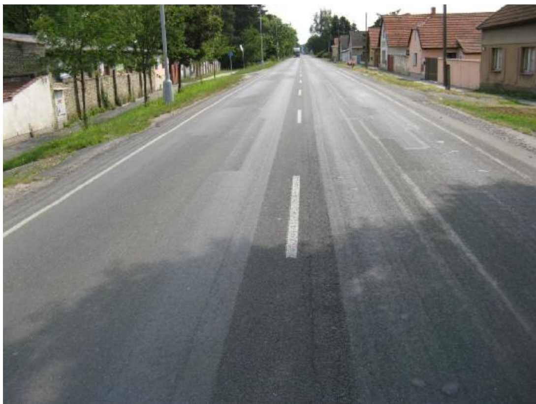
F30, km 32,670+ Mozaikové trhliny uprostřed, cca 30 % povrchu ošetřeno nátěrem.
