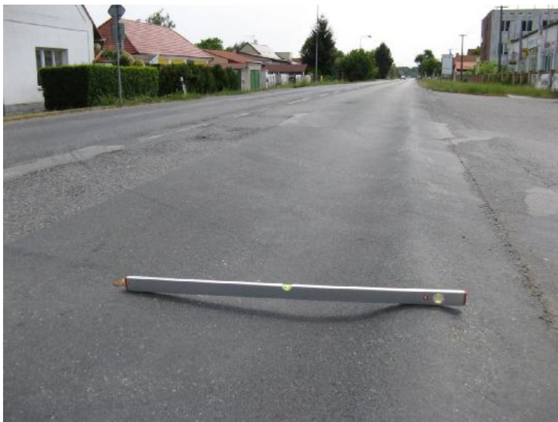
F58, km 35,097+ Vyjeté koleje, před vjezdem ZS Písková Lhota.
