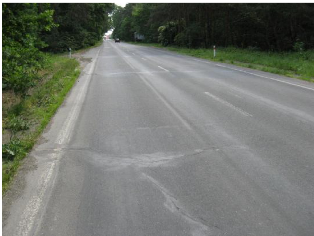
F44, km 34,177+ Příčné rozvětvené trhliny s hrboly.
