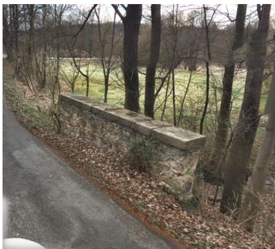
Nebezpečné čelo propustku
