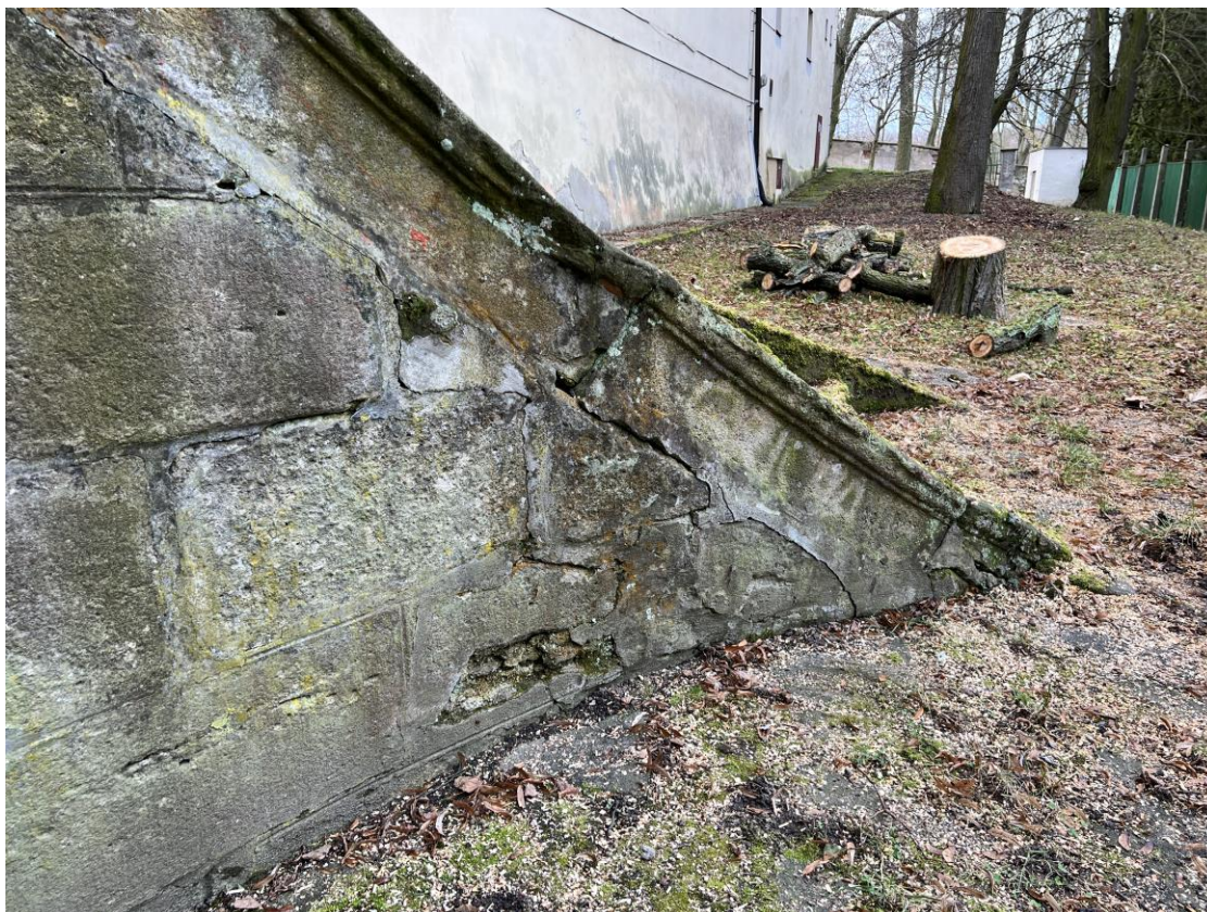
Detail rozvolněných a poškozených dílů trnože zábradlí
