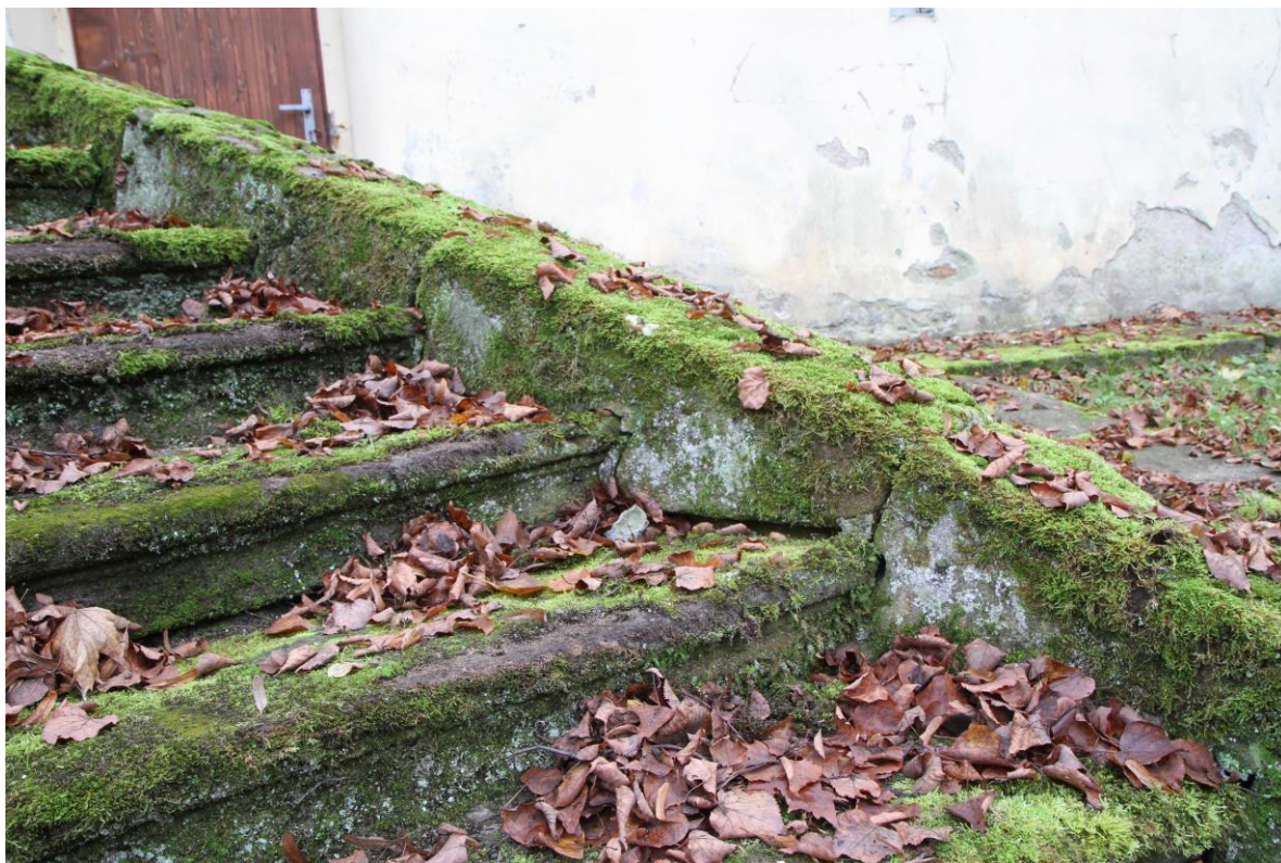
Detail rozestoupených dílů trnože zábradlí
