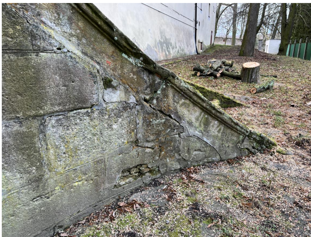
Spodní část pravého (západního) ramene schodiště s navýšeným terénem a kamennou dlažbou
