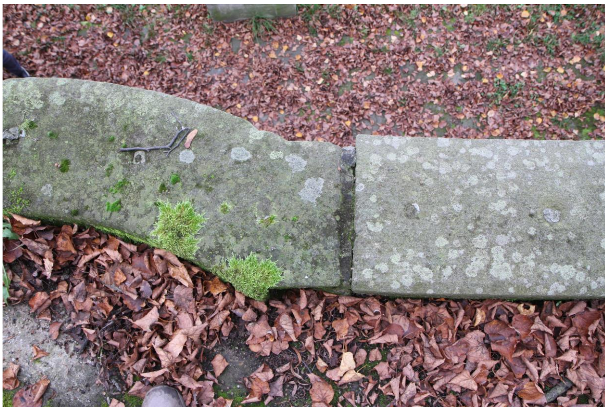
Detail nenavazující části trnože zábradlí na podestě
