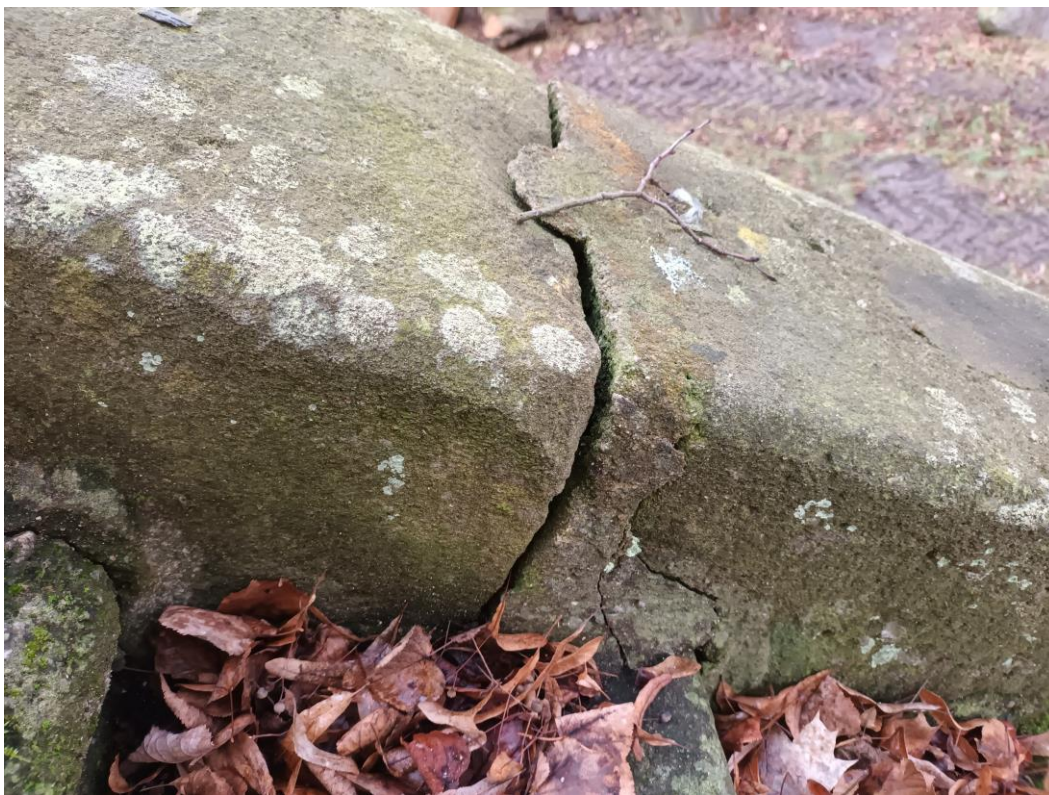
Detail rozvolněných dílů trnože zábradlí
