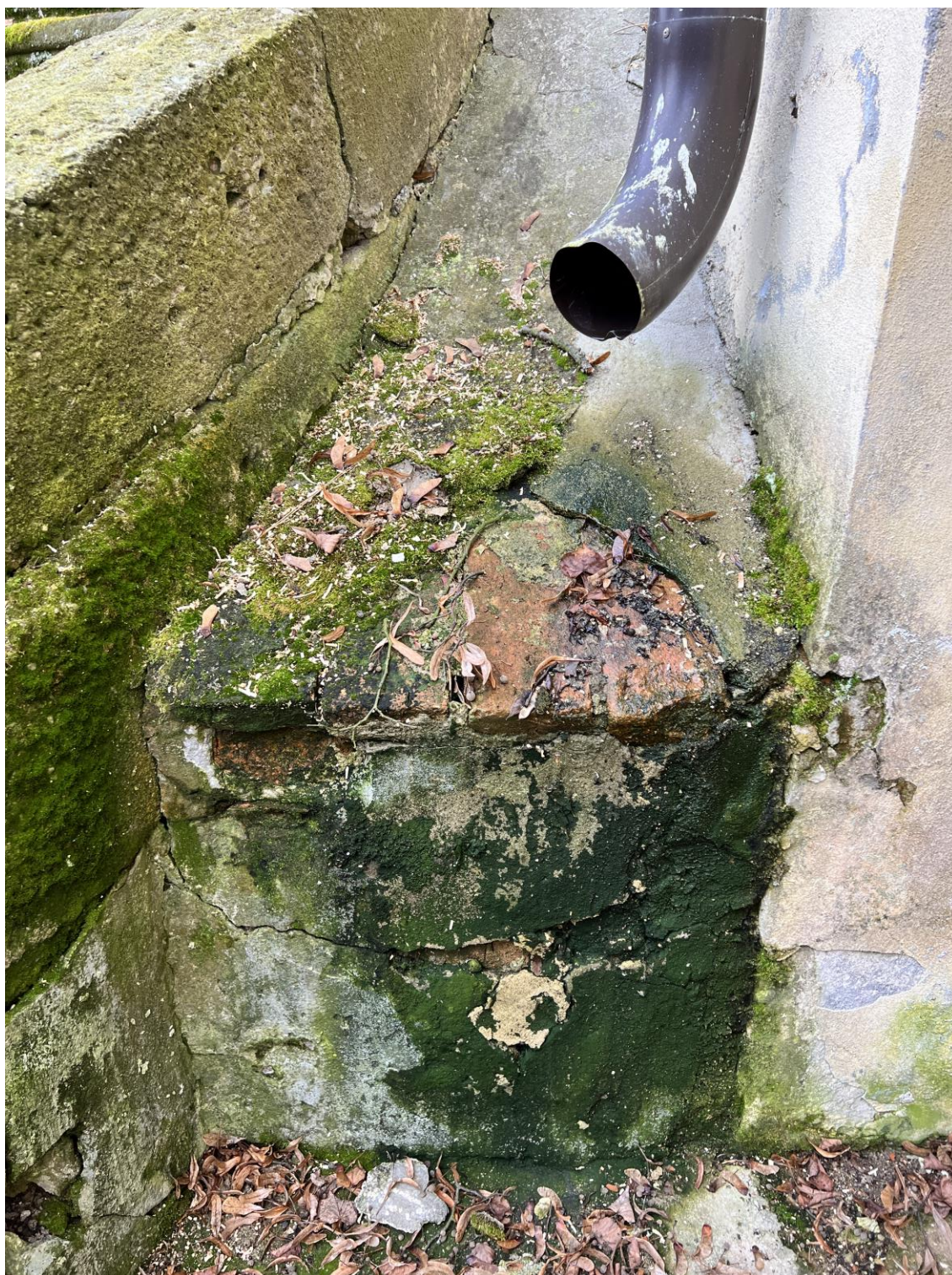
Detail vyzdívky pod okapovým svodem na západní straně schodiště
