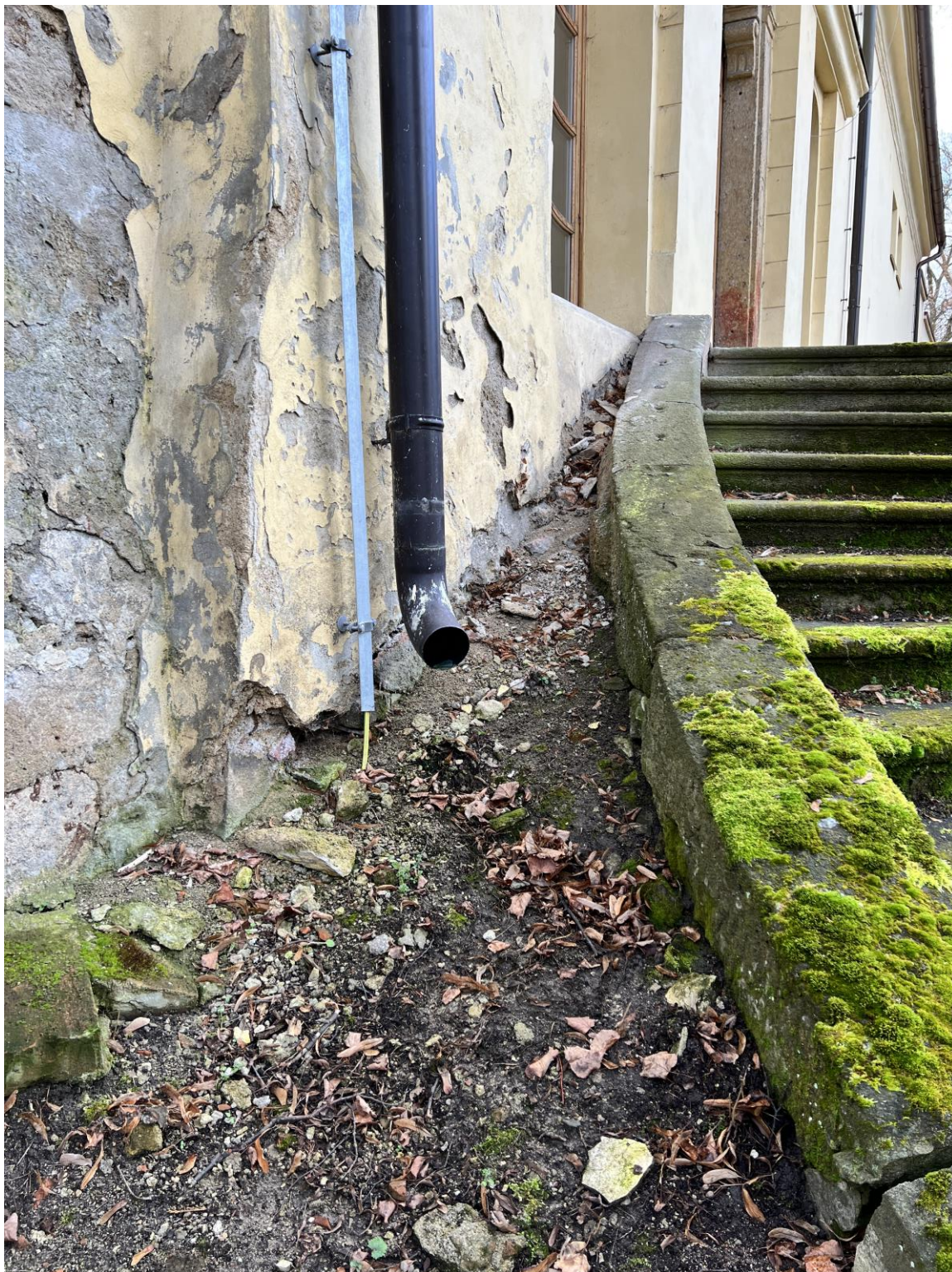
Navršený terén a okapový svod na východní straně schodiště
