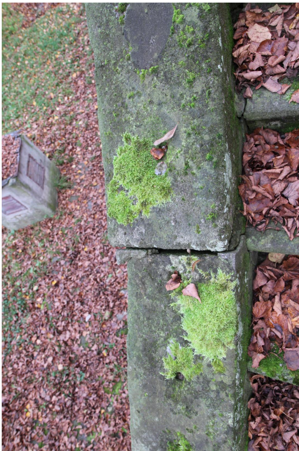
Detail rozvolněných dílů trnože zábradlí
