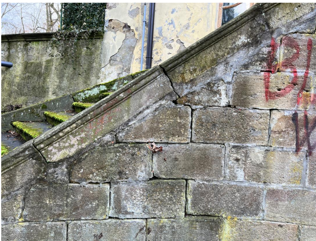
Detail rozvolněného zdiva a dílů trnože zábradlí
