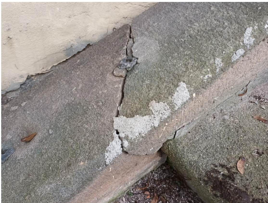
Detail prasklého dílu trnože zábradlí
