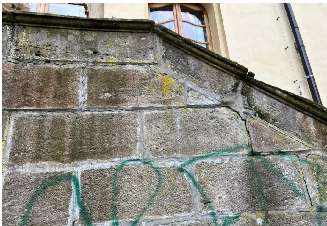
Detail rozvolněných a poškozených dílů trnože zábradlí
