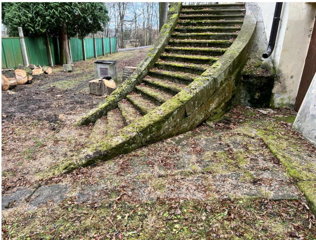
Navýšený terén, vyzdívka pod okapem, novodobá dlažba a odtokový kanál u západního ramene schodiště
