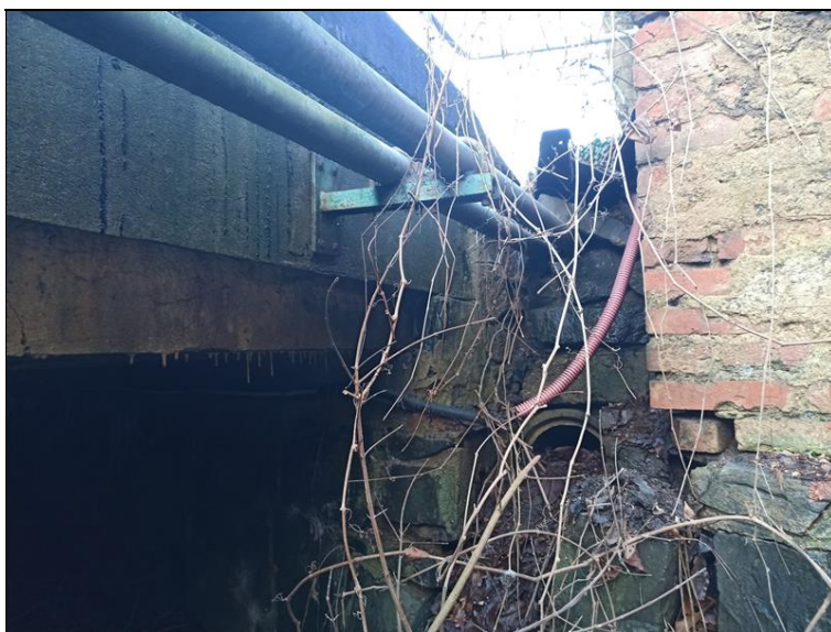
římsa se zavěšením sítí
