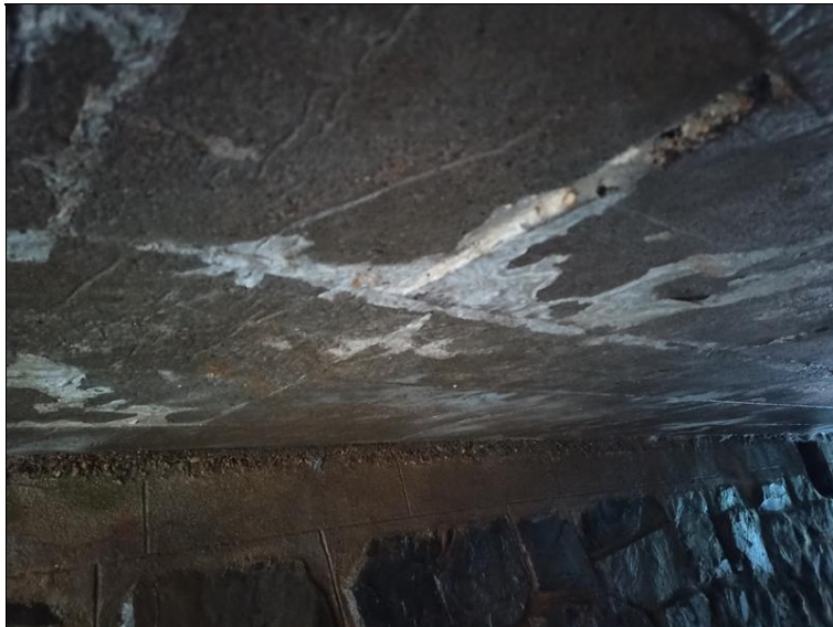
Výluhy pojiva na podhledu mostovky.
