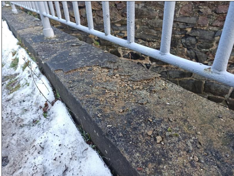
detail degradovaného horního povrchu pravé římasy
