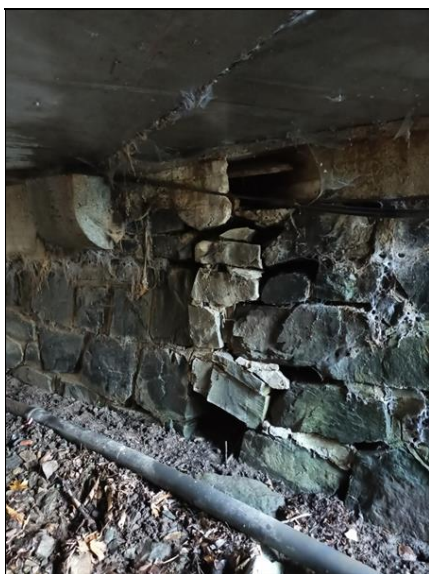
Opěra OP1 - detail rozpadání kamenného zdiva
