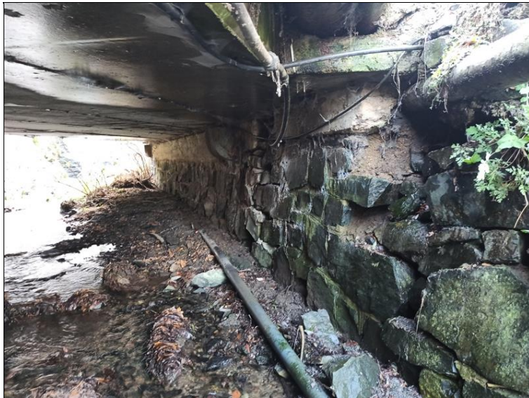
Opěra OP1 - detail rozpadání kamenného zdiva
