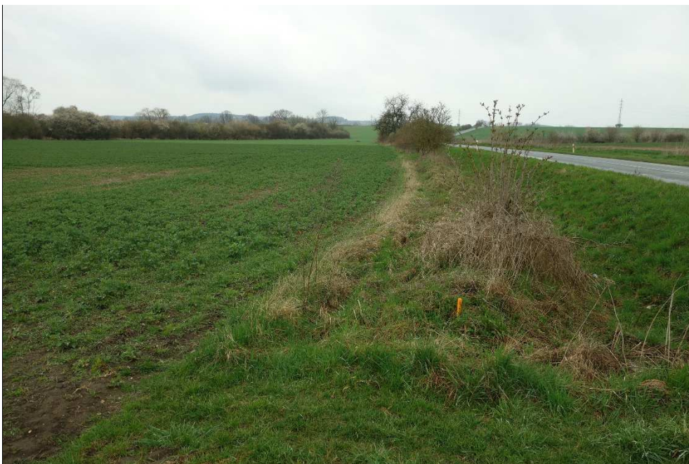
Obrázek 7: Konec obchvatu v místě napojení na stávající trasu silnice II/272.
