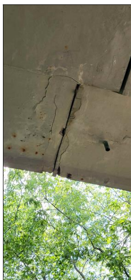
Ozub 1 - detail poškození
