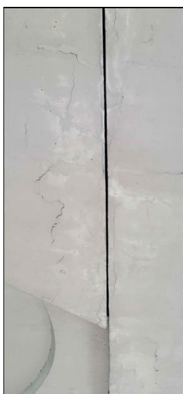
Ozub 3 - separace betonu podél spáry
