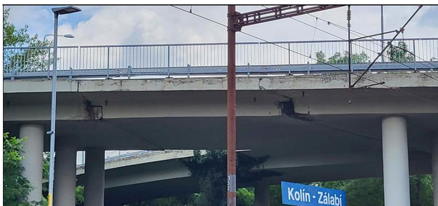
Pohled na most
