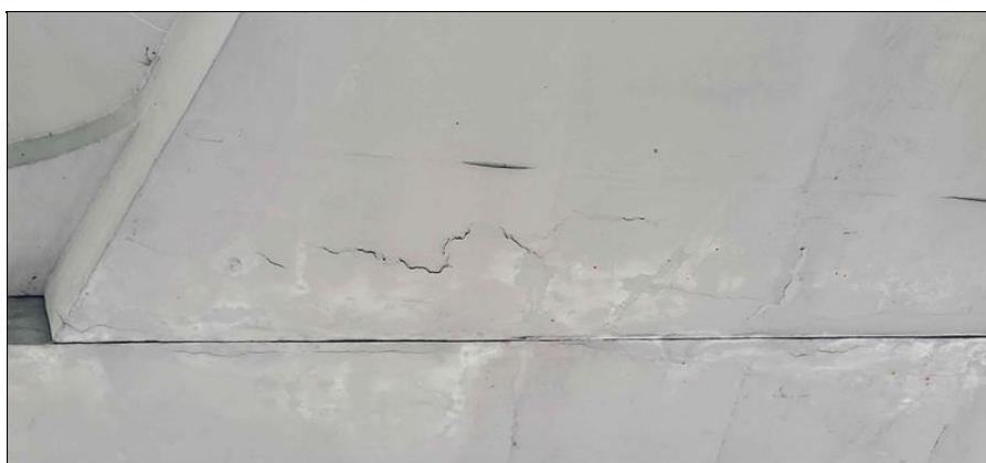
Ozub 3 - separace betonu podél spáry
