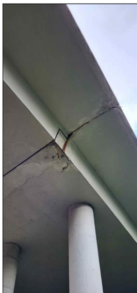
Ozub 4 - detail poškození
