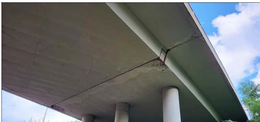
Ozub 4 - detail poškození
