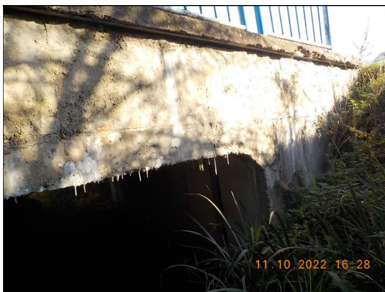
Čelo mostu vlevo.
