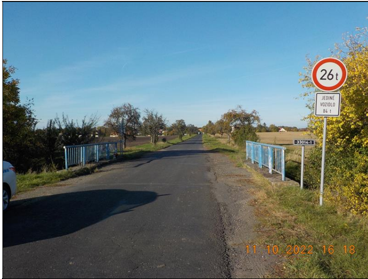
Pohled ve směru staničení.
