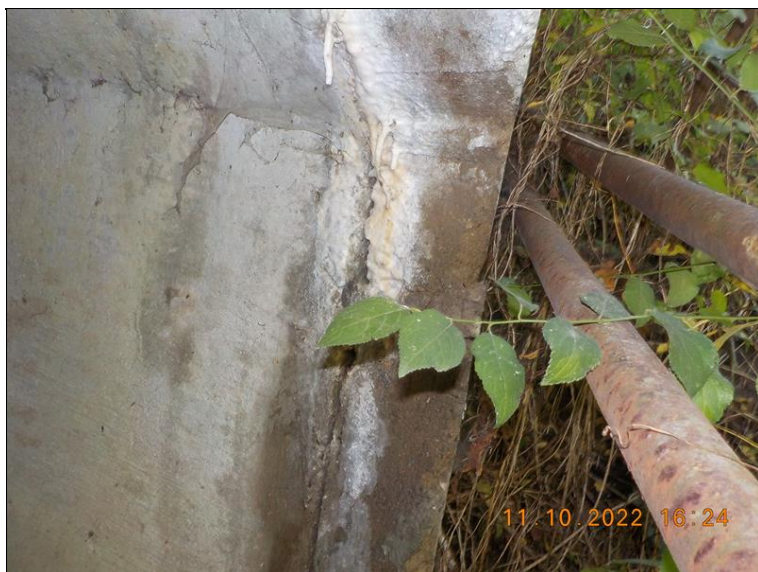
Okraj opěry 2 vpravo.
