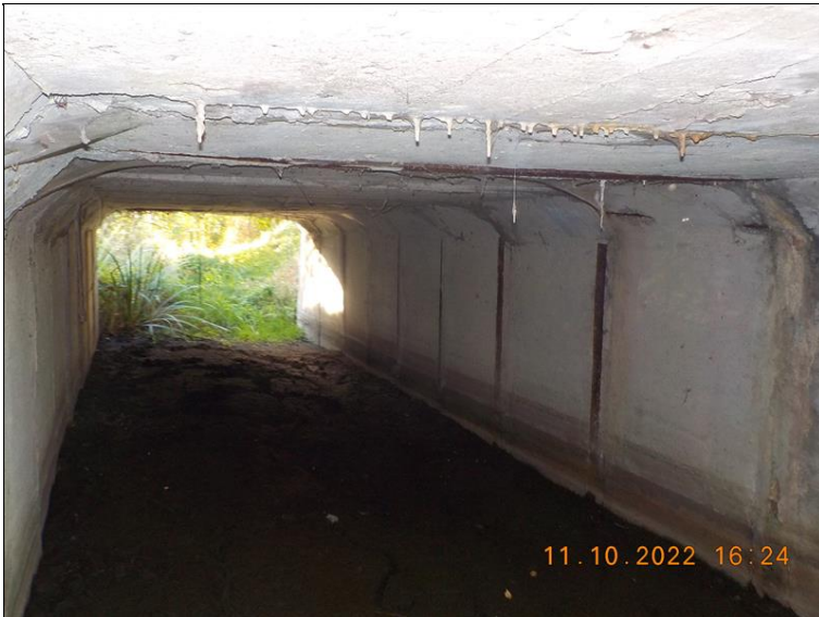
Podhled NK zprava.
