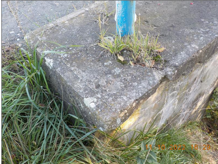
Římka vlevo u opěry 2.
