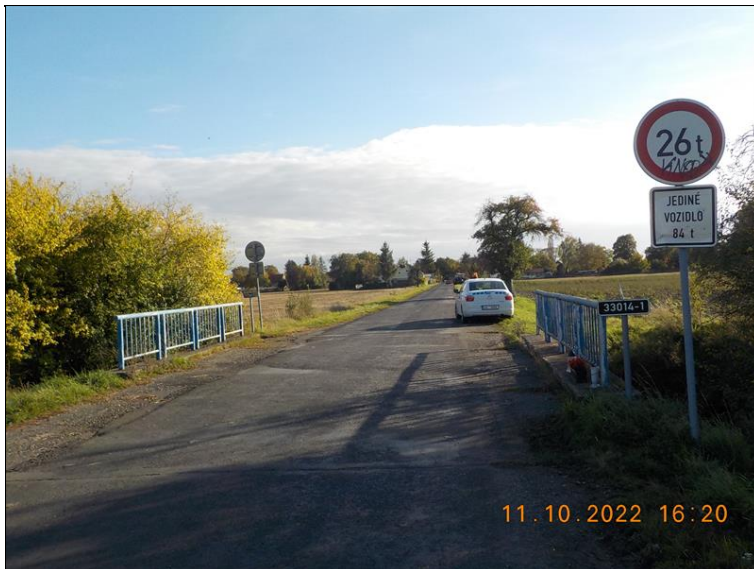
Pohled proti směru staničení.
