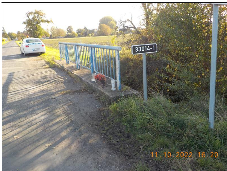
Levá strana mostu.
