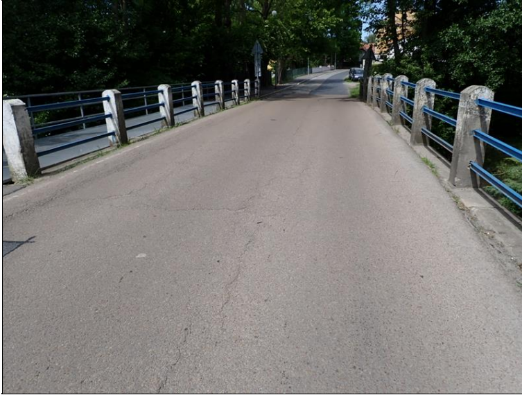
Vozovka na mostě.
