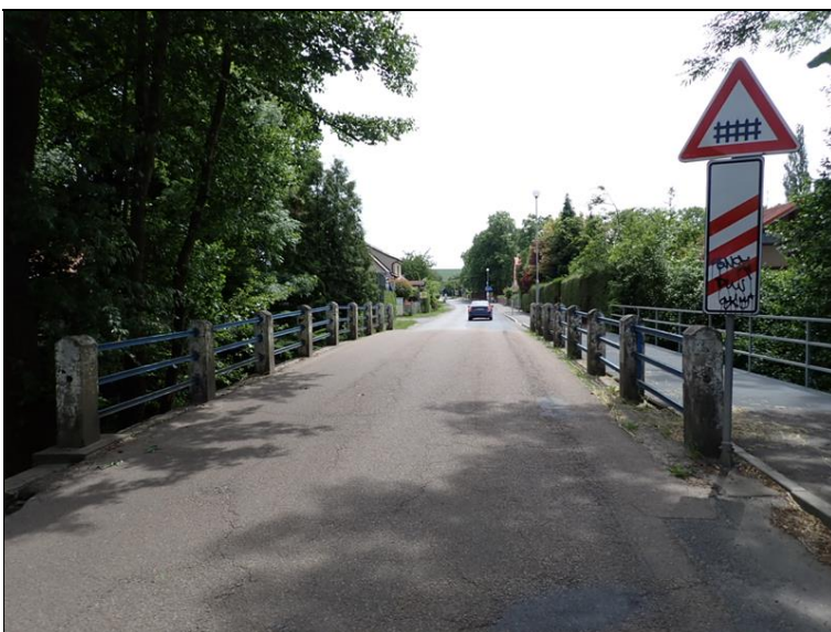
Pohled na most proti směru staničení.
