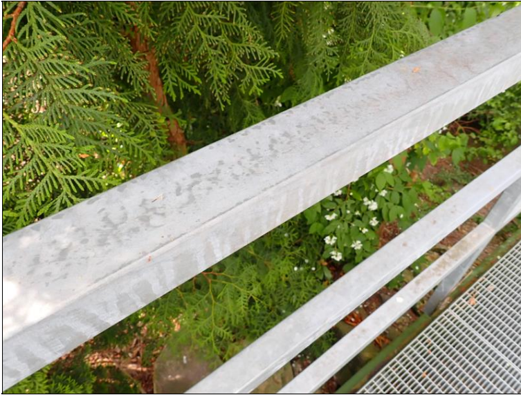
Zábradlí vlevo na lávce.
