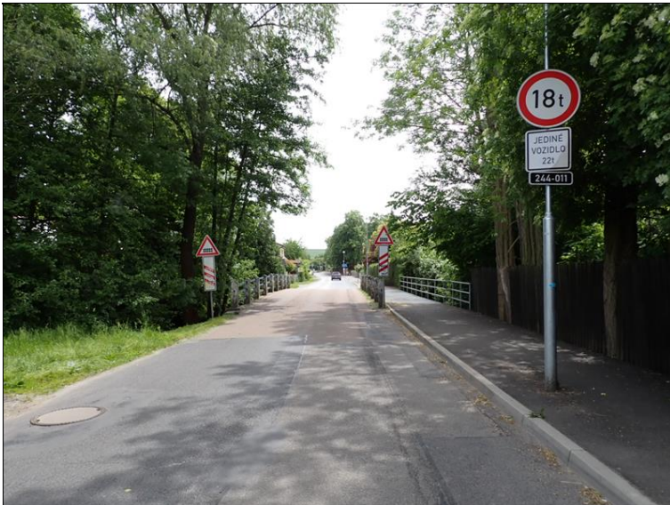
Pohled na most proti směru staničení.
