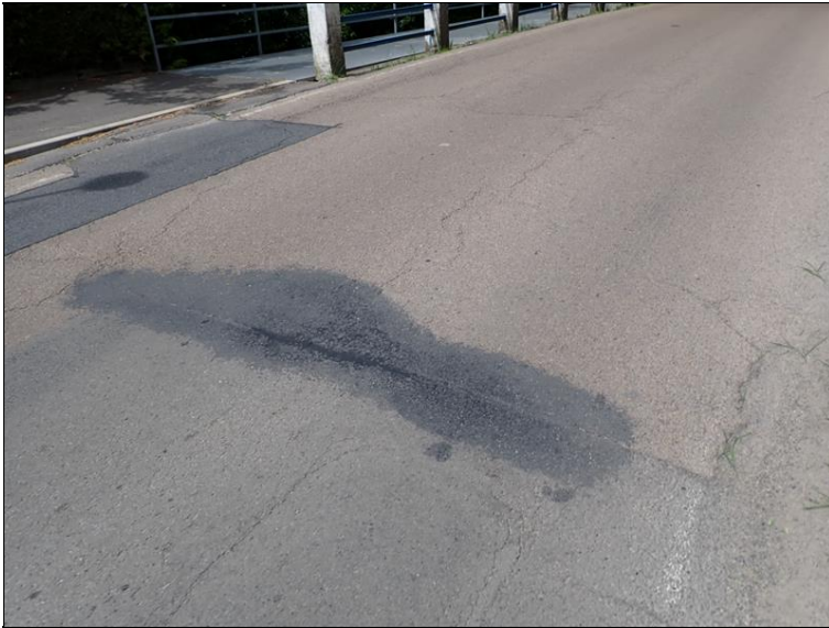
Vozovka před mostem.
