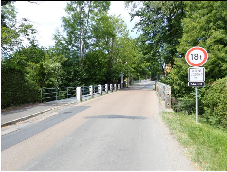
Pohled na most ve směru staničení.
