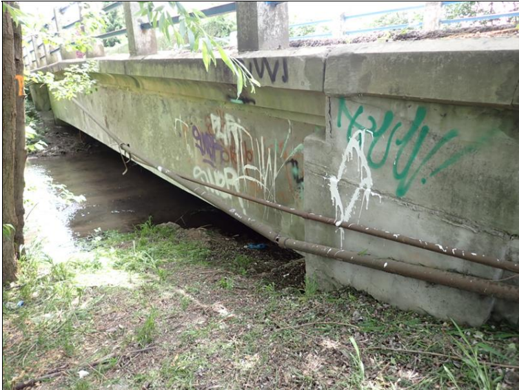
Pohled na most zprava.
