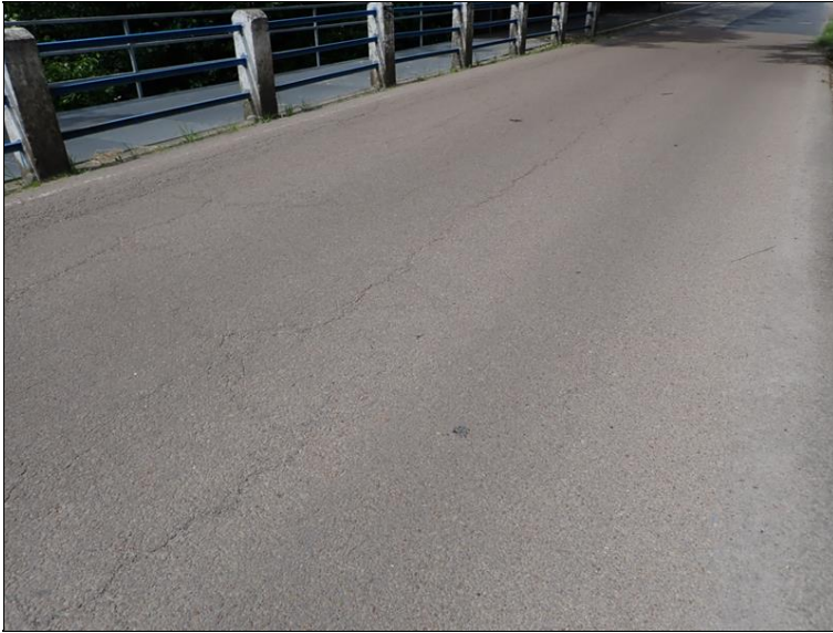
Vozovka na mostě.
