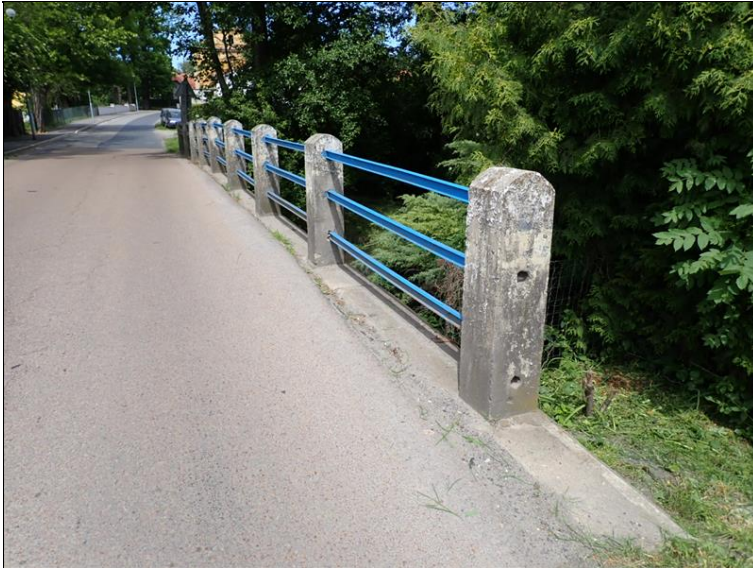
Okraj mostu vpravo.
