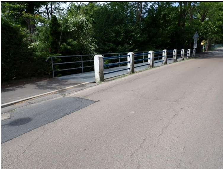
Okraj mostu vlevo.
